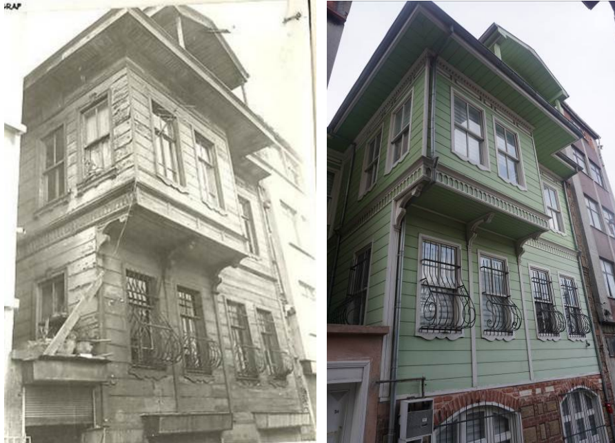
Şekil 4.63 : Süleymaniye Mahallesi, 461 Ada 4 Parsel Arşiv ve 2017 Yılı Fotoğrafi
