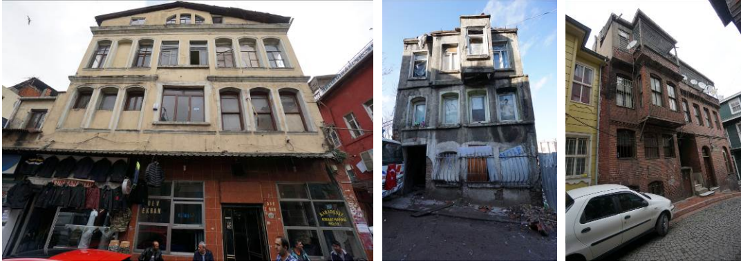
Şekil 4.57 : Hoca Gıyasettin Mahallesi Yığma Sivil Mimarlık Örnekleri
