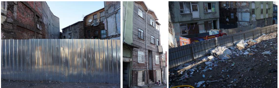
Şekil 4.98 : Tescilli, 502 Ada 6, 5, 3 Parsel, 503 Ada 5 Parsel Güncel Fotoğrafi
