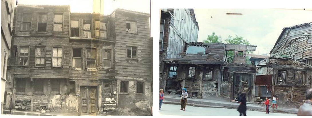
Şekil 4.54 : Molla Hüsrev Mahallesi, 659 Ada 18 Parsel Arşiv Fotoğrafları
