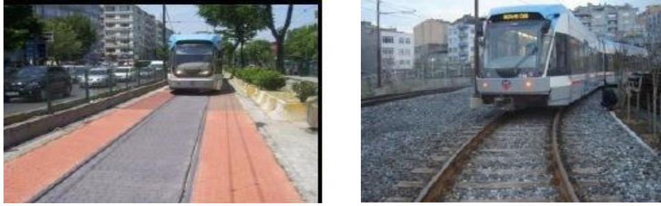
Şekil 1: Sırasıyla Oluklu Ray Tipi ve Mantar Ray Tipi (Eroglu 2014; Tarhan 2009)
