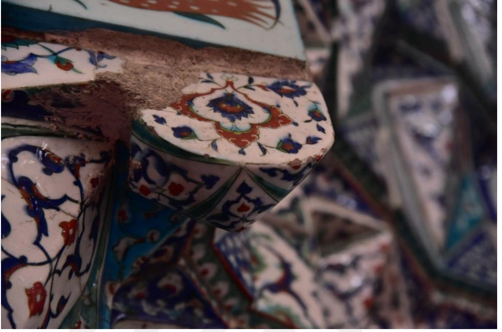
Fotoğraf 59 Mukarnasta iki kenarda yarım olarak kullanılan topuz
