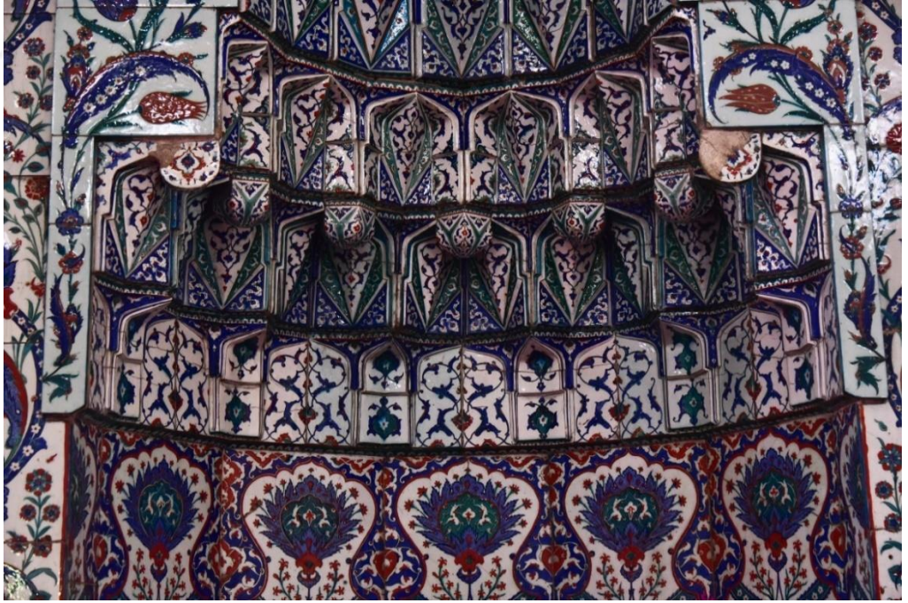
Fotoğraf 57 Mukarnash kavsara ile nişteki 35,5 cm x 35,5 cm ölçülerindeki karolar arasında kalan geçiş sırası
