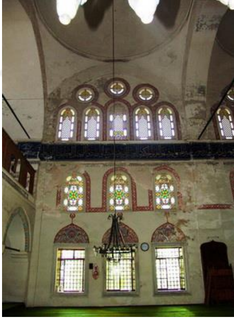
Fotoğraf 14 Restorasyon öncesi kalem işleri 129
