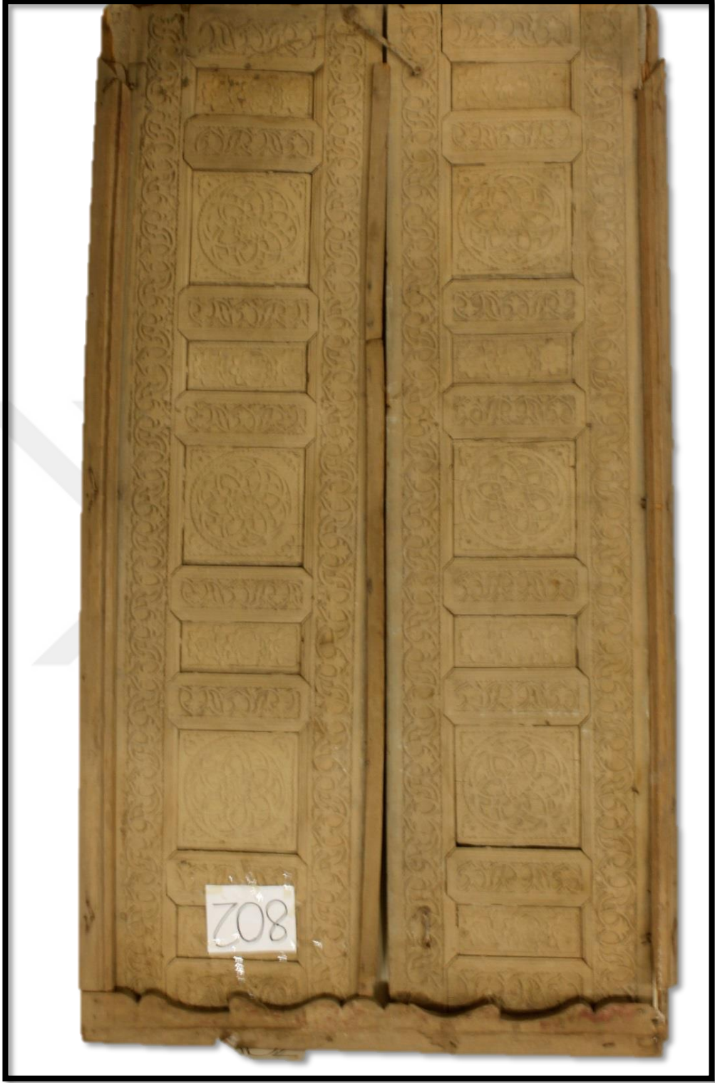
Fotoğraf No 3 : Örnek No 3'deki Pencere Kanadının Genel Görünüşü
