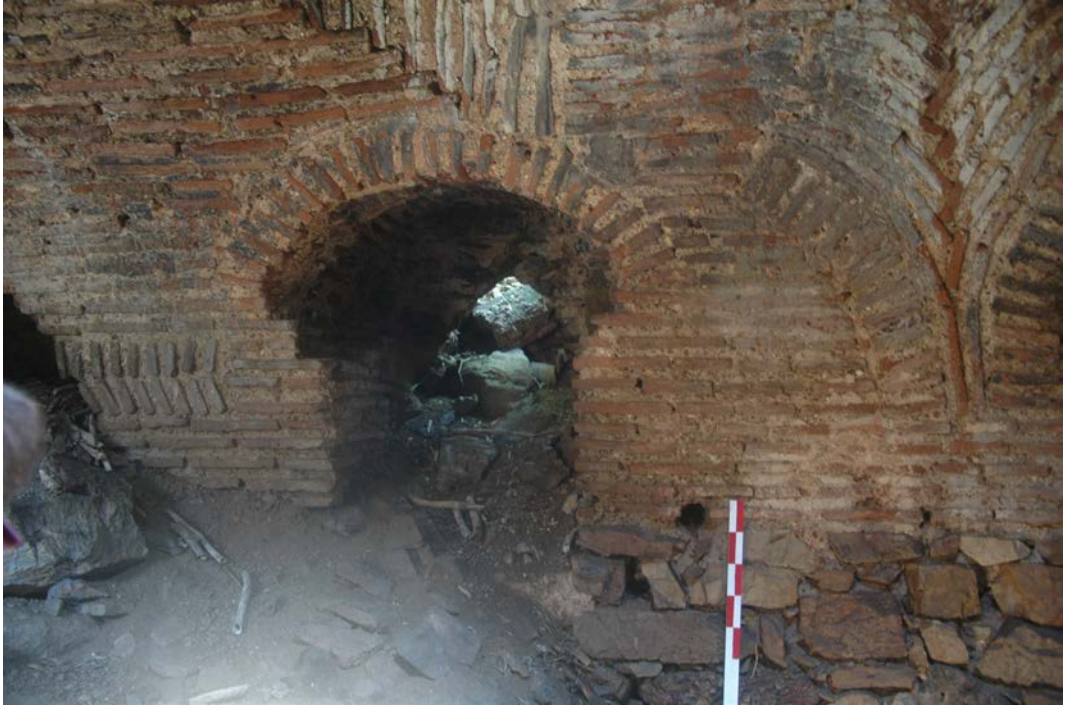
Resim 64 – Kuzey duvarındaki niş ve arkasındaki çöküntü.
