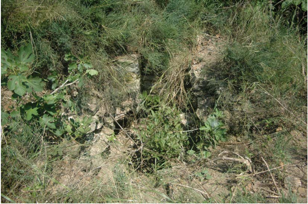
Resim 9 – Kilisenin çevresinde temel seviyesinde duvarlar.
