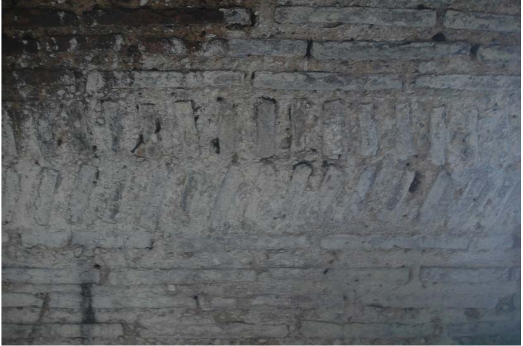
Resim 55 – Güney duvardaki balık sırtı bezeme.
