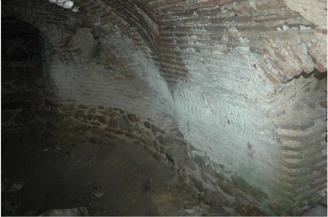
Resim 53 – Güney duvar ve balık sırtı bezeme, kuzeybatıdan görünüm.
