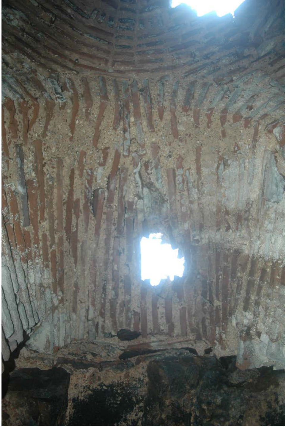
Resim 73 – Apsis nişi üzerinde çöküntü.
