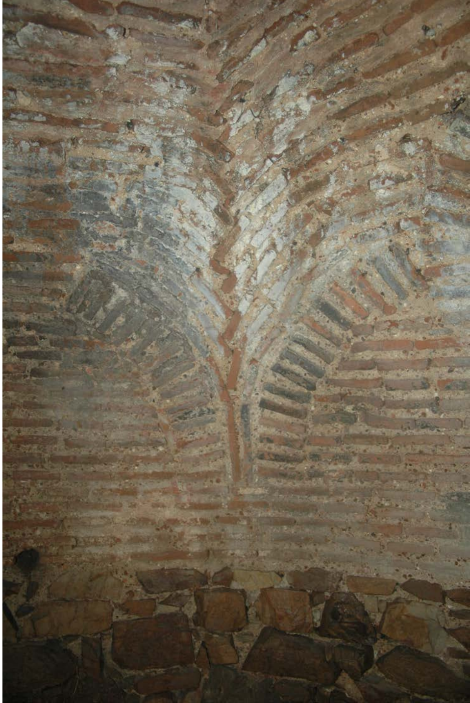
Resim 78 – Kuzey duvar ile apsis yarım yuvarlağı arasındaki üçgen geçiş örgüsü.
