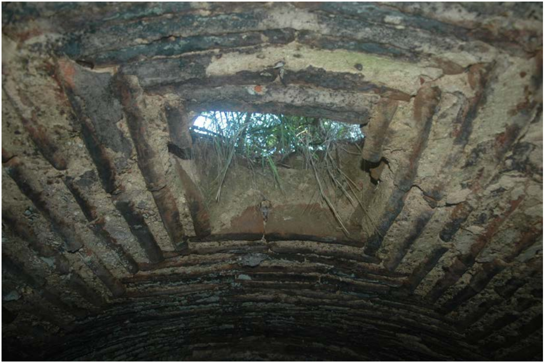
Resim 95 – Altyapıyı örten tonoz sistemi ortasında kare açıklık.
