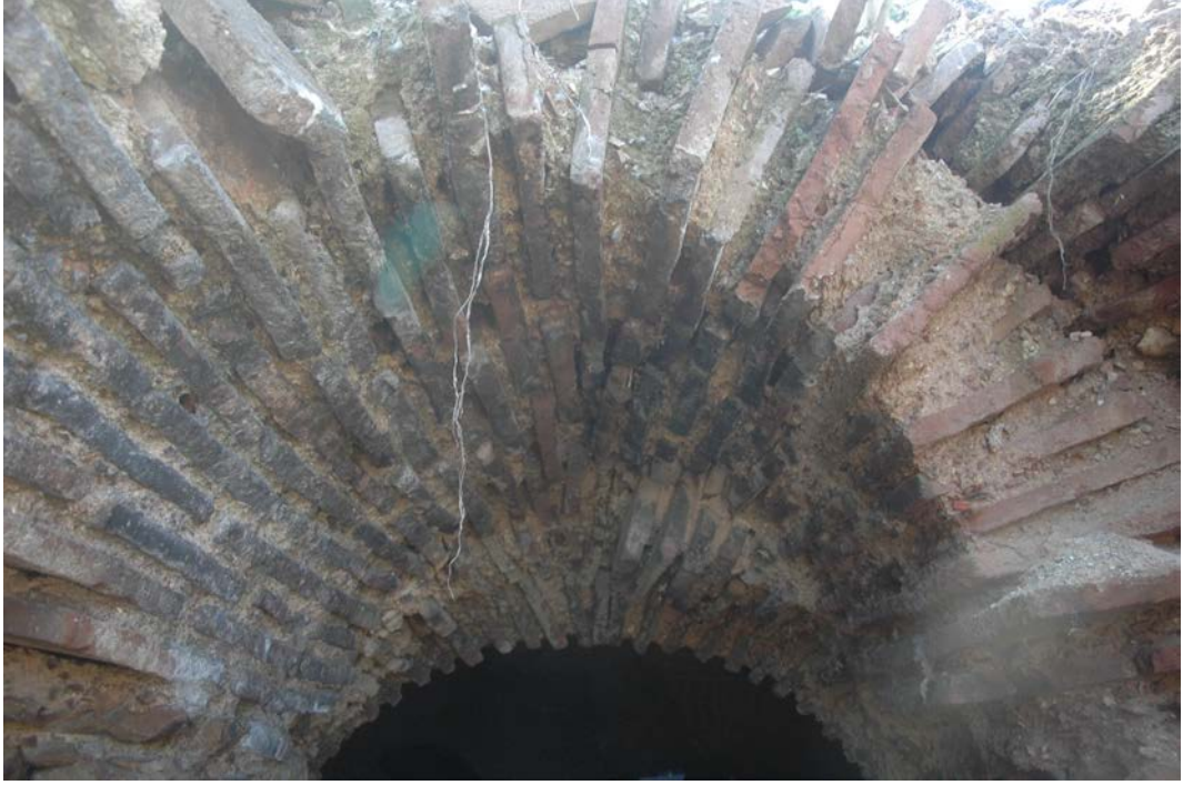
Resim 43 – Kilise alt yapısı girişi, tonoz örtü.
