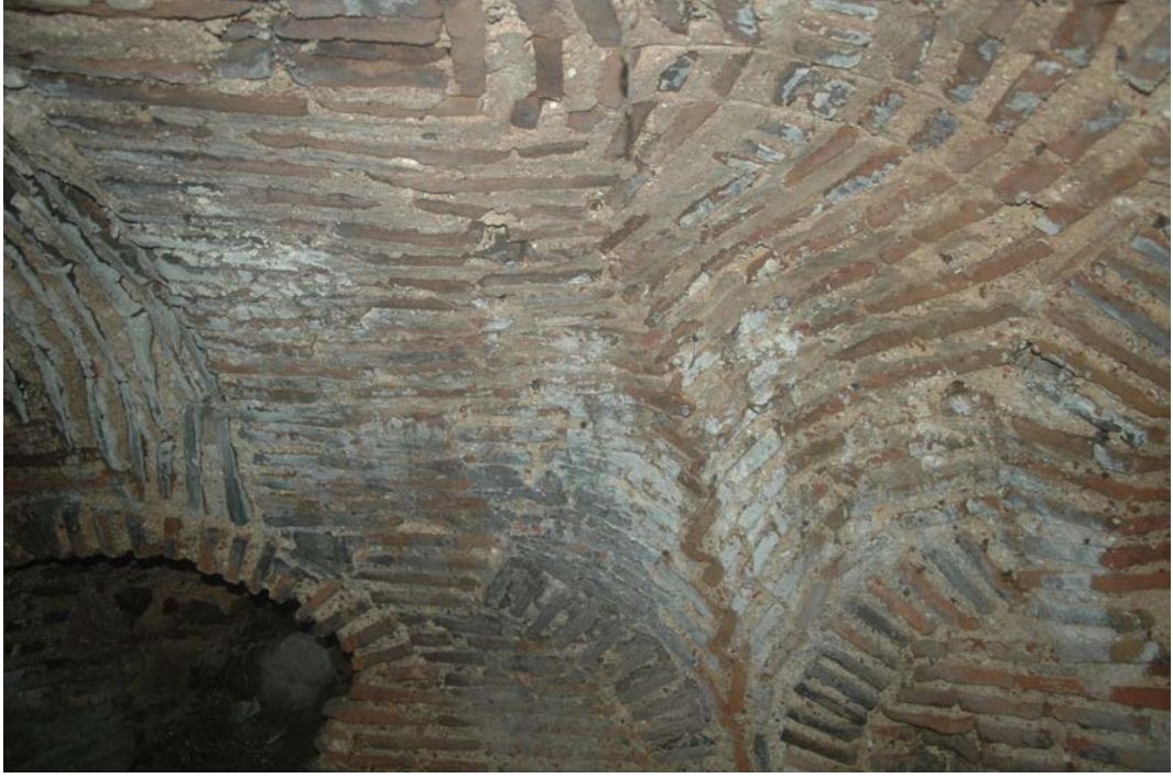
Resim 79 – Kuzey duvar ile apsis yarım yuvarlağı arasındaki üçgen geçiş örgüsü.
