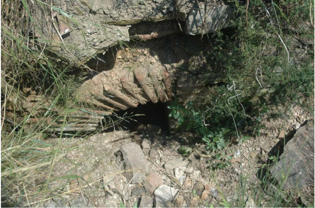
Resim 103 – Kuzey yarım tonozlu mekan, batıdan görünüm.
