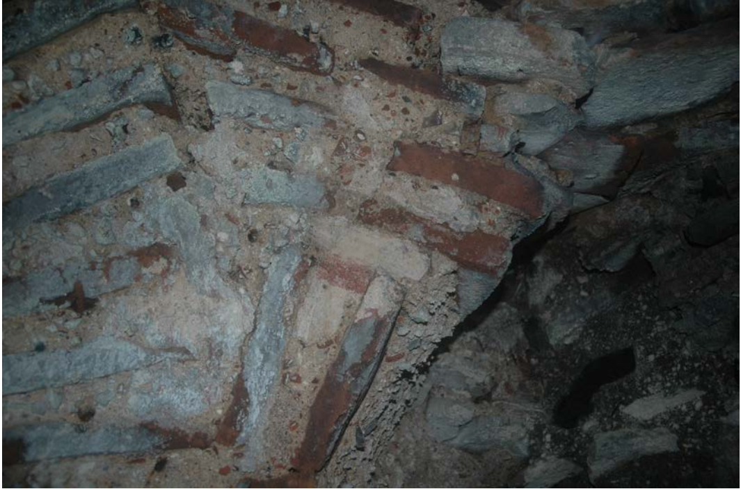
Resim 83 – Apsis nişinin güney yönünde yıkılmış üçgen örgünün varlığını gösteren yarım kemer başlangıcı.
