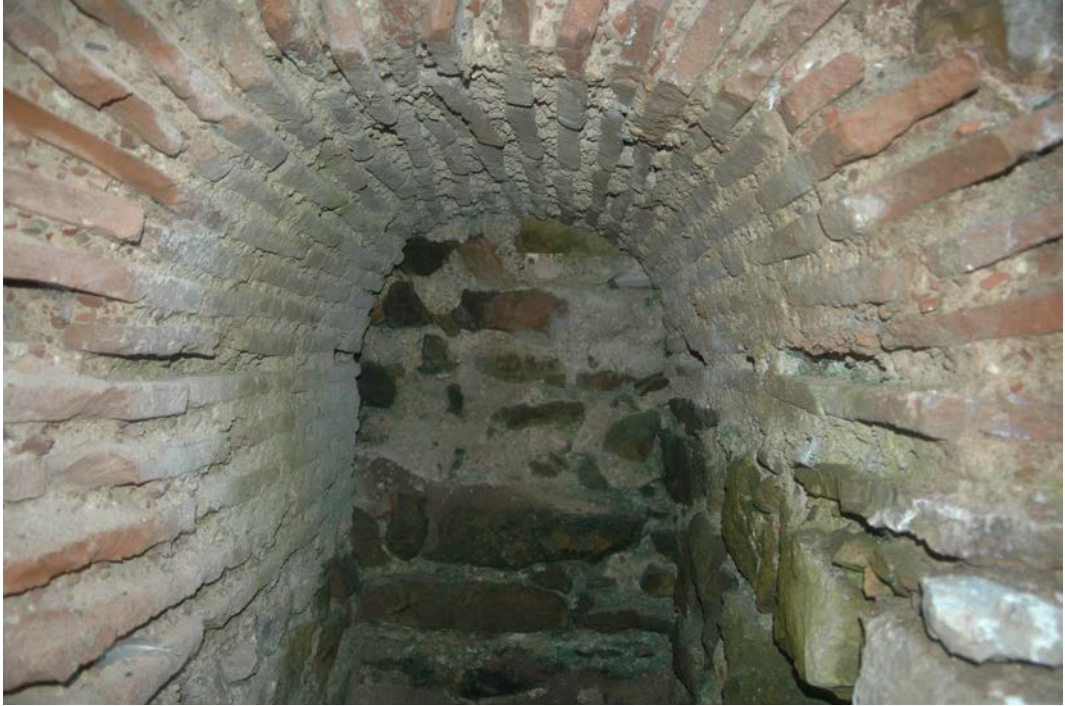
Resim 46 – Kilise alt yapısı girişinin yanındaki tonozlu mekan.
