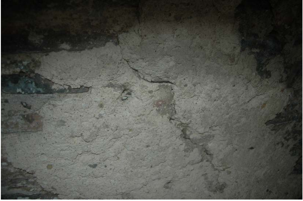
Resim 88 – Kalın pembe sıva tabakası.
