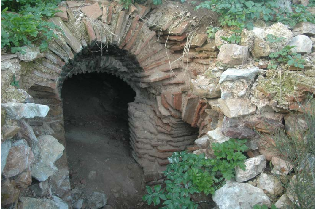
Resim 44 – Kilise alt yapısı girişi, ve yanındaki tonozlu mekan, güneyden görünüm.
