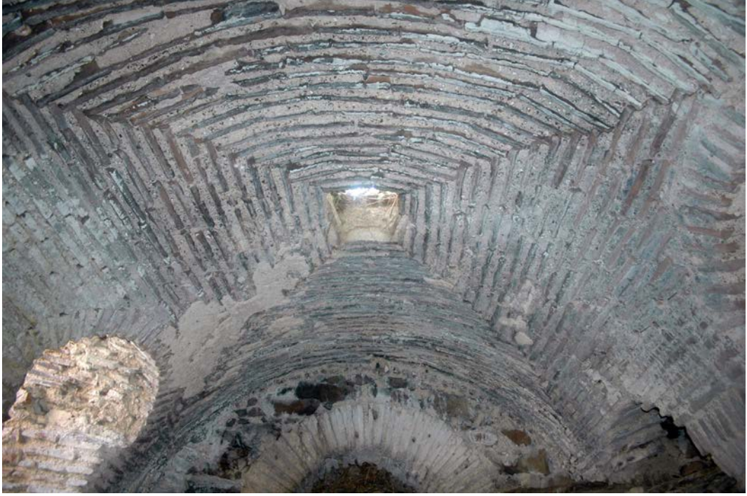
Resim 94 – Altyapıyı örten tonoz sistemi.
