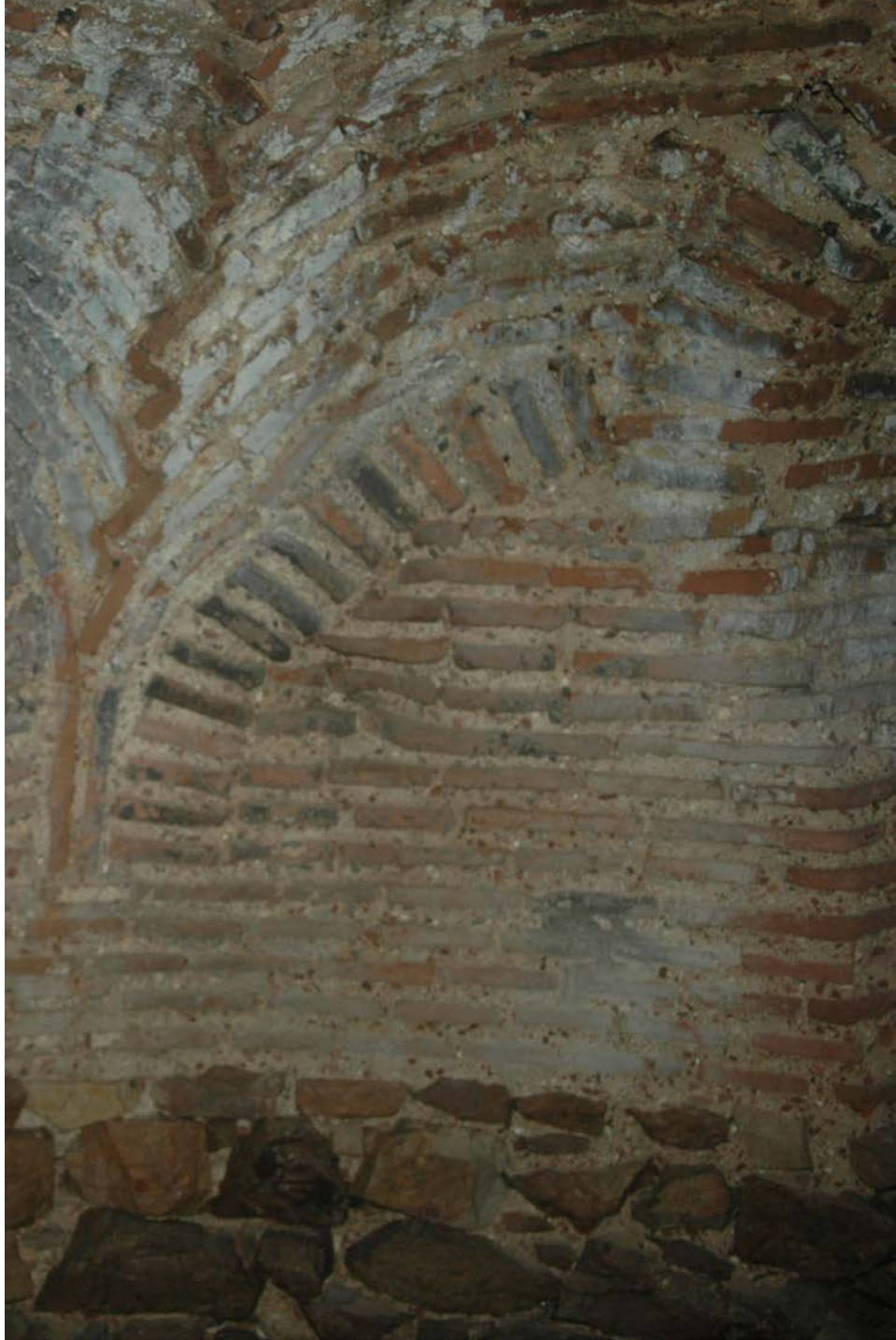
Resim 80 – Kuzey duvar ile apsis yarım yuvarlağı arasındaki üçgen geçiş örgüsü, apsis nişine yaslanan yarım kemer.
