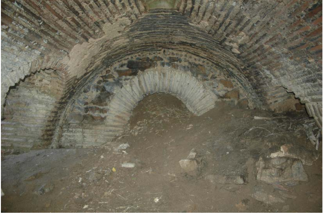
Resim 57 – Batı duvarı, dođu kuzeydođudan görünüm.
