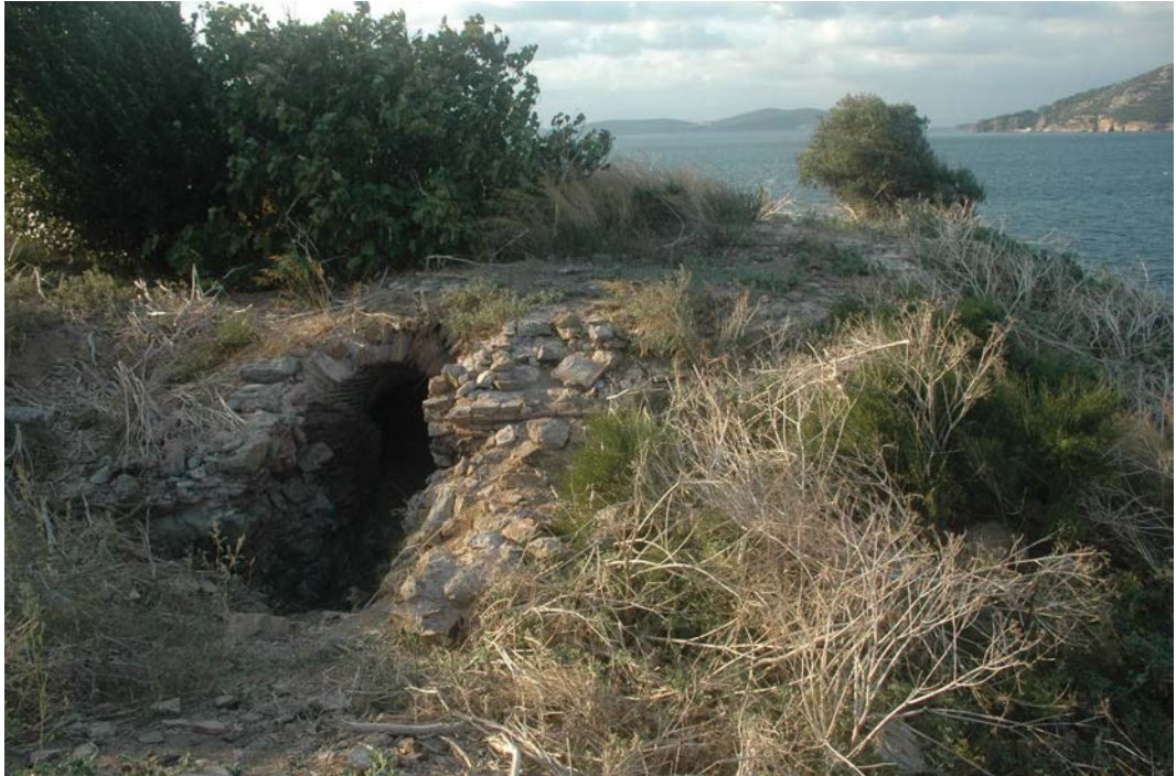
Resim 7 – Kilise altyapısının ağustos ayında üzerindeki bitki örtüsü kurumuş durumu.
