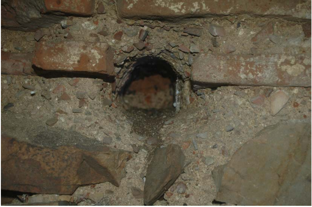
Resim 67 – Kuzey duvarda hatıl deliği.
