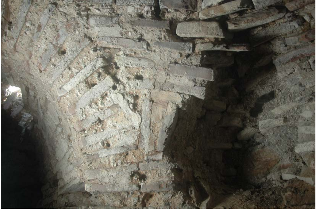
Resim 82 – Apsis nişinin güney yönünde yıkılmış üçgen örgünün varlığını gösteren yarım kemer başlangıcı.
