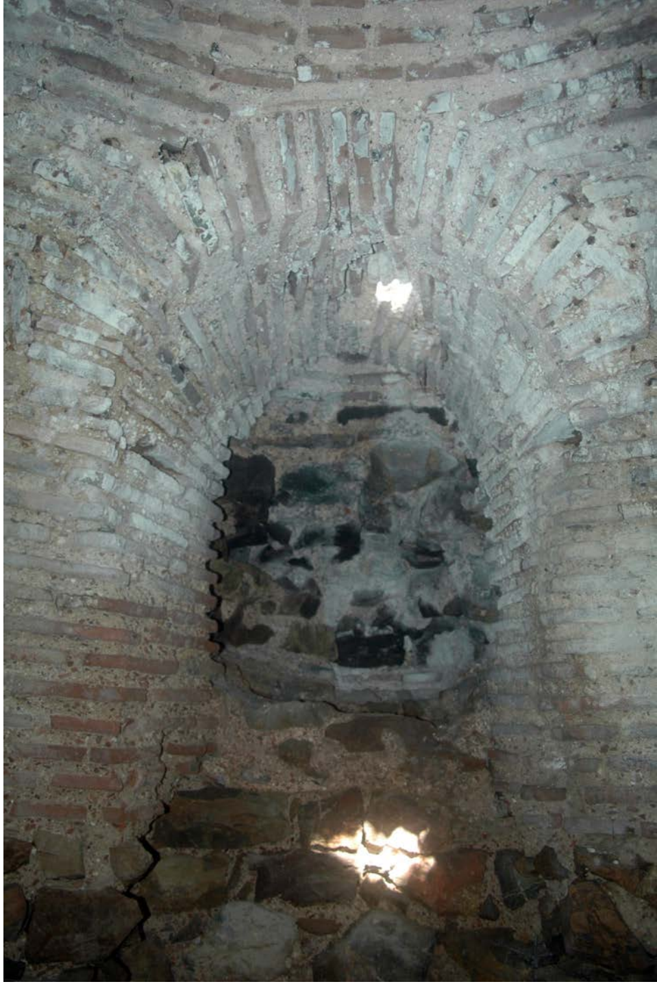
Resim 72 – Apsis nişi ve üst yapının ana apsis temeli.
