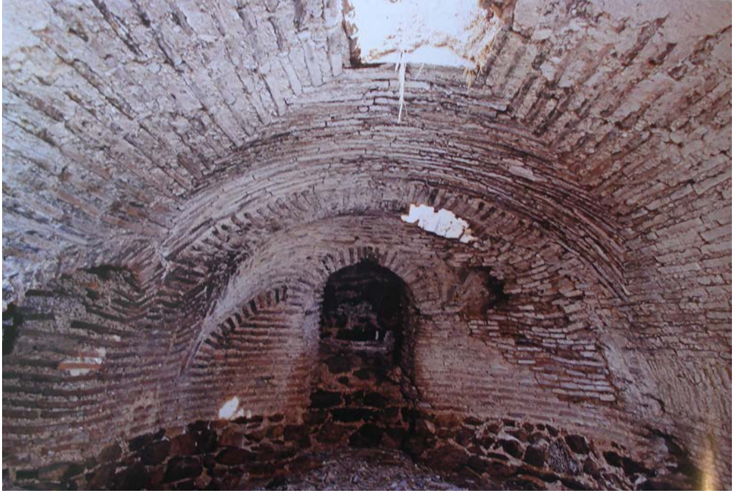
Resim 48 – Apsis nişinin sağında onarım görmüş kısım (Millas, t.y, s. 502).
