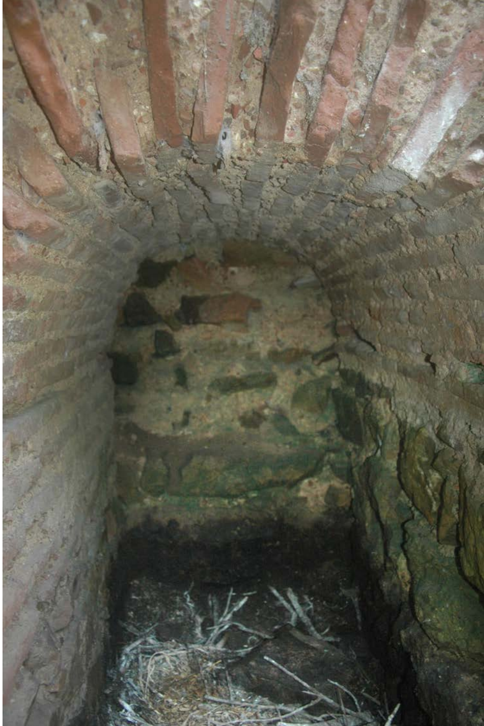
Resim 47 – Kilise alt yapısı girişinin yanındaki tonozlu mekan.
