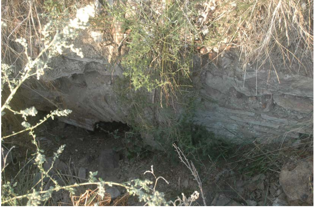
Resim 10 – Kilisenin çevresinde temel seviyesinde duvarlar.
