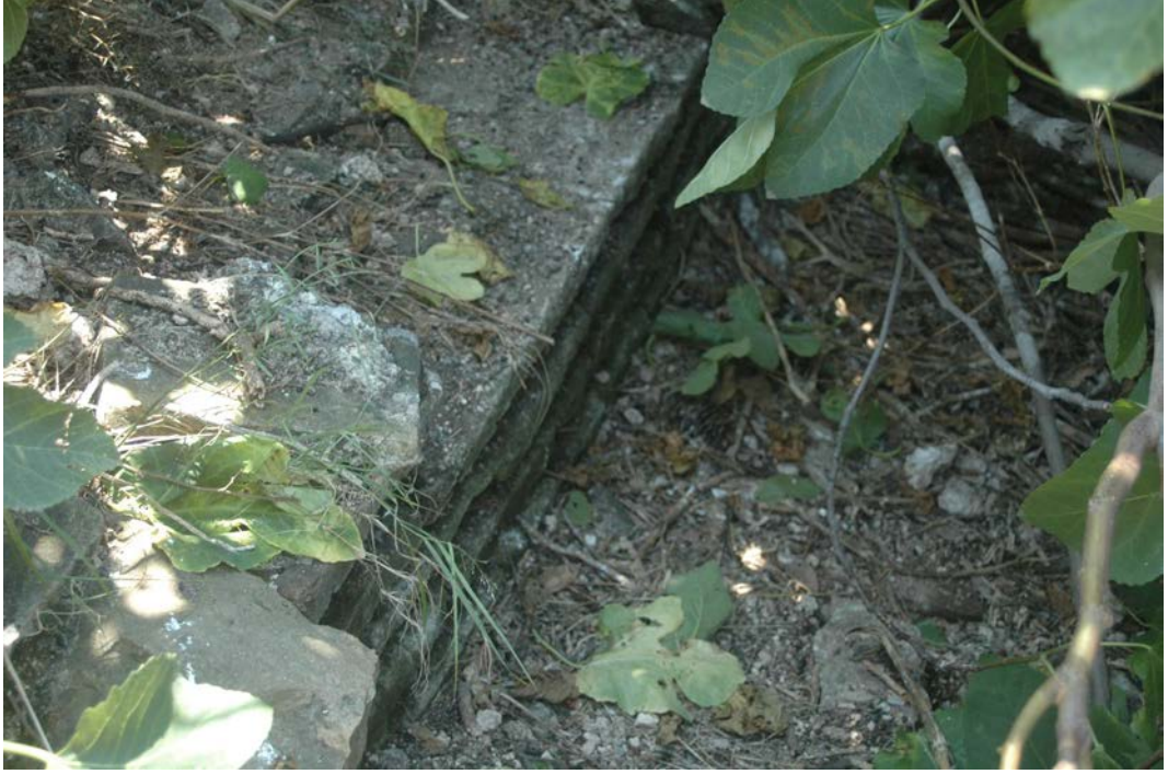
Resim 24 – Kilise üst yapısına ait duvar, kuzeydoğudan görünüm.
