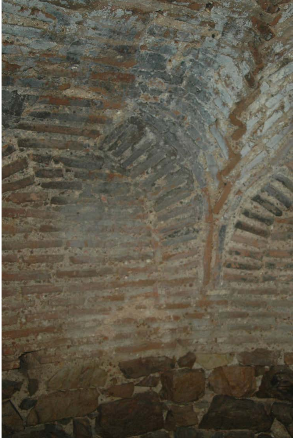
Resim 81 – Kuzey duvar ile apsis yarım yuvarlağı arasındaki üçgen geçiş örgüsü, apsis kemerine yaslanan yarım kemer.
