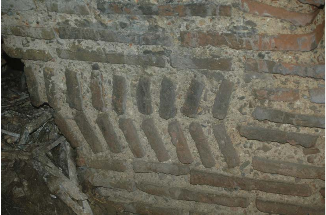
Resim 66 – Kuzey duvardaki kısmen tahrip edilmiş balık sırtı bezeme.
