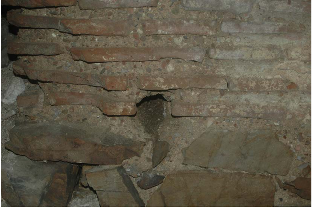
Resim 68 – Kuzey duvarda hatıl deliği.
