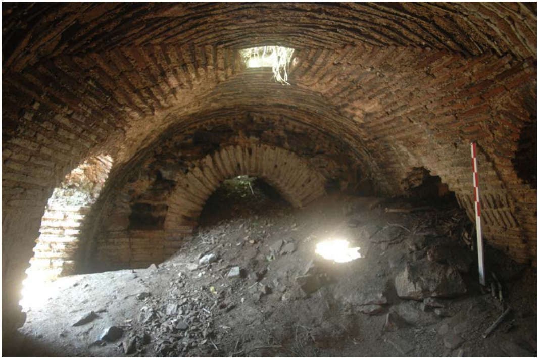
Resim 93 – Altyapıyı örten tonoz sistemi.
