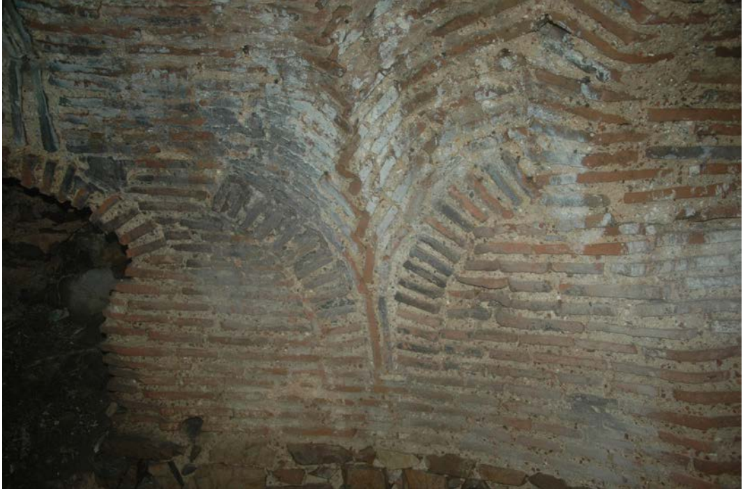
Resim 77 – Kuzey duvar ile apsis yarım yuvarlağı arasındaki üçgen geçiş örgüsü.
