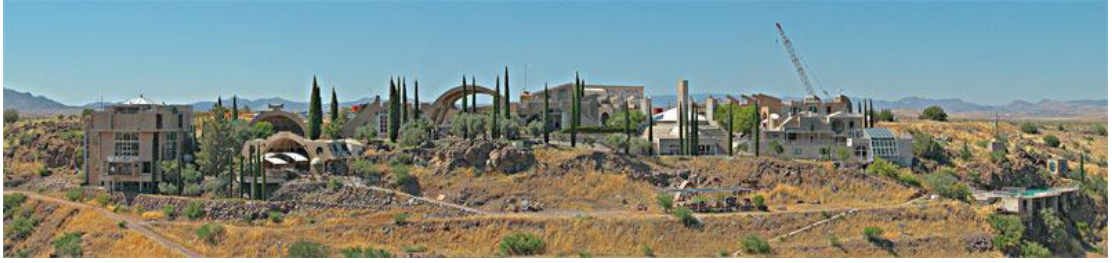
Şekil 4.6: Arcosanti Projesinin 2005 yılında inşaatı devam etmekte olan hali...
