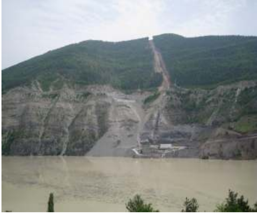
Şekil 39. Artvin ili sınırları içerisinde yapılmakta olan Erenler HES cebri boru hattı
