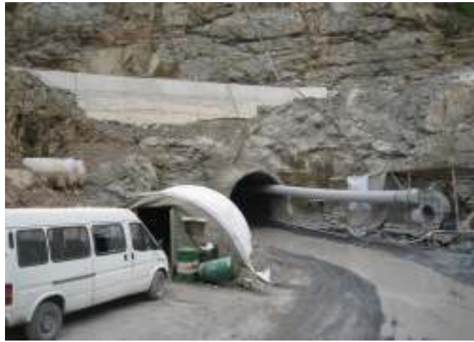
Şekil 37. Artvin ili sınırları dahilinde yapılmakta olan Erenler HES su iletim tüneli ağzı
