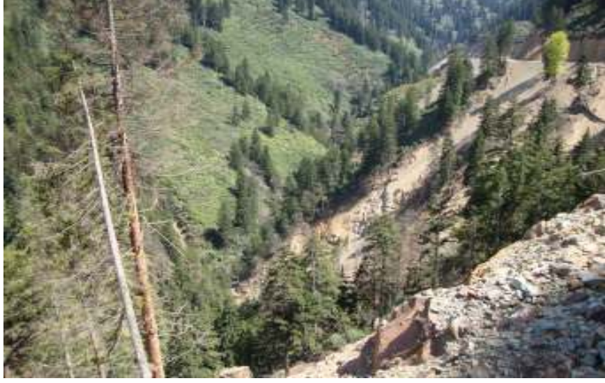
Şekil 34. Kabaca Vadisinde yapılmakta olan bir HES tesisi ulaşım yolunun geçtiğı yamaçta yapmış olduđu tahribat (Foto: M. Özalp)
