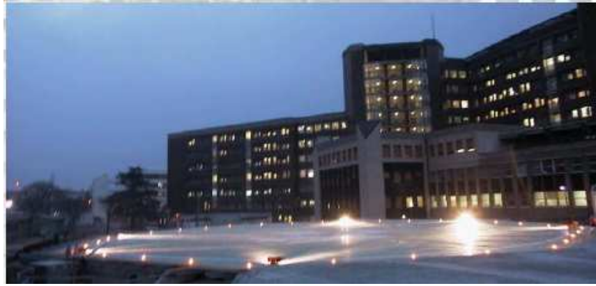
Şekil 56 Yer Seviyesi Heliport Aydınlatma
