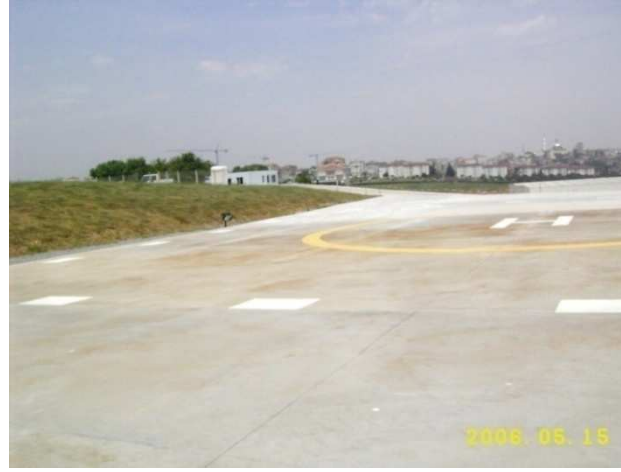
Şekil 71 Arçelik Fabrikası Tuzla
