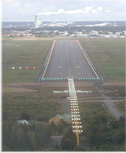
Şekil 24 Doğru açı ile inişi gösteren PAPI
