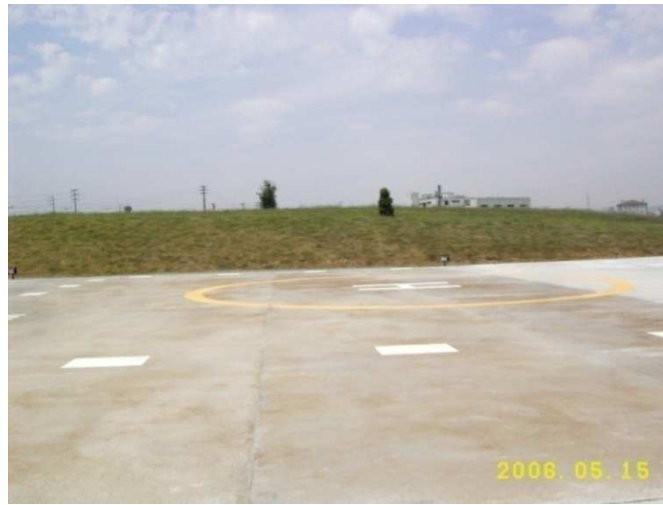
Şekil 72 (Arçelik Fabrikası Tuzla)
