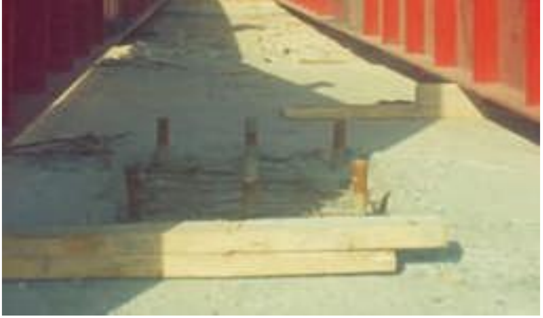
Resim 1 : Betona yerleřtirilen ankraj vidaları
