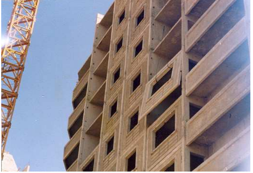
Şekil 3.7 Prefbrike cephe panelinin yerine taşınması(Korur S.)
