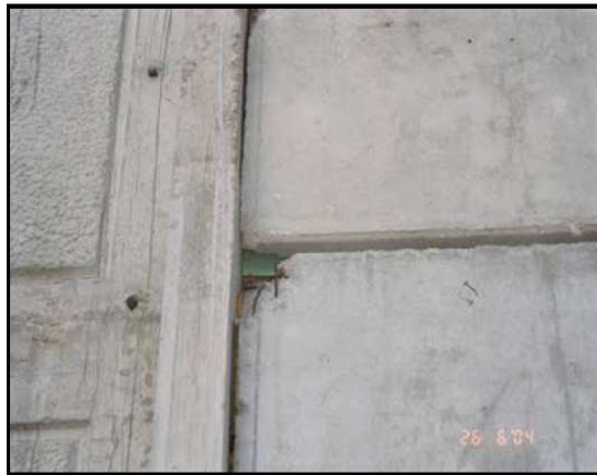
Şekil 3.8 Cephe panellerinde meydana gelen bozulmalar ve kırılmalar(Korur S.)
