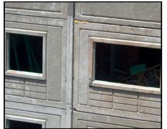
Şekil 3.8 Cephe panellerinde meydana gelen bozulmalar ve kırılmalar(Korur S.)
