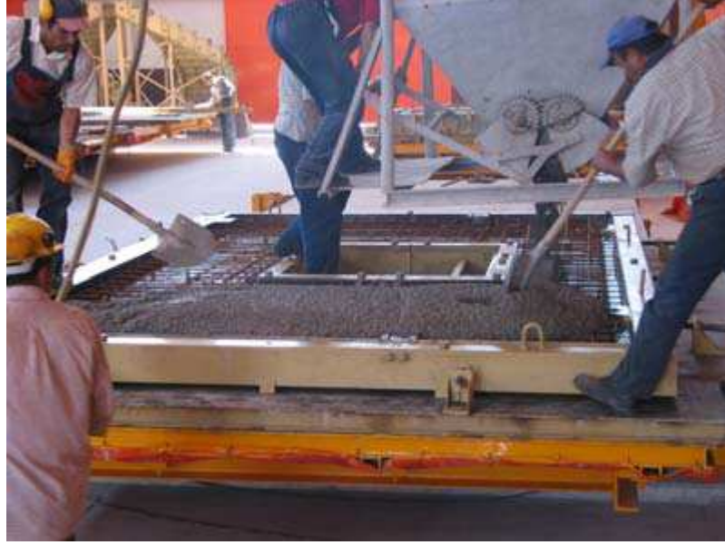
Şekil 3.6 Şantiye ortamında vibrasyonlu masada prefabrike cephe paneli üretimi (Korur S.)
