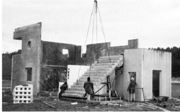
Şekil 3.3 Tek katlı panel ev (PCI Design Handbook)
