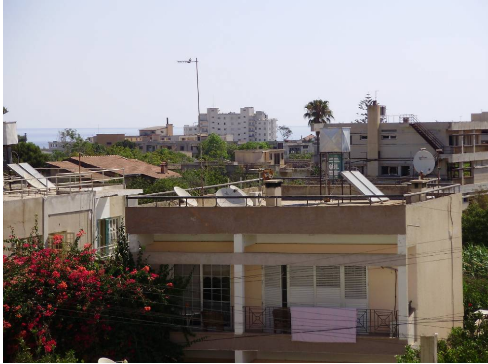
Fotoğraf 3.9. Gazimağusa Karakol Mahallesi'nden bir görünüm
