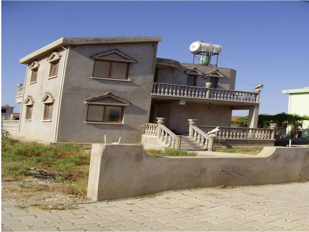
Fotoğraf 3.15. Çağdaş yapı malzemeleri ile yapılmakta olan bir ev (Tuzla Mahallesi)
