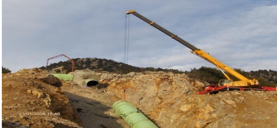
Şekil 4. Cebri boru montajı
