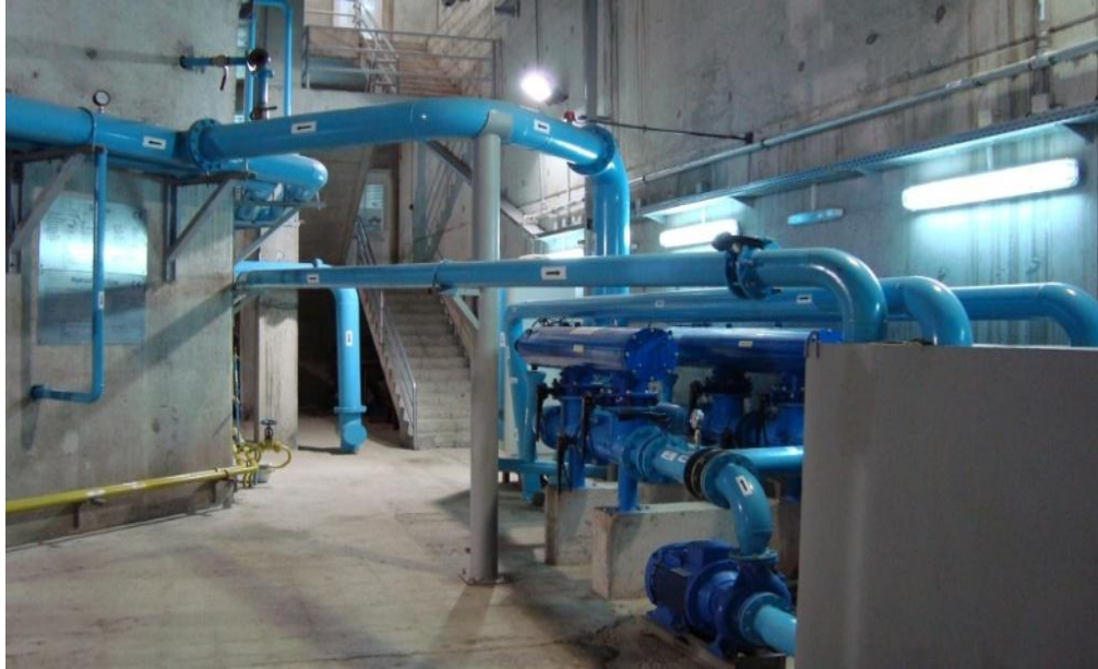
Şekil 6. Ünite soğutma sistemi
