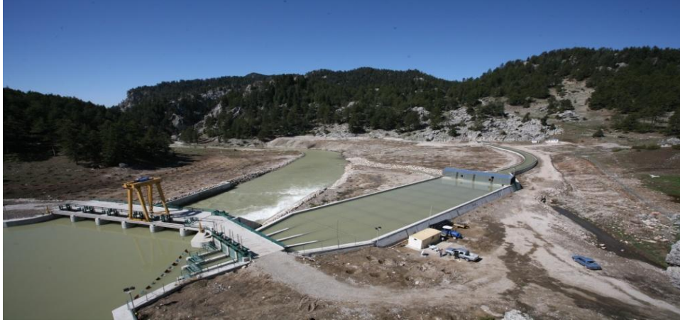
Şekil 3. Regülatör, çökeltim havuzu, açık iletim kanalı
