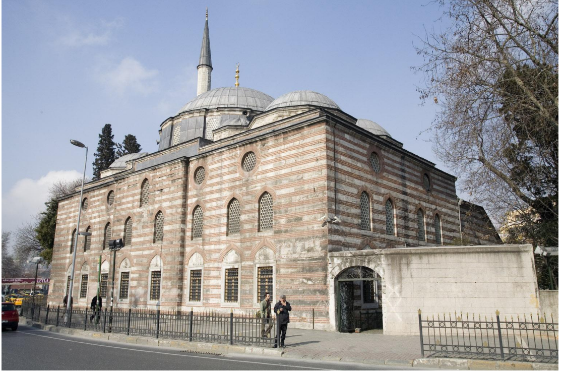
Resim 33: Sinan Paşa Camii'nin Güney ve Doğu Cephesi
