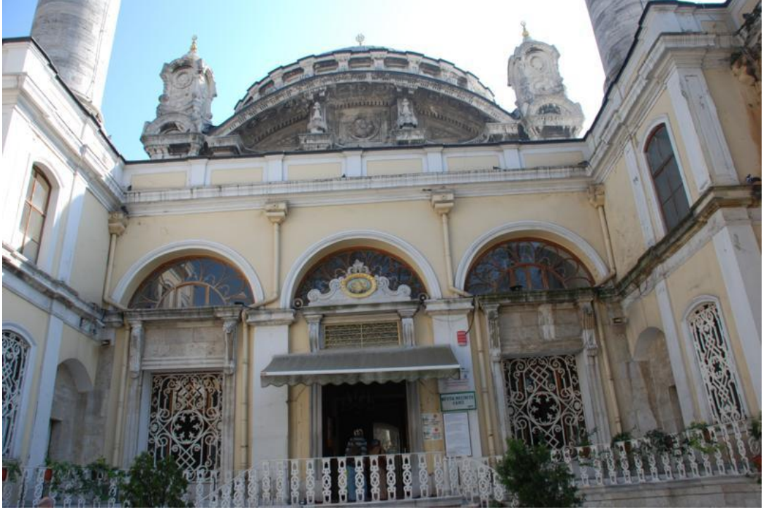
Resim 116: Ortaköy Camii Kuzey Cephesindeki Giriş Bölümü
