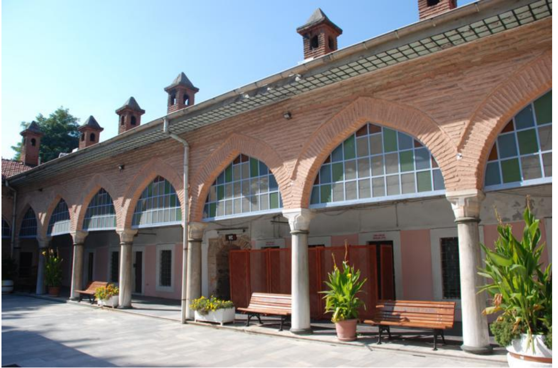
Resim 36: Sinan Paşa Camii Avlusunu “U” Biçiminde Saran Medrese Odaları
