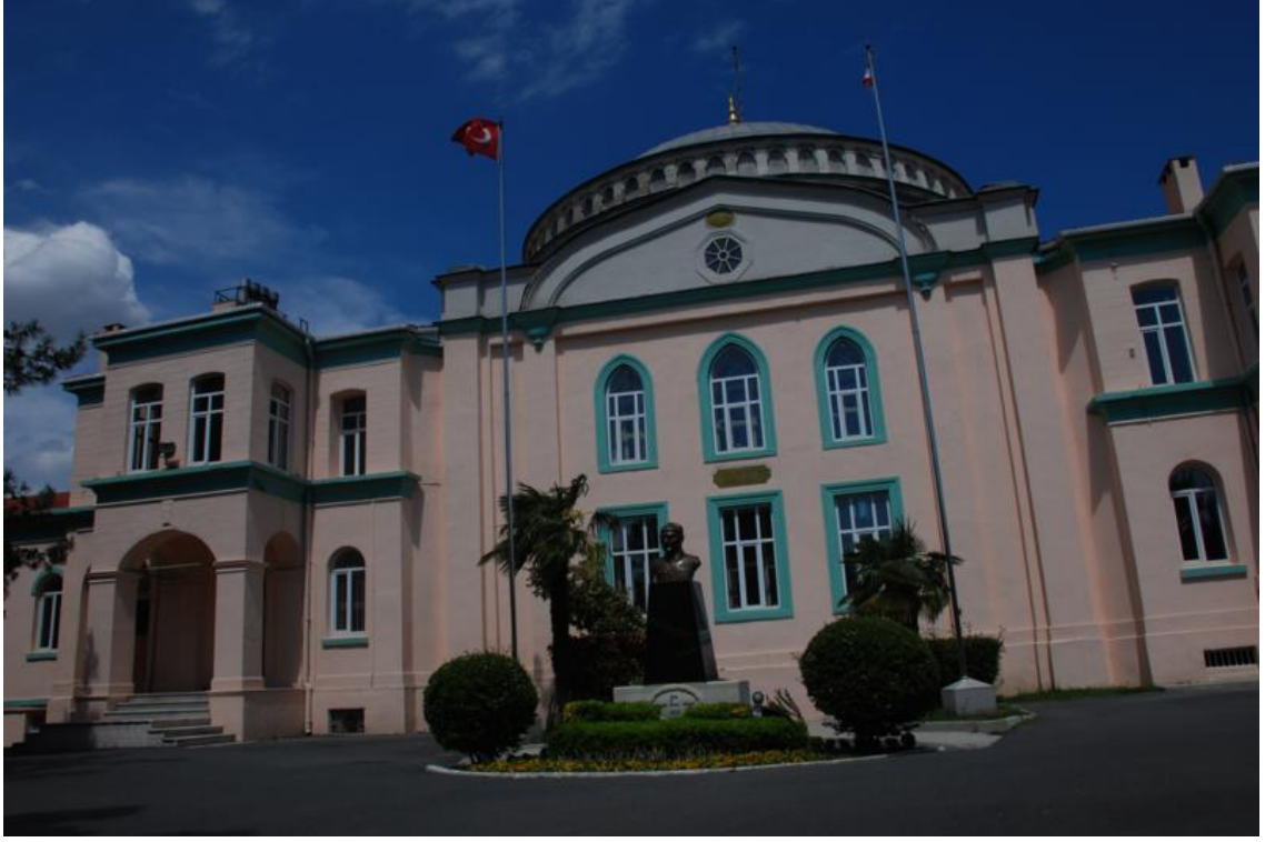
Resim 150: Orhaniye Kışlası Camii'nin Avluya Bakan Cephesi
