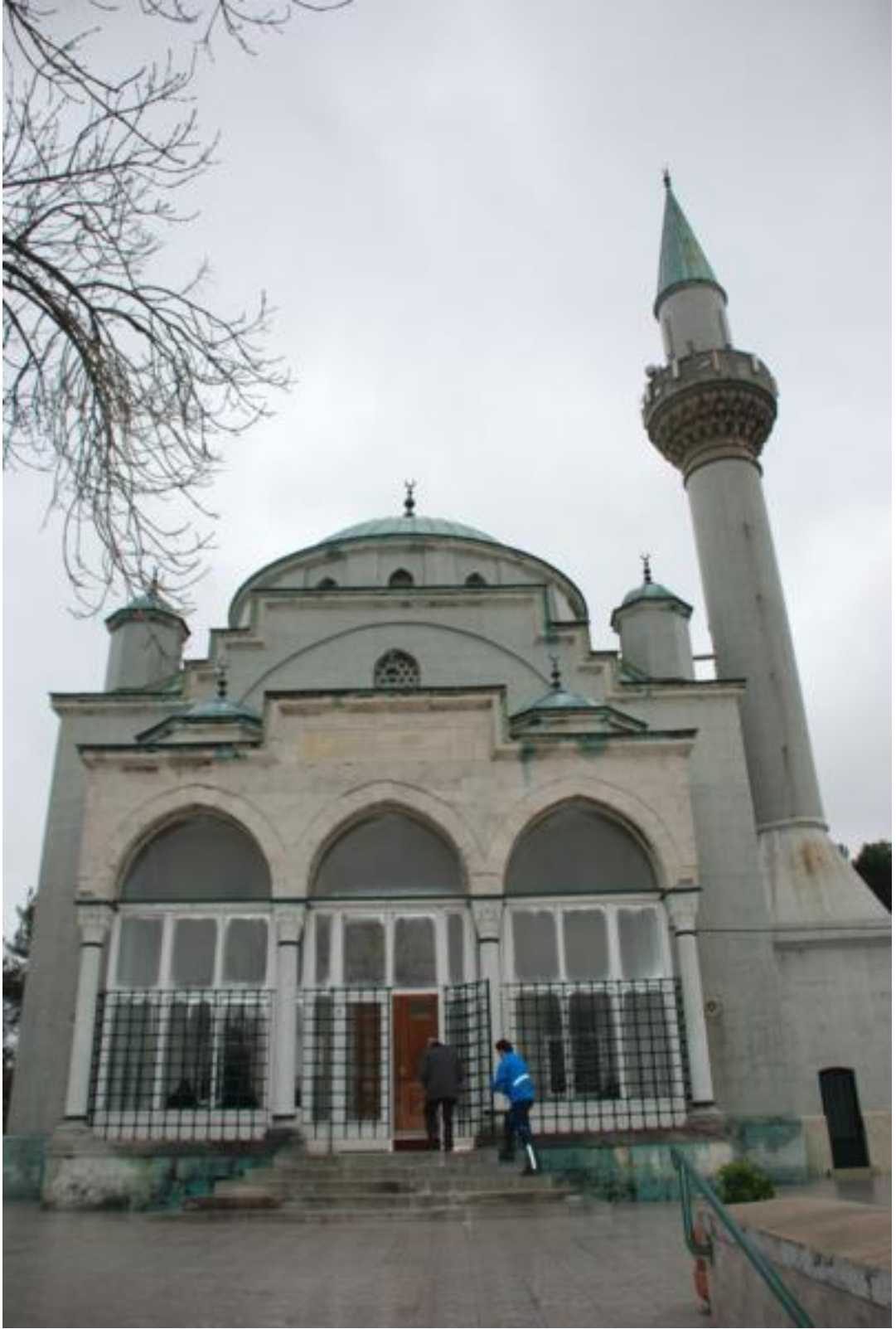
Resim 177: Levent Camii Kuzey Cephesi
