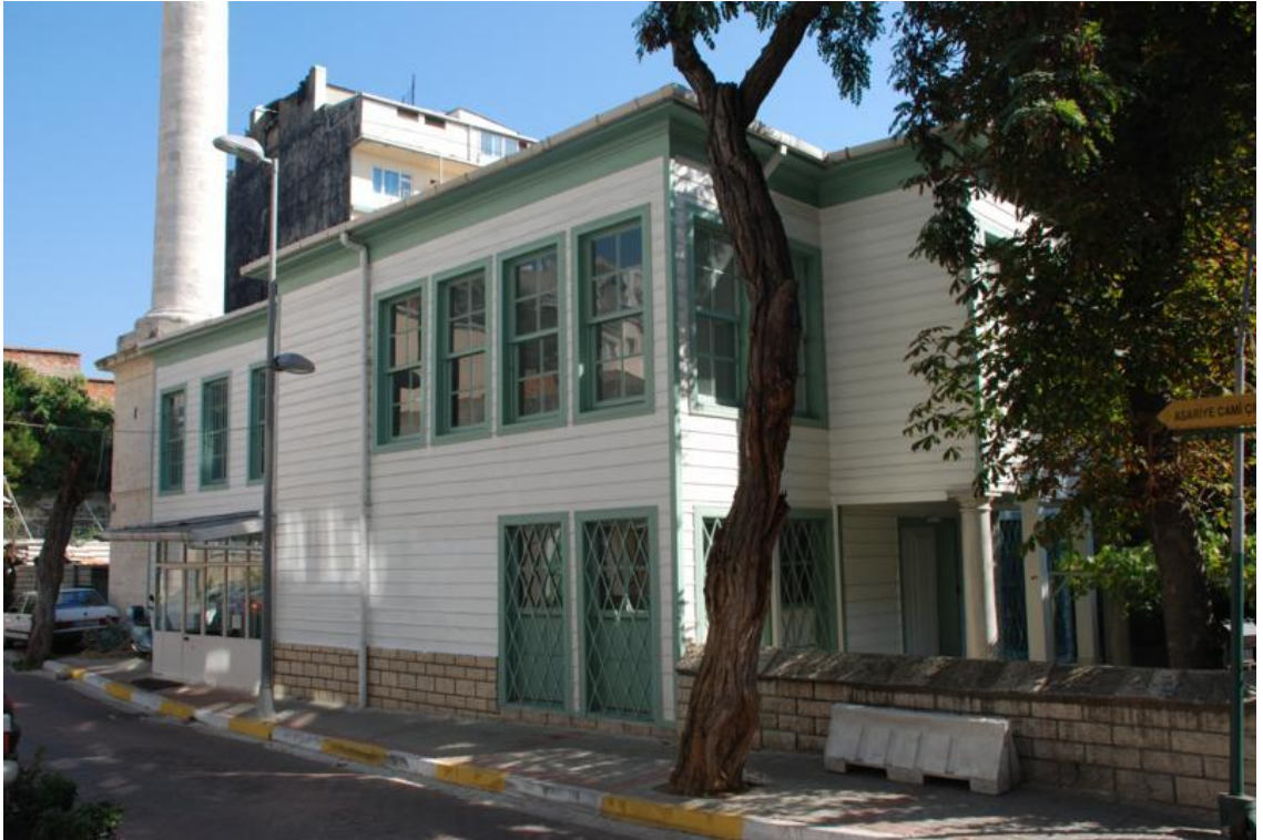
Resim 88: Âsâriye Camii Kuzey Cephesi
