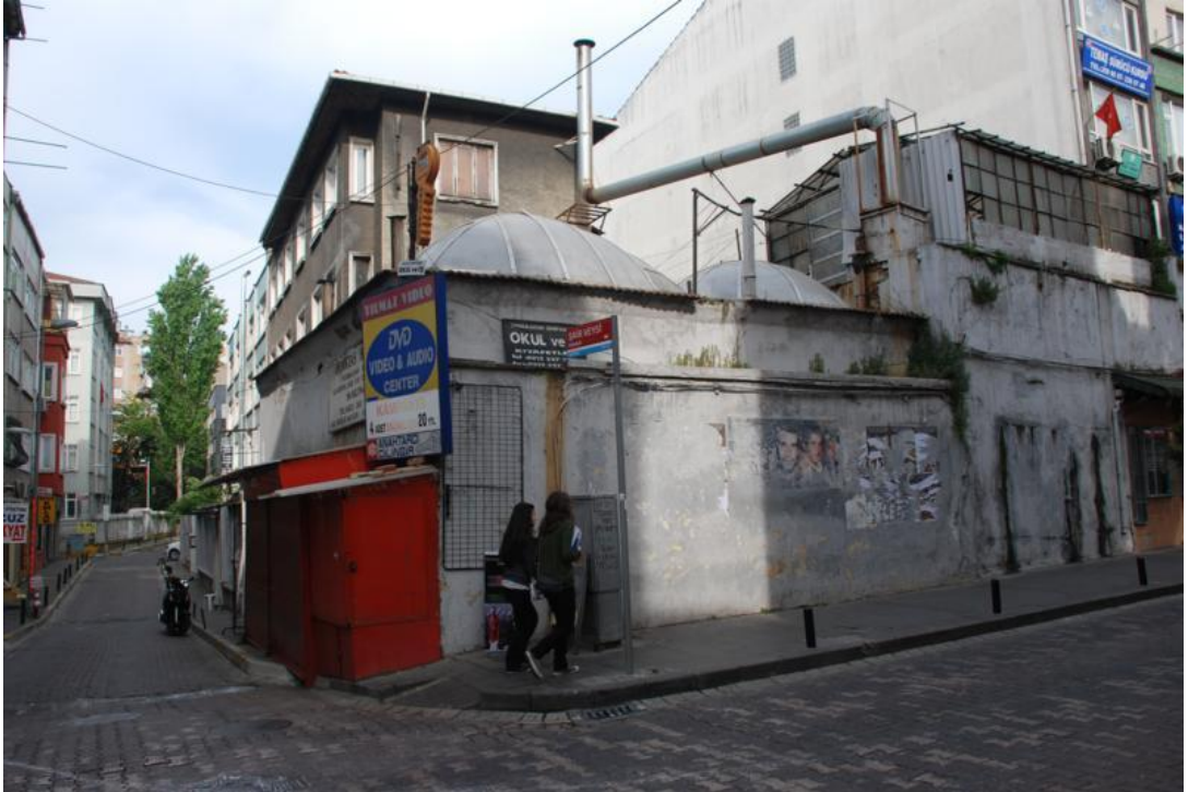
Resim 255: Köyiçi Hamamı Caddeye Bakan Bölümü
