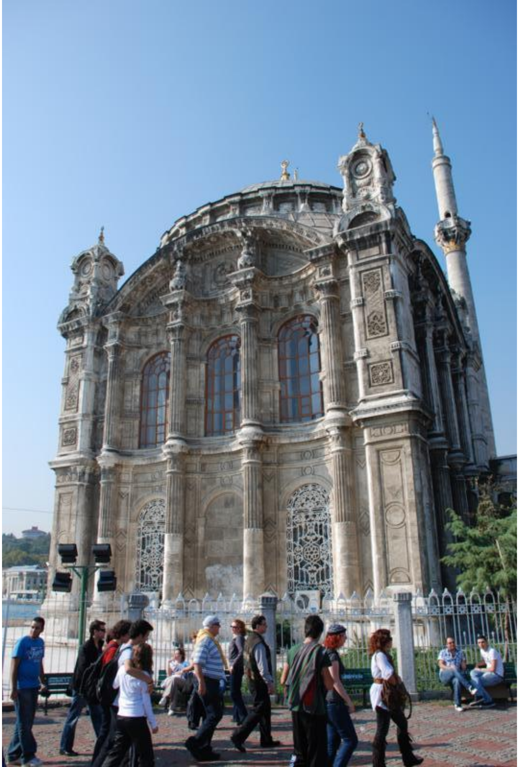
Resim 114: Ortaköy Camii Güney Cephesi
