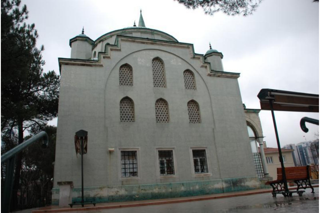
Resim 179: Levent Camii Doğu Cephesi
