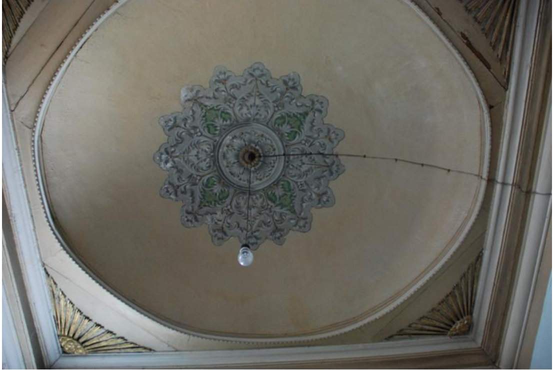
Resim 70: Abbas Ağa Camii İç Mekân Batı Yanında Bulunan Mahfilin Kubbesi
