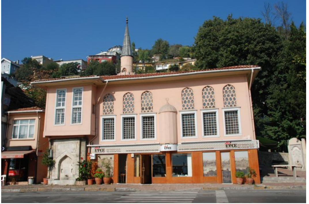
Resim 75: Tezkireci Osman Efendi Camii Güney Cephesi
