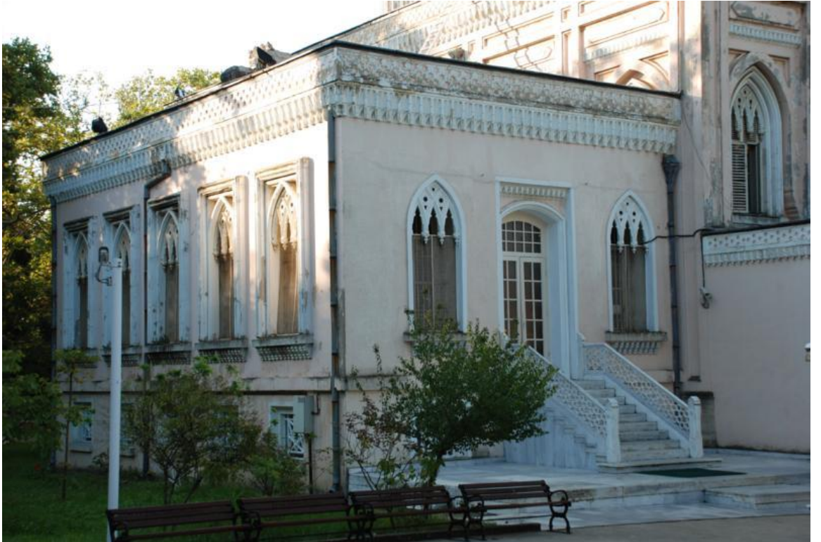
Resim 137: Yıldız Hamidiye Camii Doğu Cephesi Hünkâr Dairesi
