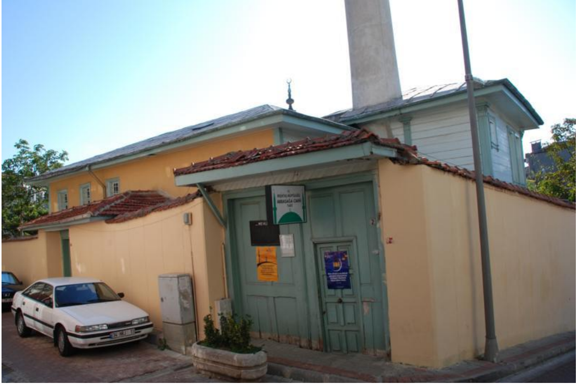
Resim 61: Abbas Ağa Camii Kuzey Cephesi
