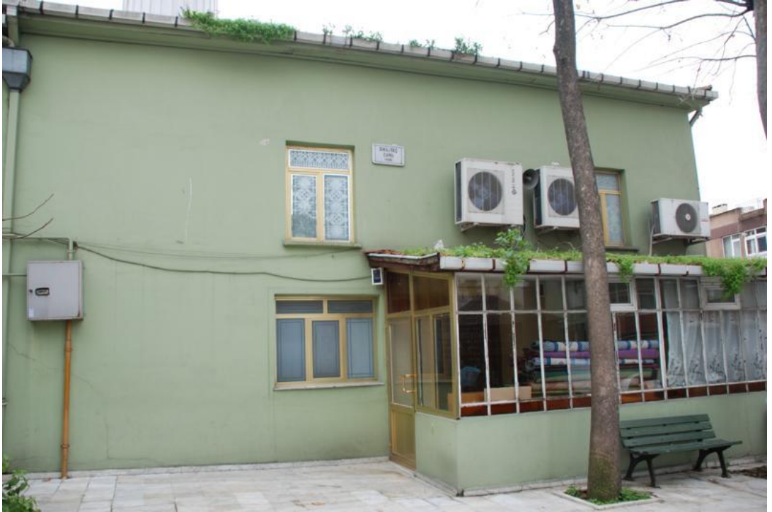
Resim 174: Dikilitaş Camii Kuzey Cephesinde Bulunan Giriş Bölümü
