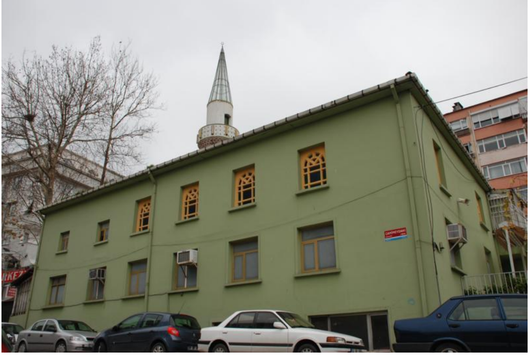
Resim 173: Dikilitaş Camii Batı ve Güney Cephesi
