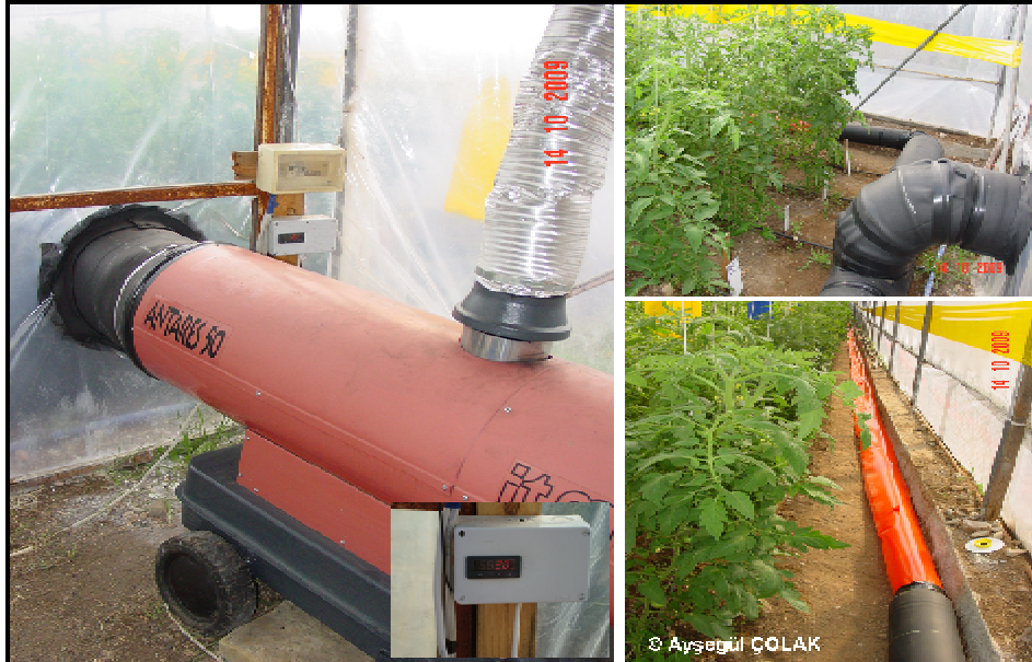
Şekil 3.14. Deneme serasına kurulan ısıtma sisteminden bir görüntü
