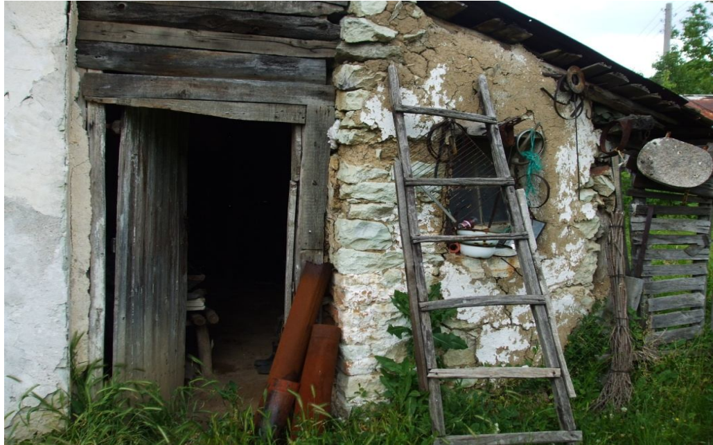
Foto 2.23. Eskiden ahır, günümüzde ise eve bağlı oda şeklinde kullanılan bir yapıdan görüntü (Sudineniye-Malak Çardak köyü)
