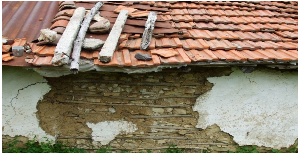
Foto 2.28. Liki Balkan Mahalle köyüne (Liki) duvarın içerisinde saman, taş ve çamur bulunan evden bir görüntü
