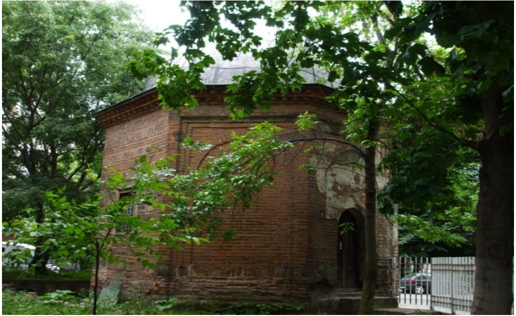
Foto 2.4. Şahabeddin Paşa türbesinden bir görüntü
