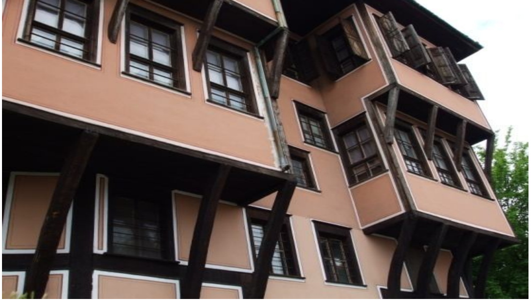
Foto 3.27. Eski Filibe’de restorasyonu yapılmış bir evden görüntü
