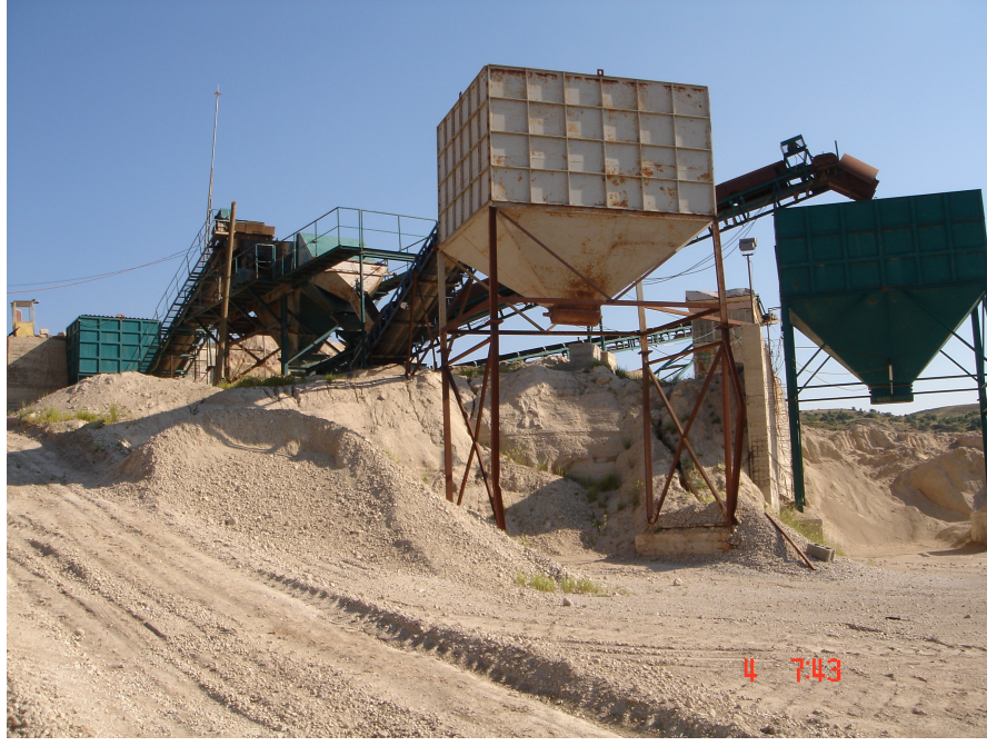
Şekil 4.7. Gelincik pomza sahası ön eleme tesisi
