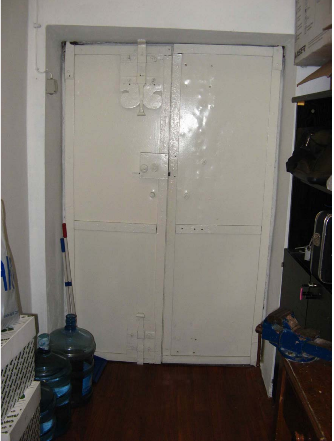
EK-6 Hazine-i Hassa Binası içindeki odalarda mevcut demir kapı detayları
