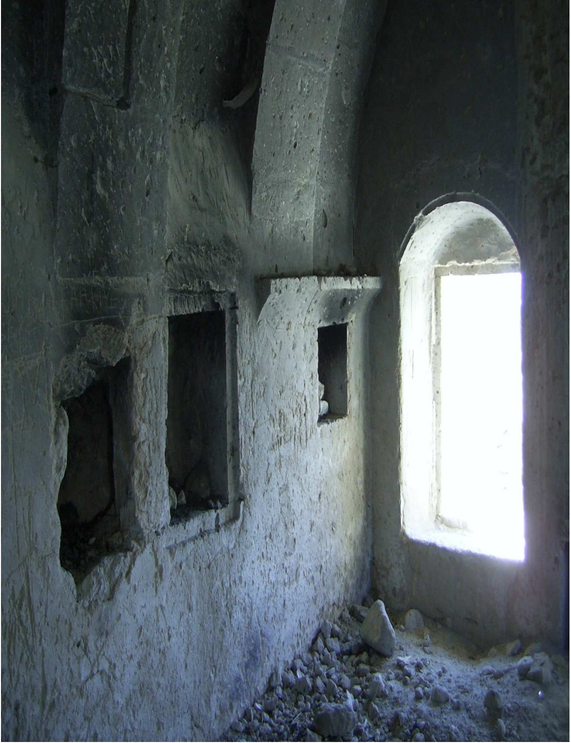
Fotoğraf 3: Say Üzerine Oturan Yapı
