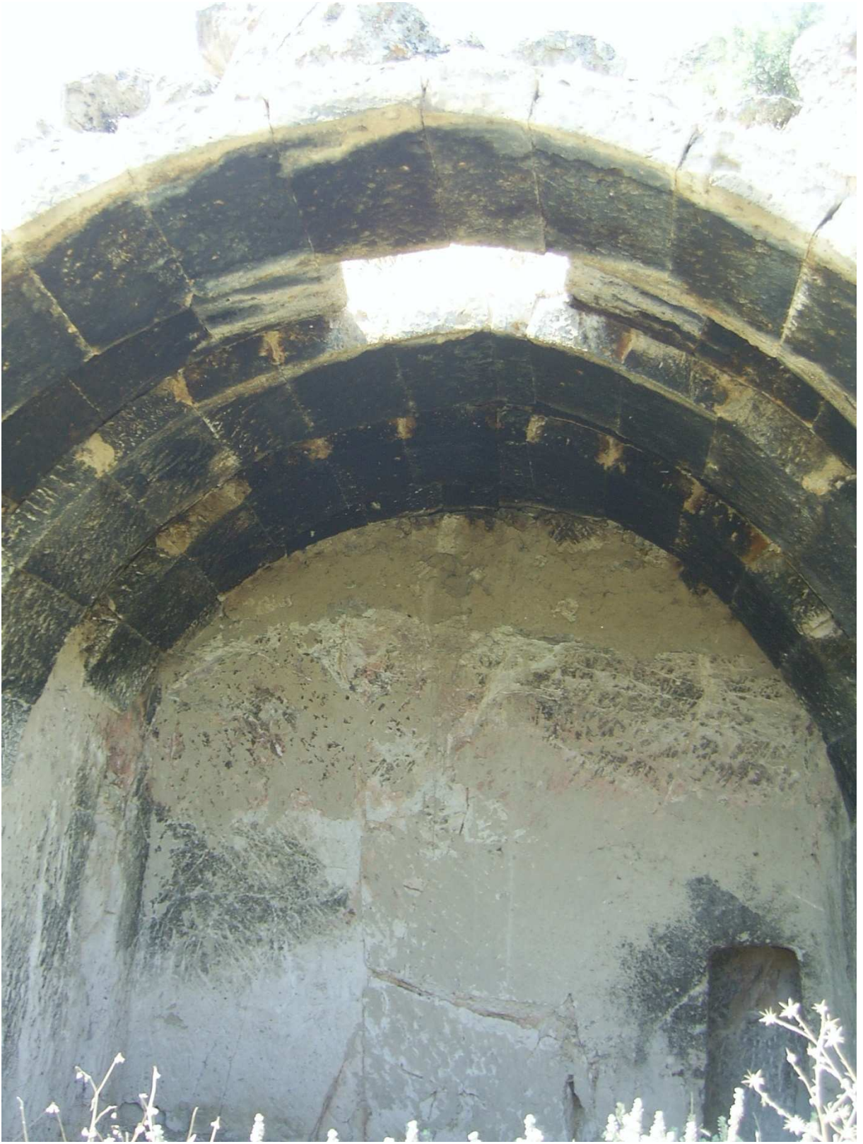
Fotoğraf 4: Say Üzerine Oturan Kemerli Yapı
