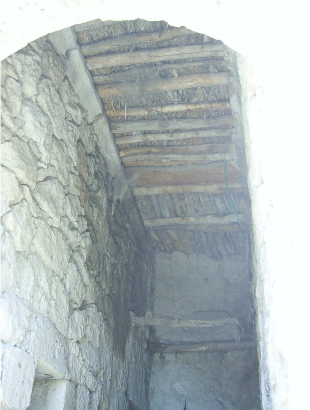
Fotoğraf 12: Ahşap Hatıllı Yapı
