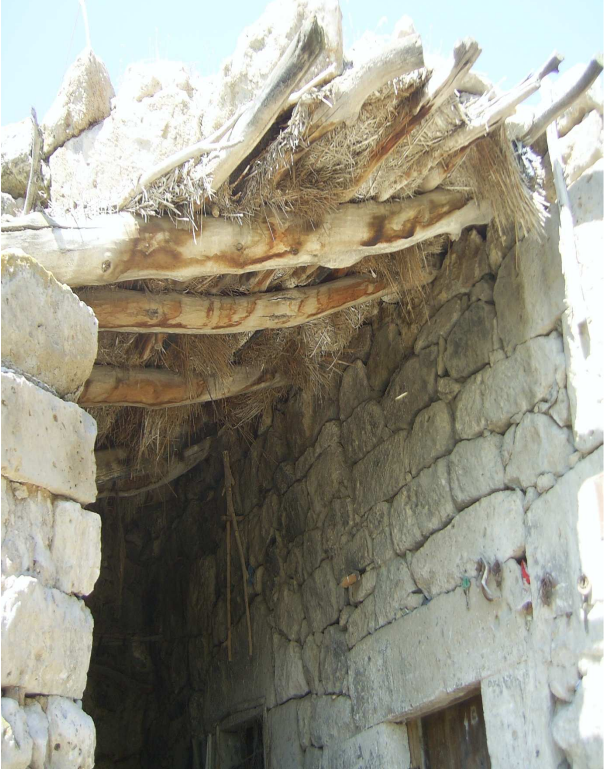
Fotoğraf 10: Ahşap Hatıllı Yapı
