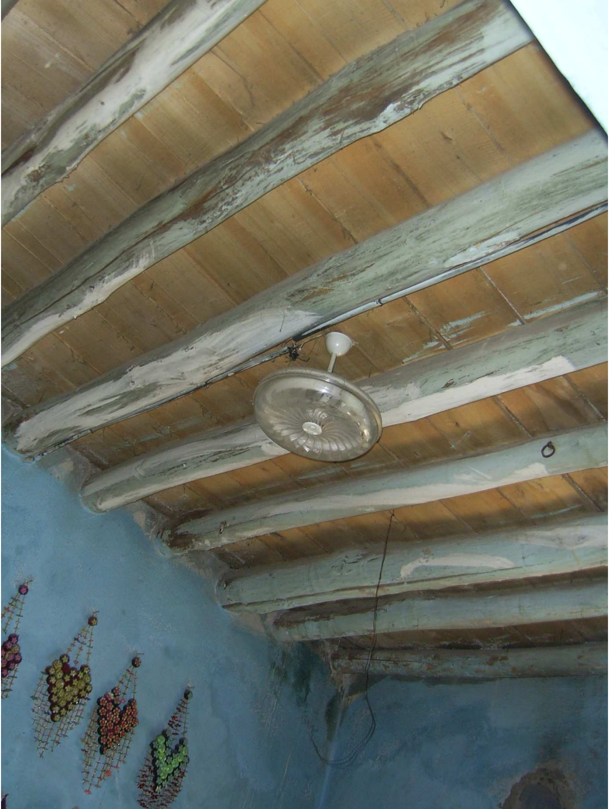
Fotoğraf 11: Ahşap Hatıllı Yapı
