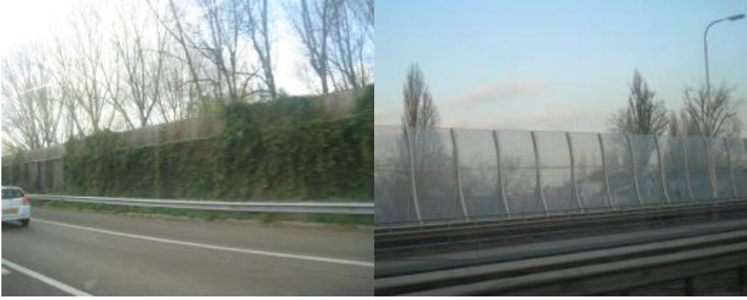
Şekil 1. 5. Kaynakla ile alıcı arasındaki gürültü azaltım bariyerleri
