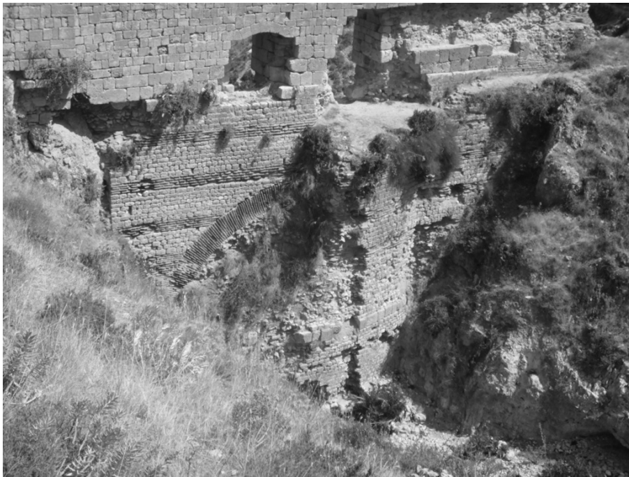
Resim 98: Köprü 1 (Demirkapı) Doğu Yüzü
