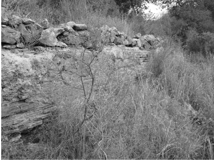
Resim 60: Örgü Kanal 4'ün Devamını oluşturan Tuğla Örgülü Kanal
