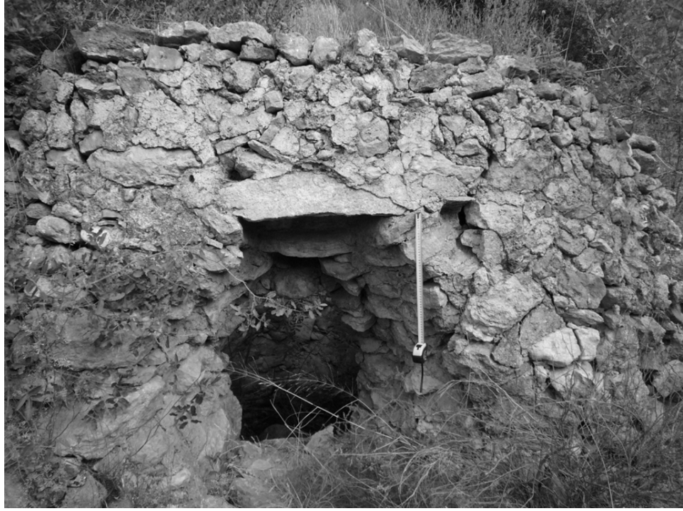
Resim 59: Örgü Kanal 4 İle Bağlantılı Depo Yapısı
