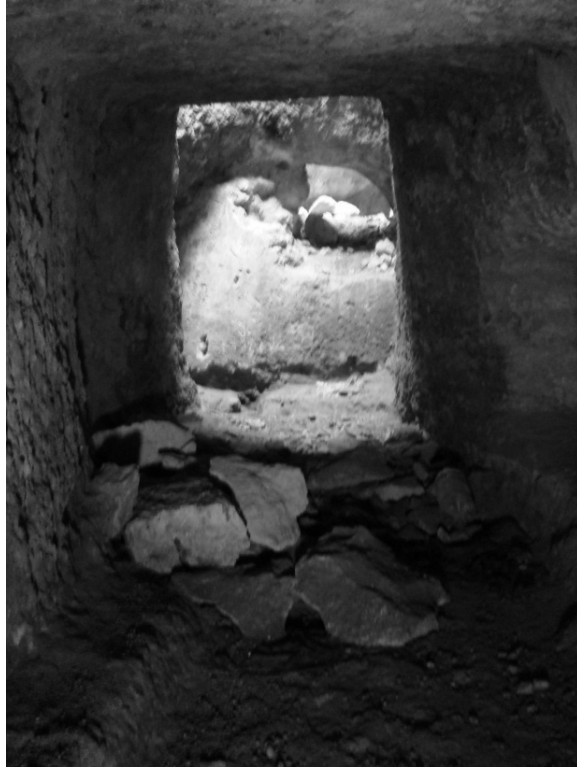
Resim 31: Sarnıç 15'in İç Kısımındaki Kanaldan Detay Görünüm
