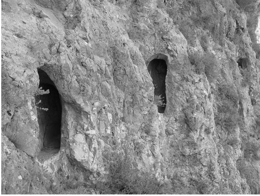
Resim 81: Oygu Kanal 1'e Açılan Gözler
