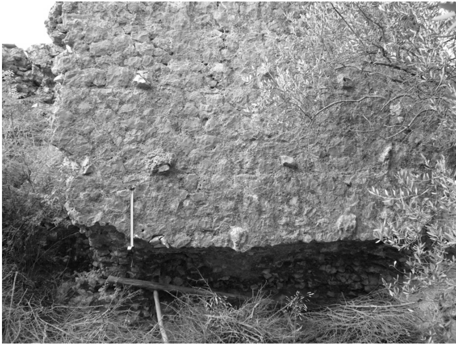
Resim 58: Örgü Kanal 4 Duvar Örgüsünden Ayrıntı
