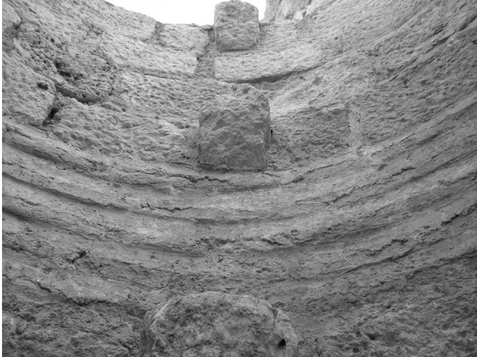
Resim 34: Sarmıç 17'den Duvar Örgüsü Detayı
