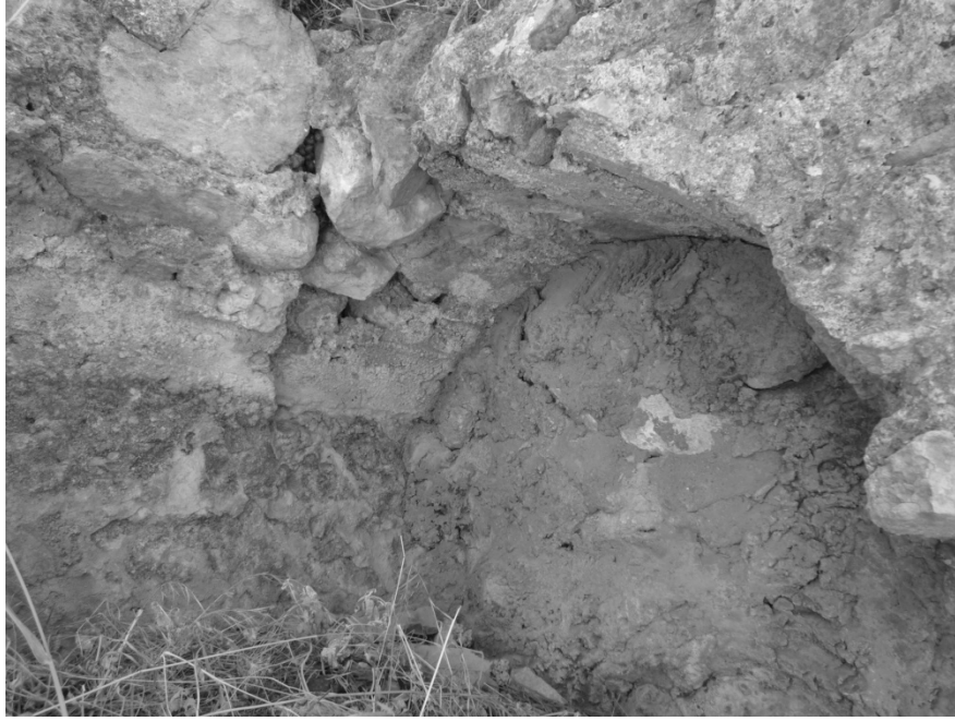
Resim 73: Örgü Kanal 14'den Detay Görünüm
