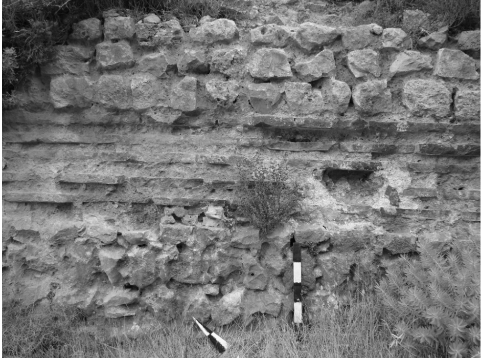
Resim 47: Sarmıç 26'dan Duvar Örgüsü Detayı
