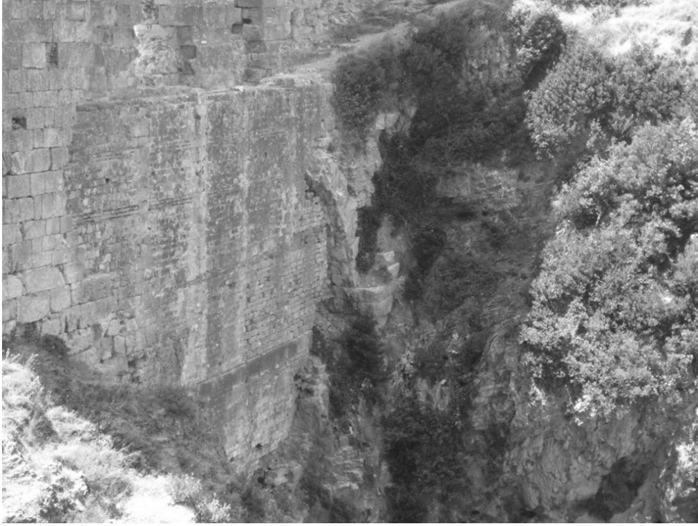
Resim 97: Köprü 1 (Demirkapı) Batı Yüzü
