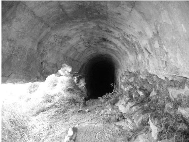
Resim 54: Örgü Kanal 1'in İçten Görünümü
