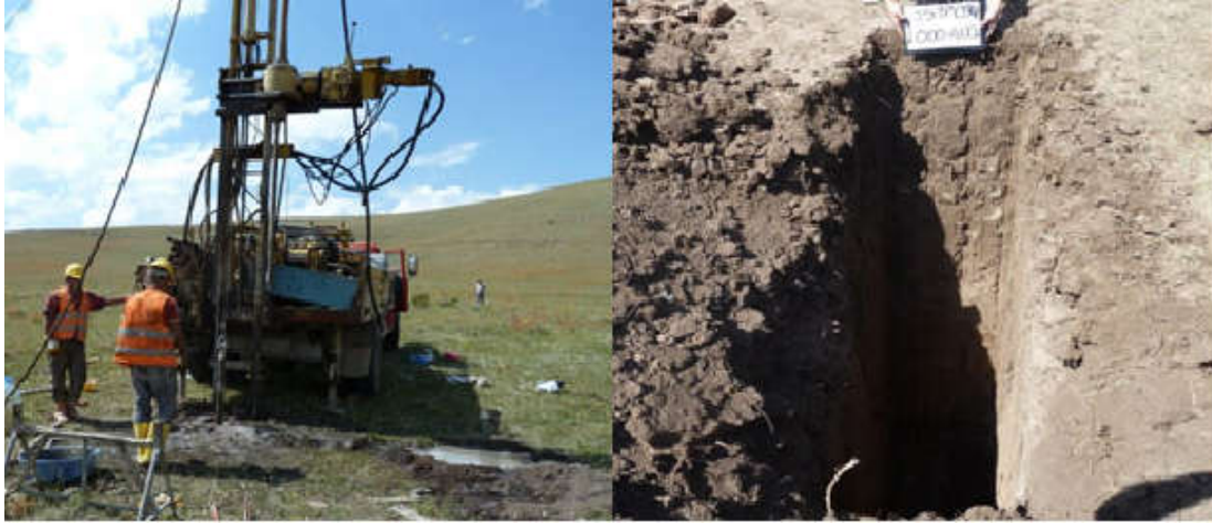
Şekil 5.3: 25-BH-33 (soldaki) sondaj ve 25-TP-34 (sağdaki) araştırma çukurunun arazi çalışması.
