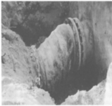
Şekil 2.2: 1993 Hokkaido-Nansei-Oki depreminde ( M=7.8 ) boru hatlarında görülen hasarlar a) 100cm yüzeye çıkan boru hattı b) Borunun bağlantı noktasından ayrılması (Mohri, Yasanuka ve Tani, 1995).
