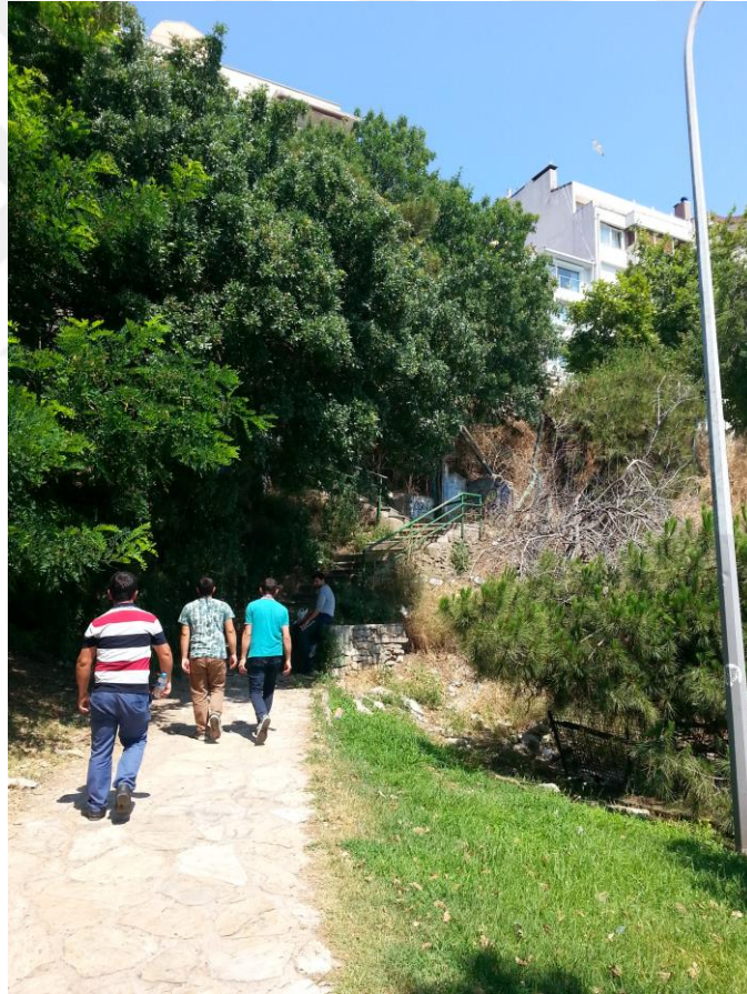
Şekil 3. 17 Problemlı merdiven bağlantısına kıyıdan erişim (09.07.2017)
