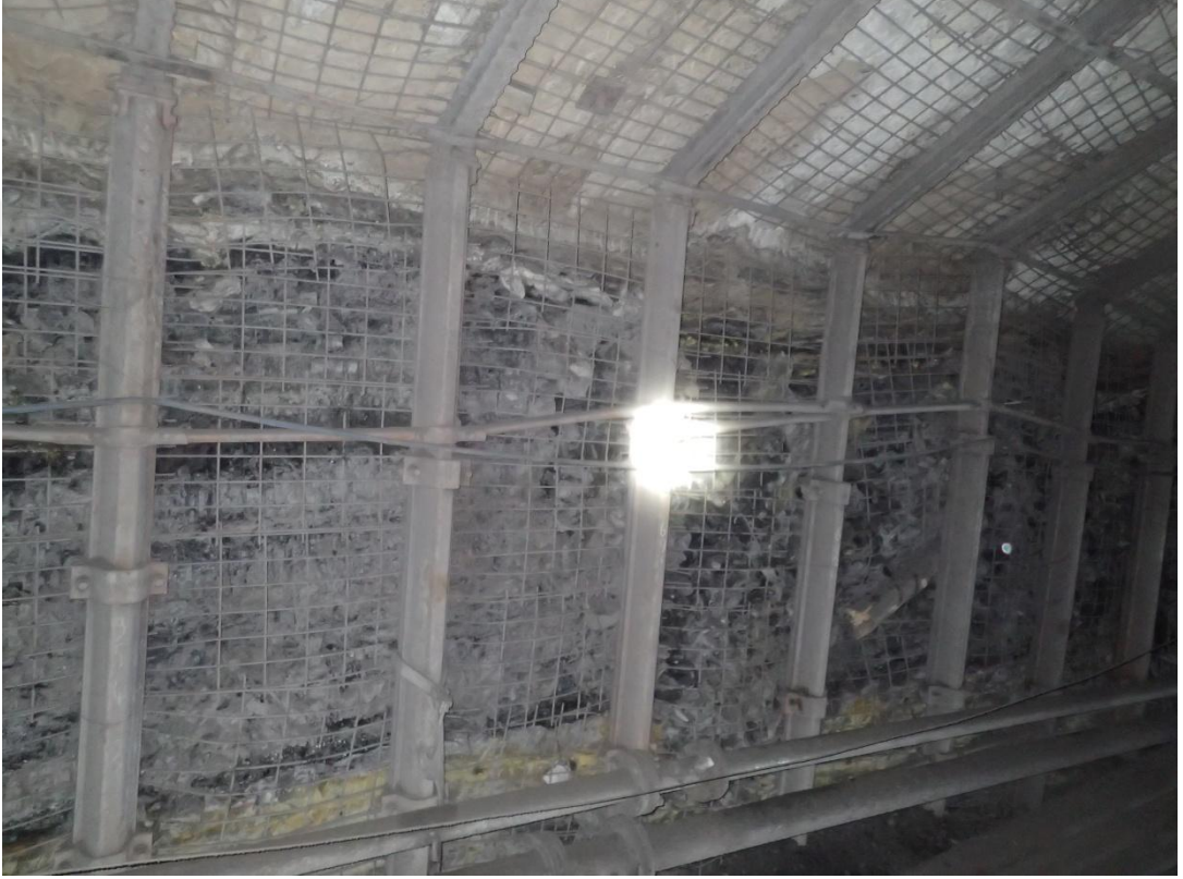
Şekil 1.1 Çelik profil, çelik hasır ve kaya saplaması örneği
