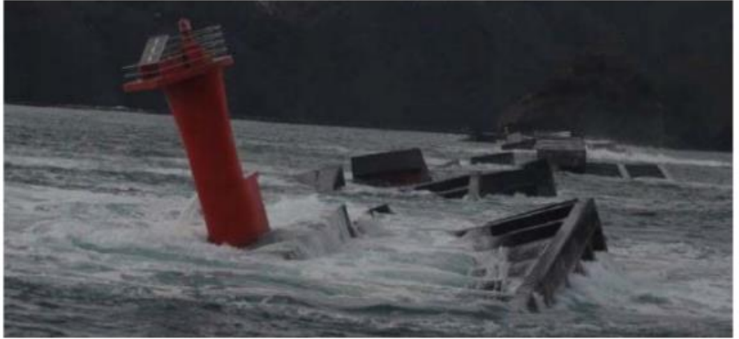
Şekil 2.14 Liman ağzındaki dalgakıranlarının hasar durumu, Kamaishi Limanı, Japonya [8]
