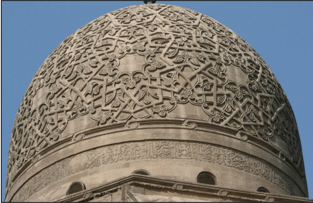
Resim (61): Kayıtbay Türbesinin kubbesi
