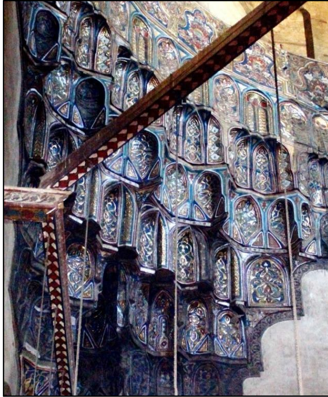
Resim (31): Sultan Hasan Türbesinin mukarnaslı geçiş bölgesi (detaylı)
