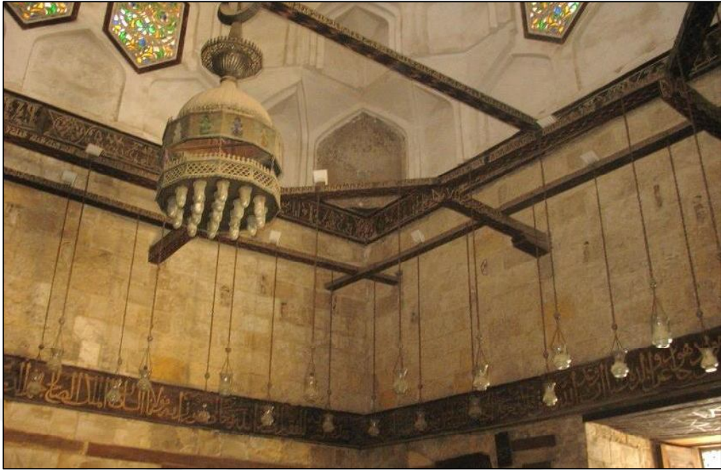
Resim (76): Salih Necmeddin Eyyub Türbesi'ndeki Aydınlatma aletleri taşıyan ahşap bağlamaları.
