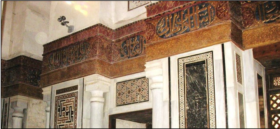
Resim (75): Memlûklü Türbelerin iç duvarlarını dolaşan yazılı ahşap şeritler, Salih Necmeddin Eyyub Türbesi (üst), S. Kalavun Türbesi (alt)
