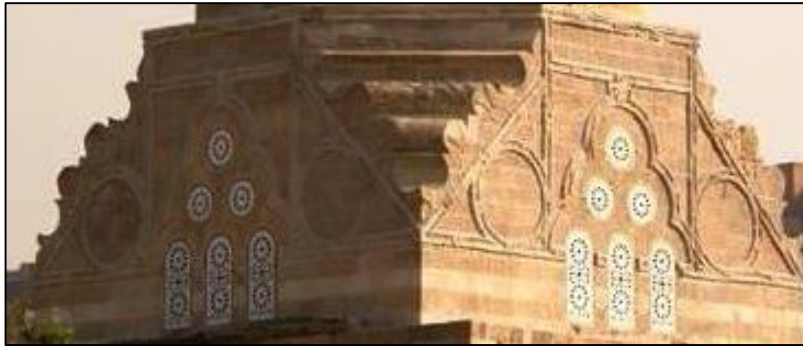
Resim (103): Tarabay Şerifi türbesindeki geçiş bölgesindeki alçı ile kaplanan pencereler
