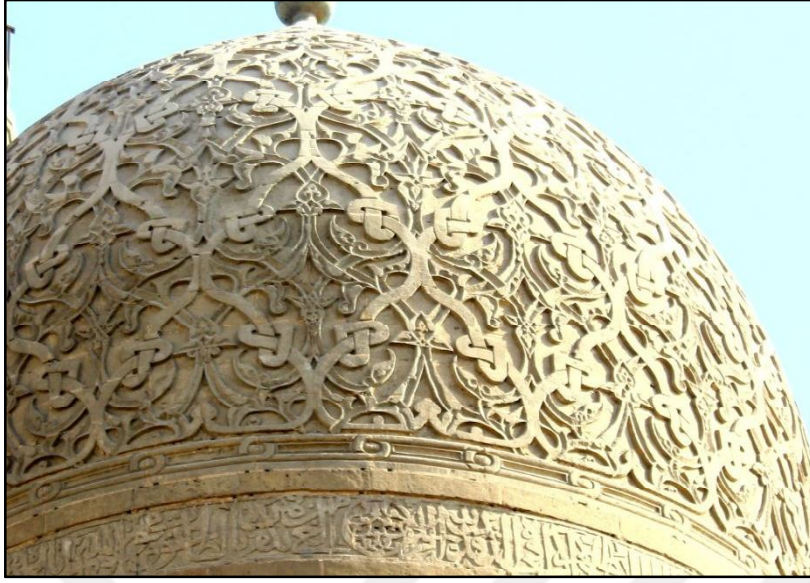
Resim (64): Hayırbey Türbesinin kubbesi
