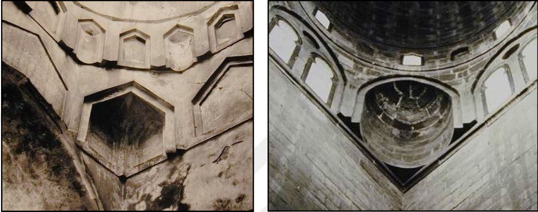
Resim (27): Toğay Hatun (sol), S. Şaban'ın Annesi (sağ) türbelerinin geçiş unsuru
