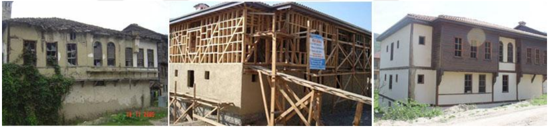
Şekil 5.16. Hacı Rıfatlar Konağı restorasyonu
