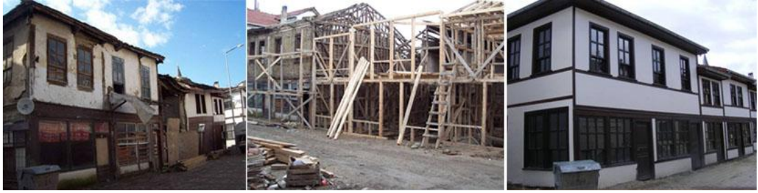
Şekil 5.18. Yunuspaşa Çarşısı Sokak Projesi, cephe restorasyonları, zemin kaplamaları
