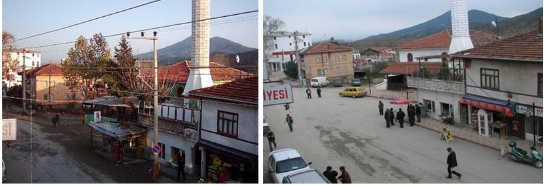
Şekil 5.11. Elektrik direkleri ve kabloları kaldırıldıktan öncesi ve sonrası
