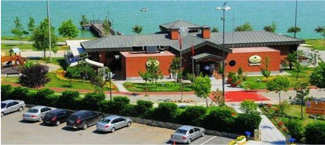
Şekil 4.16 Küçükçekmece sosyal tesisi
