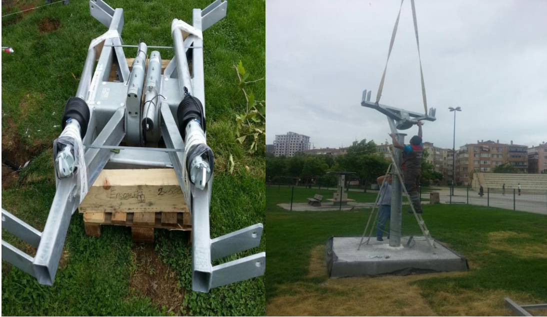
Şekil 4.7 Elektrik motoru ve direk üzerine yerleşimi
