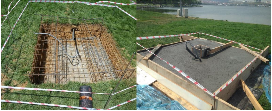
Şekil 4.2 Çelik hasır ve betonarme
