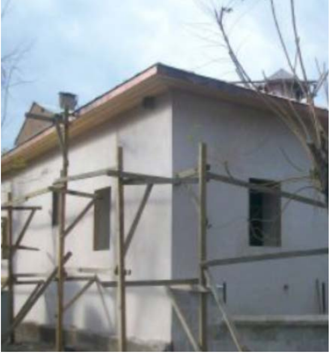
Camii'de 2010-2011 Yıllarında Yapılan Tadilat alıřmalarından Bir Grnt
