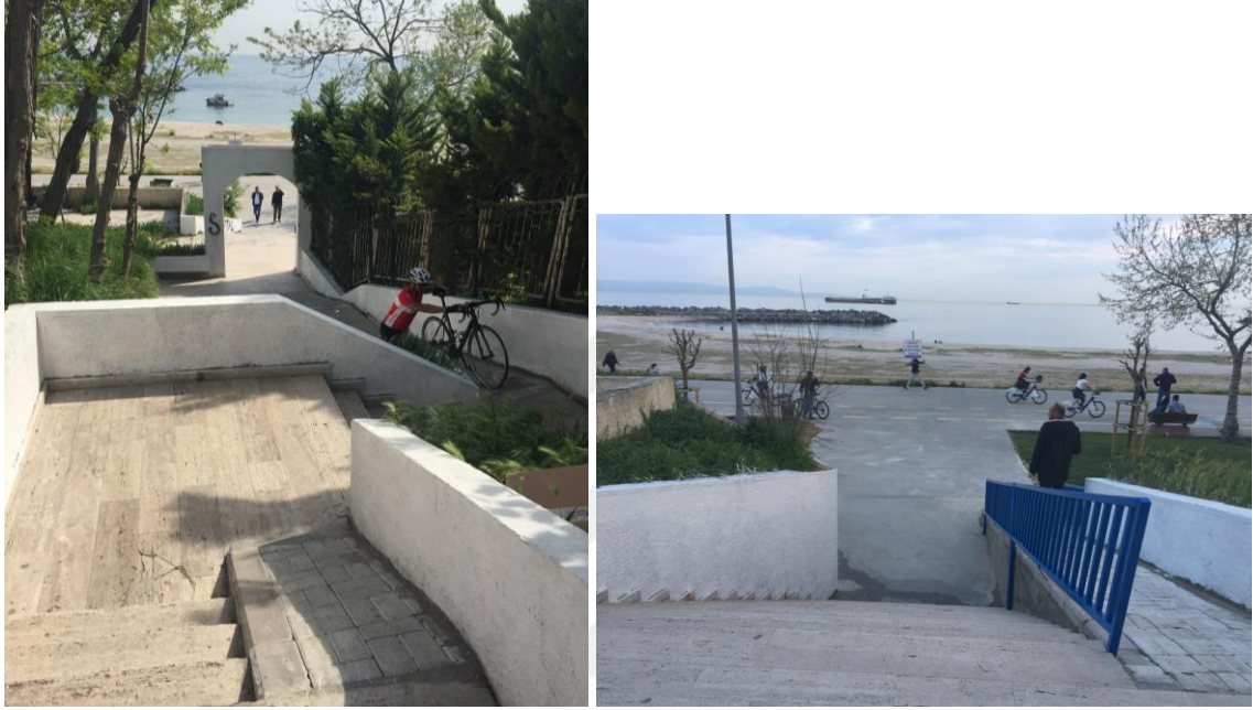
Şekil 5. 17 Alanın doğusunda (Yeşilyurt bölgesi) kıyıya merdiven ve rampa ile erişim
