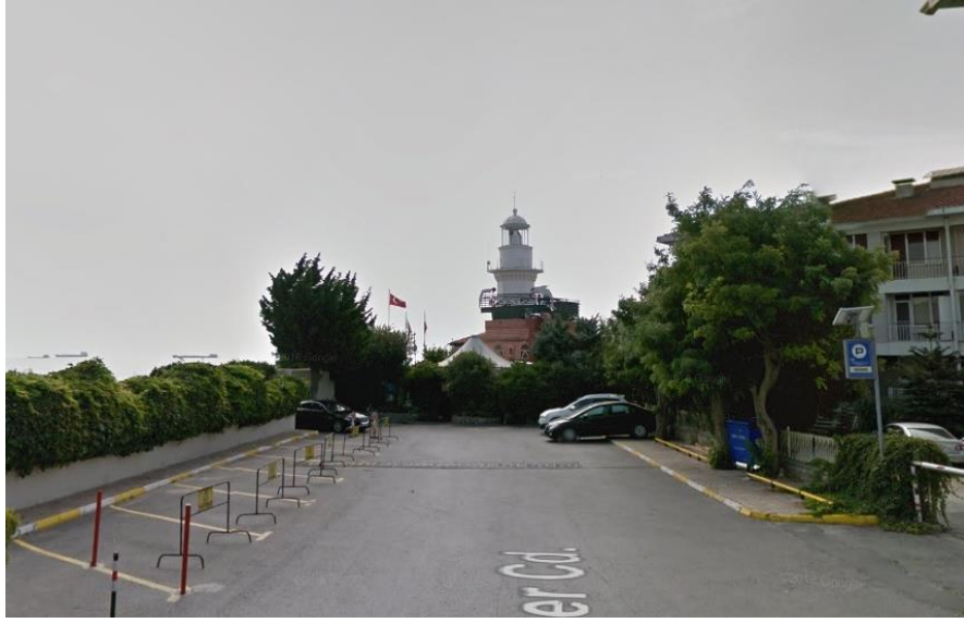
Şekil 2. 37 Yeşilköy Sis ve düdük Feneri'nden otoparklar ve dolgudan kaynaklanan kot farkının çözülmemesi nedeniyle fiziksel erişim engeli [31]
