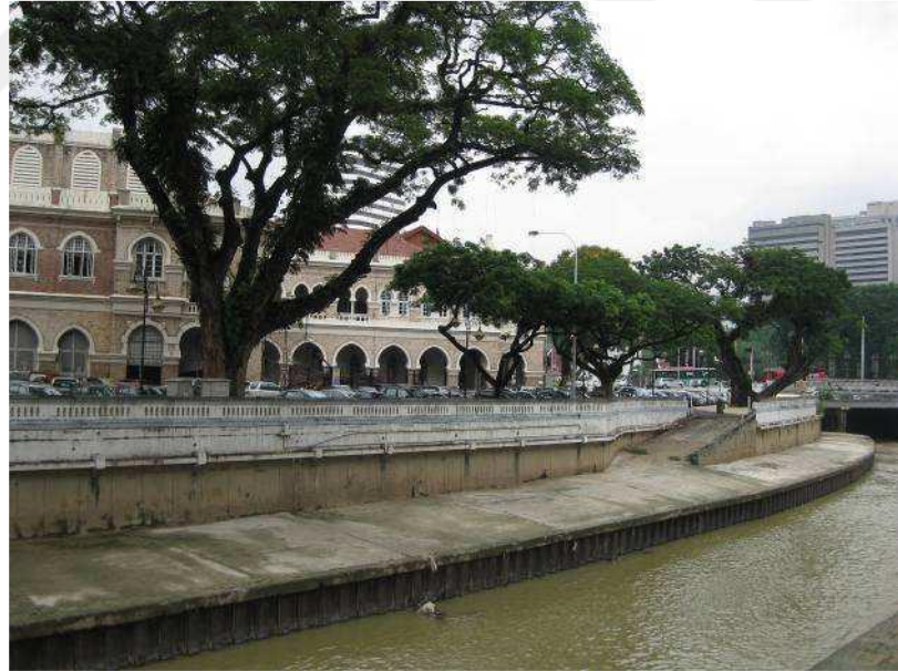
Şekil 3. 11 Büyük yapı kütlesi nedeniyle kıyı geri alanı ile kıyı bağlantısına ve görsel/fiziksel erişime engel olan Sultan Abdul Samad Binası [84]
