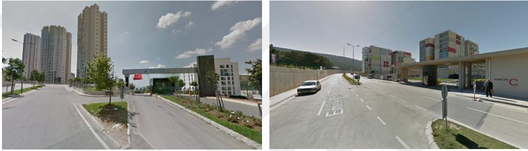
Şekil 2.24: Kapalı site girişlerinden örnekler, İstanbul (Google Street View, 2016).
