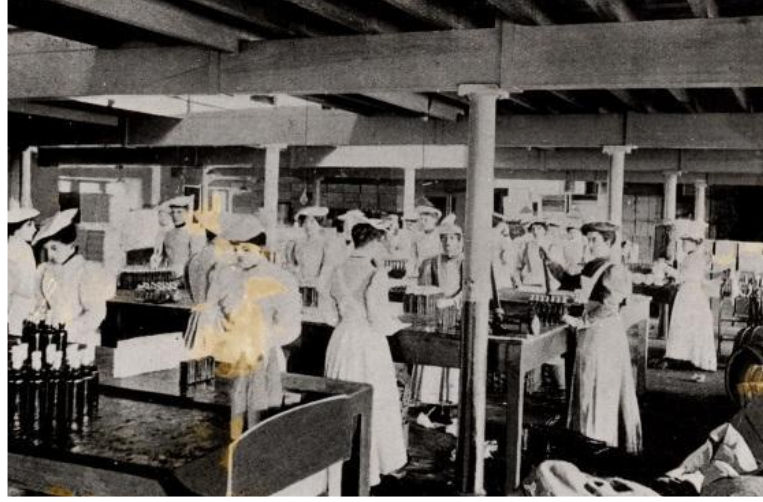
Şekil (4.38.): CWS Un Fabrikası ve iç mekanı
