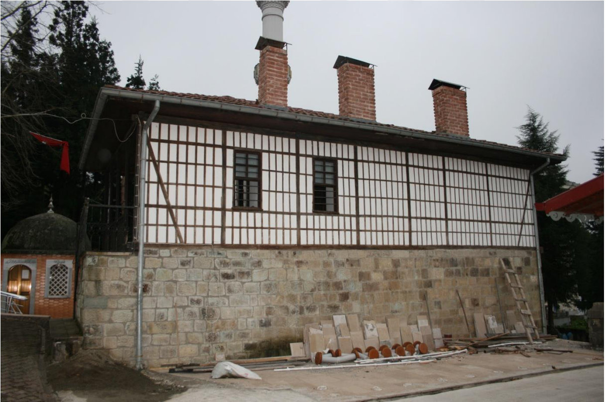
Fotoğraf 122: Uğurlu Beldesi Eski Medrese Binası Batı Cephe
