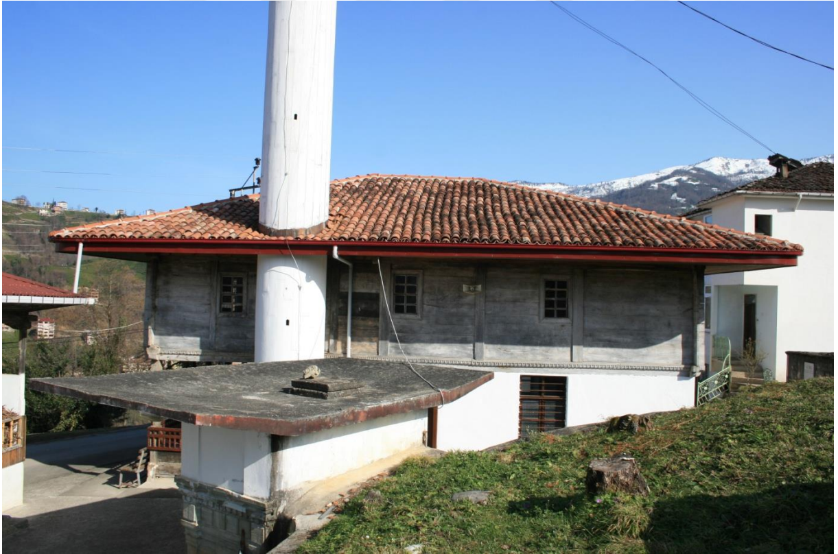
Fotoğraf 14 : Bölümlü Mithat Paşa Mah. (Kalanas) Camii Batı Cephe
