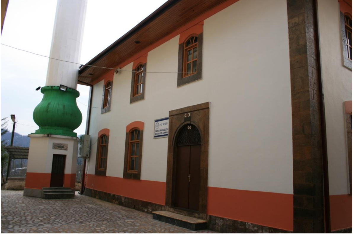
Fotoğraf 93: Yazlık Köyü Merkez Camii Doğu Cephe
