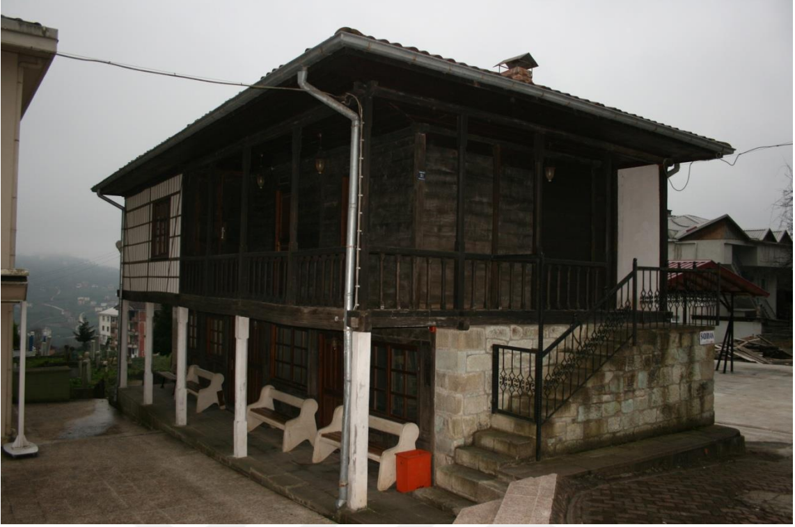
Fotoğraf 121: Uğurlu Beldesi Eski Medrese Binası Kuzeydoğu Cephe
