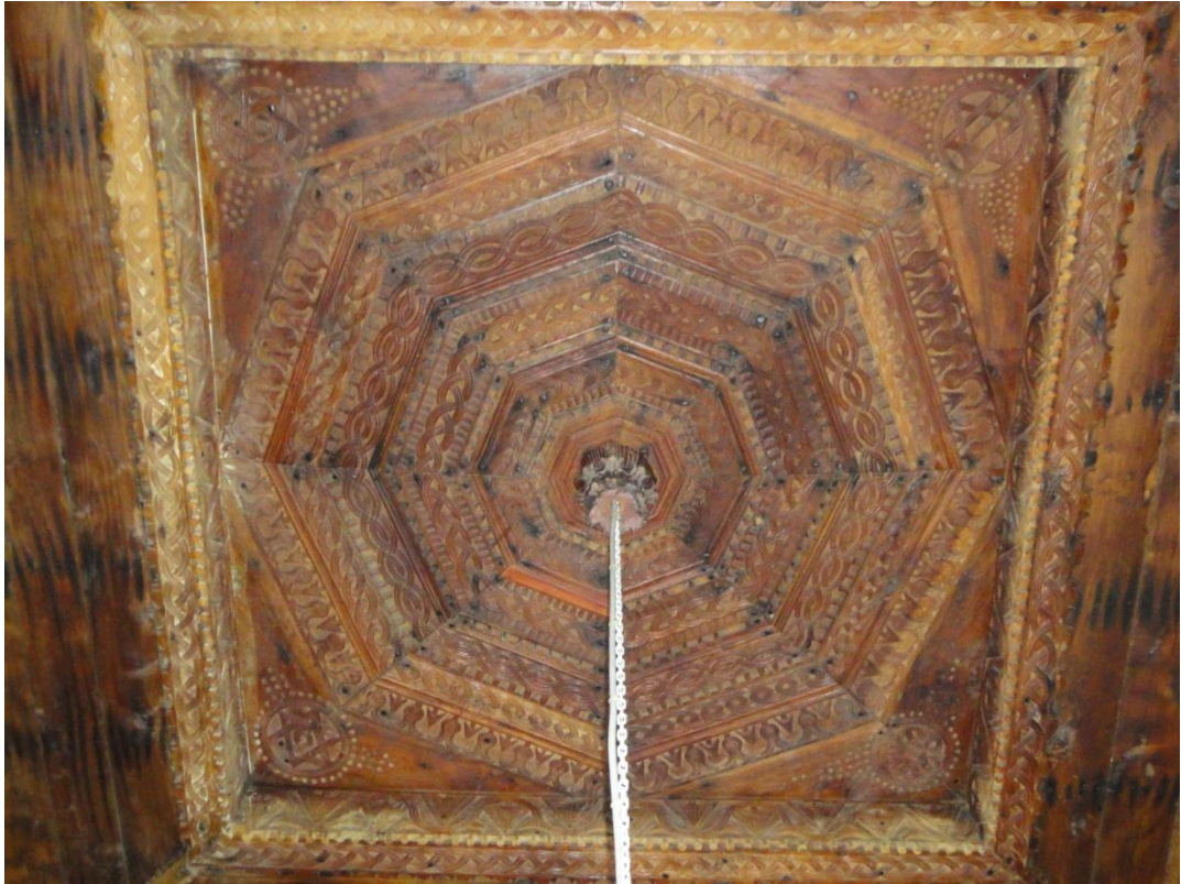
Fotoğraf 52: Sugeldi Köyü Aşağı Mahalle Camii Tavan Göbeği
