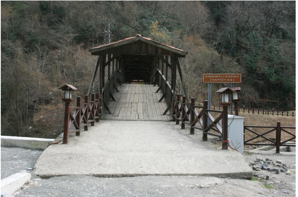
Fotoğraf 142: Bölümlü Beldesi Kiremitli (Hapsiyaş) Köprüsü
