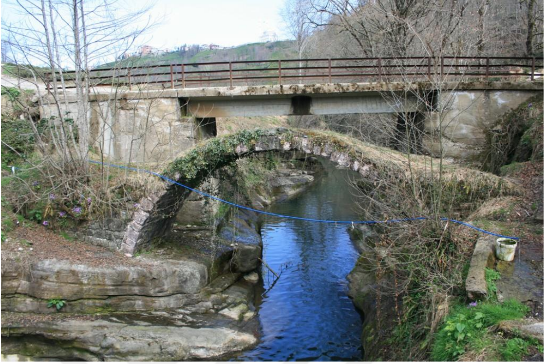
Fotoğraf 139: Darılı Köyü Köprüsü
