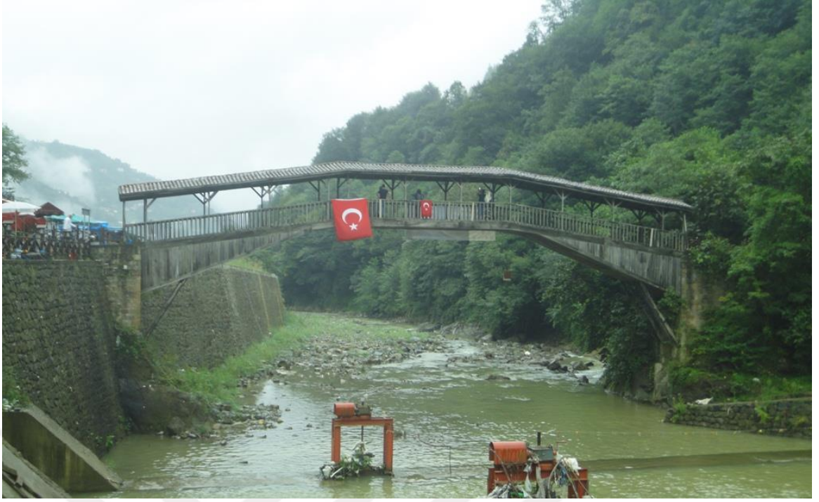
Fotoğraf 141: Bölümlü Beldesi Kiremitli (Hapsiyaş) Köprüsü
