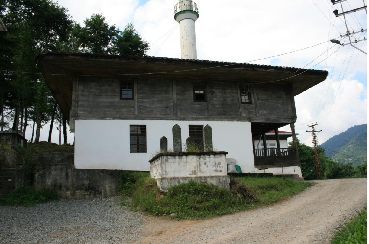
Fotoğraf 12 : Bölümlü Mithat Paşa (Kalanas) Mah. Camii Doğu Cephe
