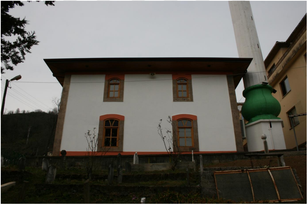
Fotoğraf 94: Yazlık Köyü Merkez Camii Güney Cephe
