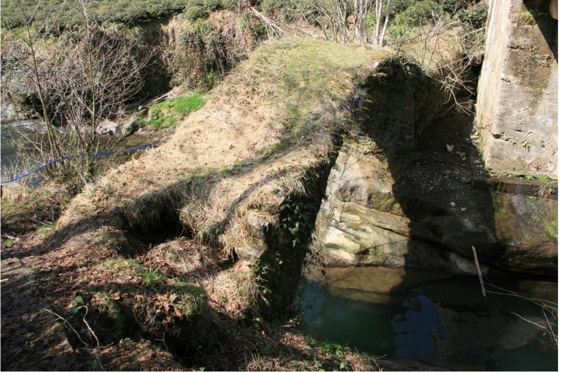
Fotoğraf 140: Darılı Köyü Köprüsü
