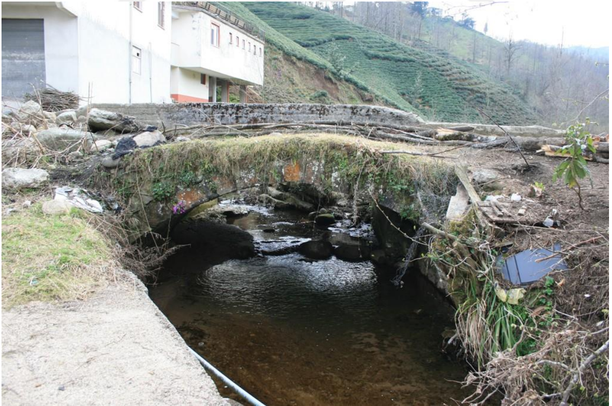
Fotoğraf 136: Aşağı Kışlacık Köyü Köprüsü
