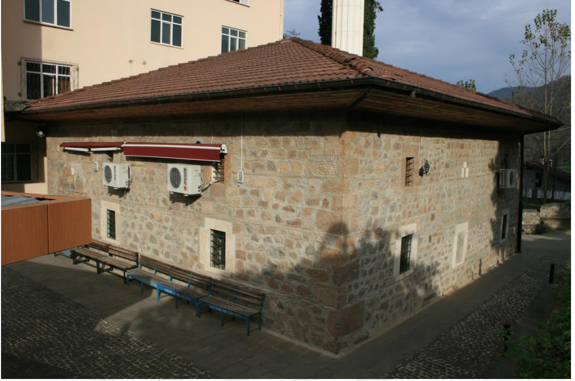
Fotoğraf 69: Bölümlü Beldesi Büyükcami Mah. Camii Güney ve Batı Cephe
