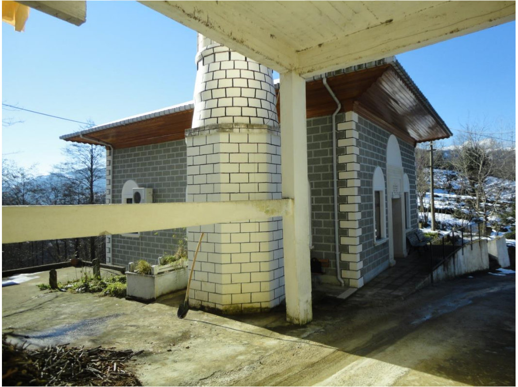
Fotoğraf 76: Ballica Köyü Yıldız Mah. Camii Kuzeydoğu Cephe
