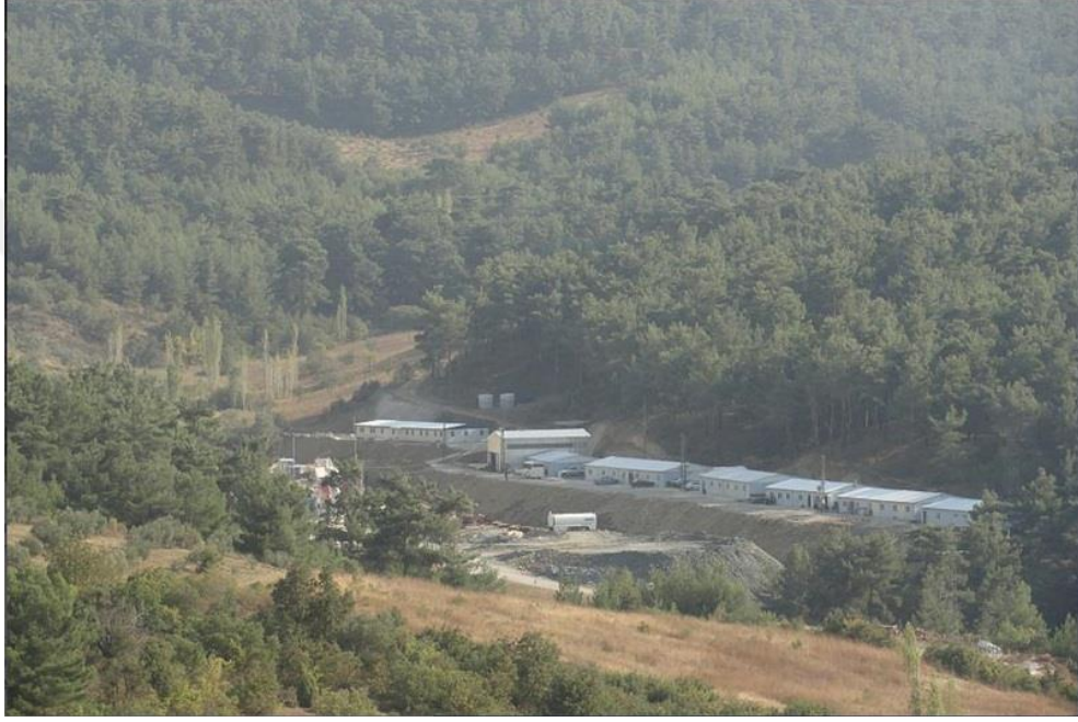
Şekil 2.5a. Ocak yerüstü tesisleri genel görünümü.
