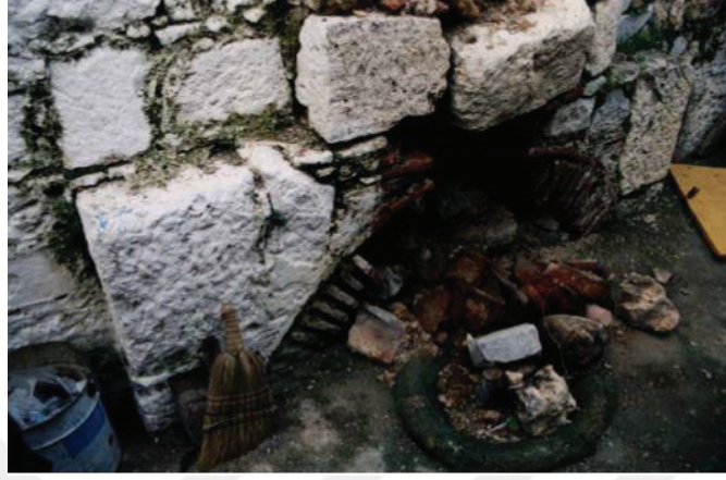
Figure 2.6. Sığacık Kaleiçi Bath, The furnace [23].
