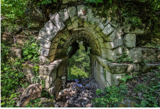
Şekil 25: Amasra Kemerdere Köprüsü
