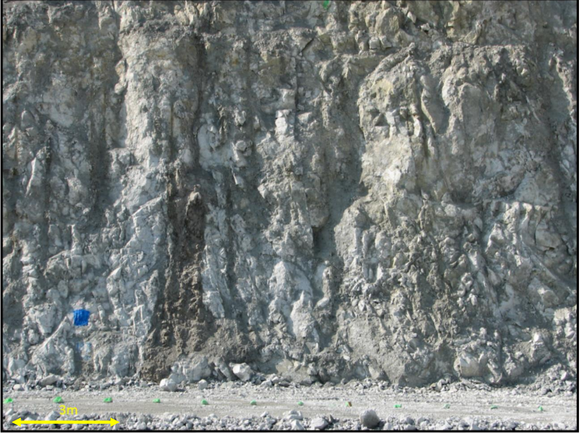
Şekil 5.13. Zayıf zonun şev aynasındaki görünümü
