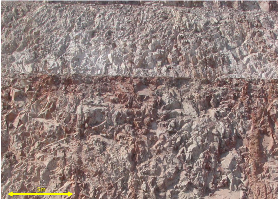
Şekil 5.10. Küçük bloklı zonun şev aynasındaki görünümü
