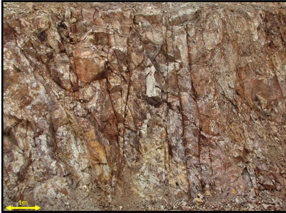
Şekil 5.8. İri bloklı zonun şev aynasındaki görünümü
