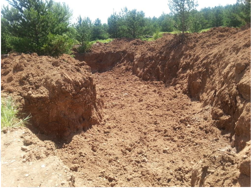
Şekil 3.7 Kazı işleminin sonunda kazı alanı
