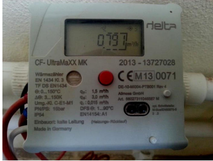
Şekil 3.19 Ultrasonik termal enerji sayacı
