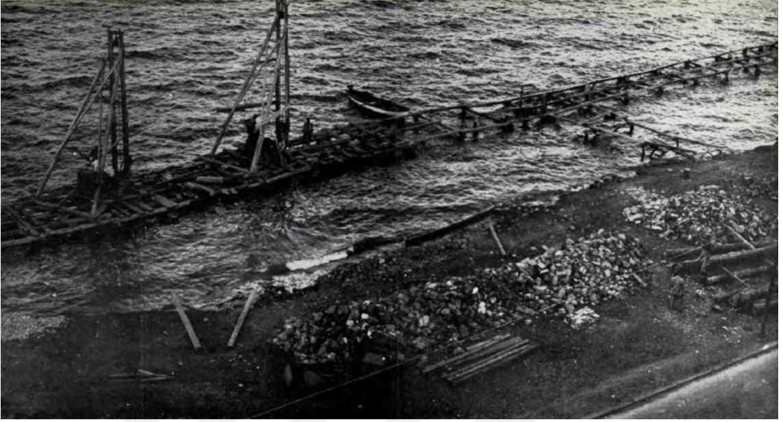
EK 20: Boğaz sahil yolu kapsamında Tarabya’da denizi doldurma çalışmaları
