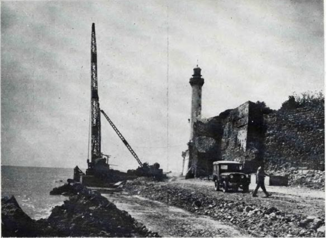
EK 16: Sirkeci-Florya sahil yolu yapım çalışmaları
