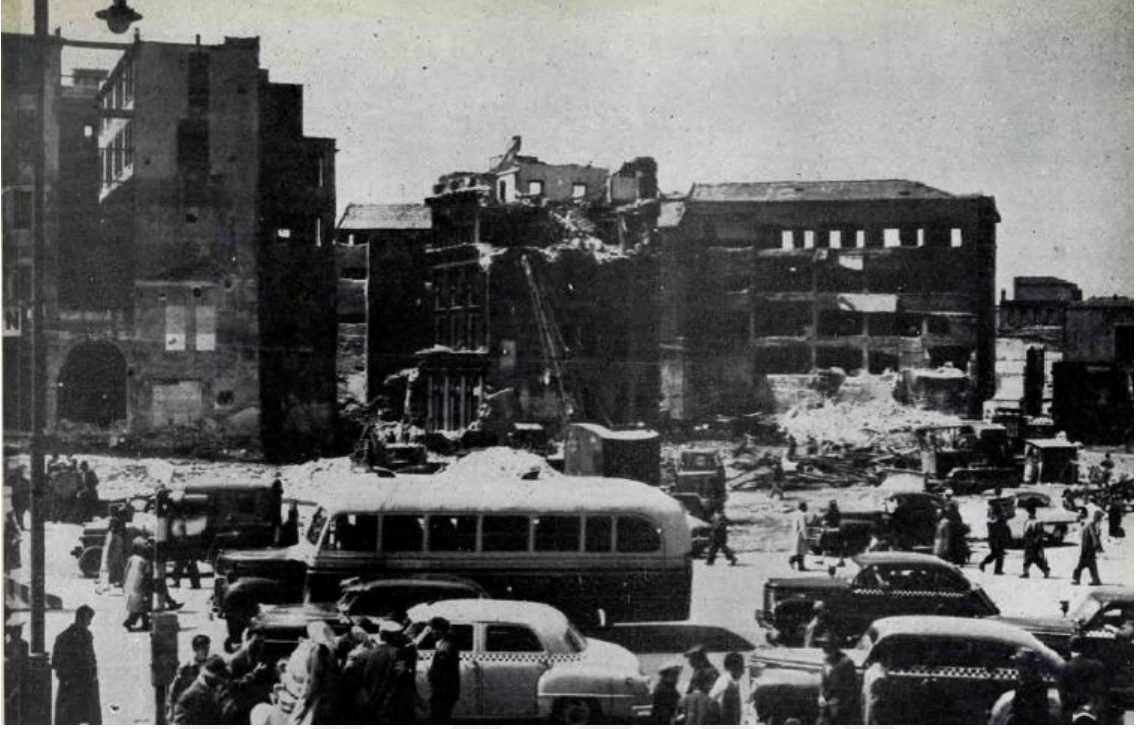
EK 22: Balıkpazarı'nda istimlak edilen binaların yıkım çalışmaları
