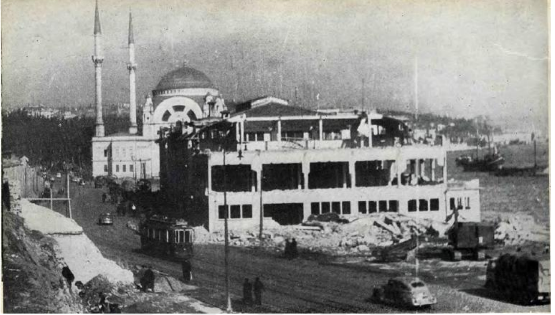
EK 18: Kabataş İskelesi civarında yıkım çalışmaları
