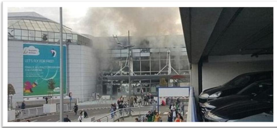
Resim 7. Brüksel Zaventem Havalimanı'nda Oluşan Hasar (Kaynak: ntv.com)
