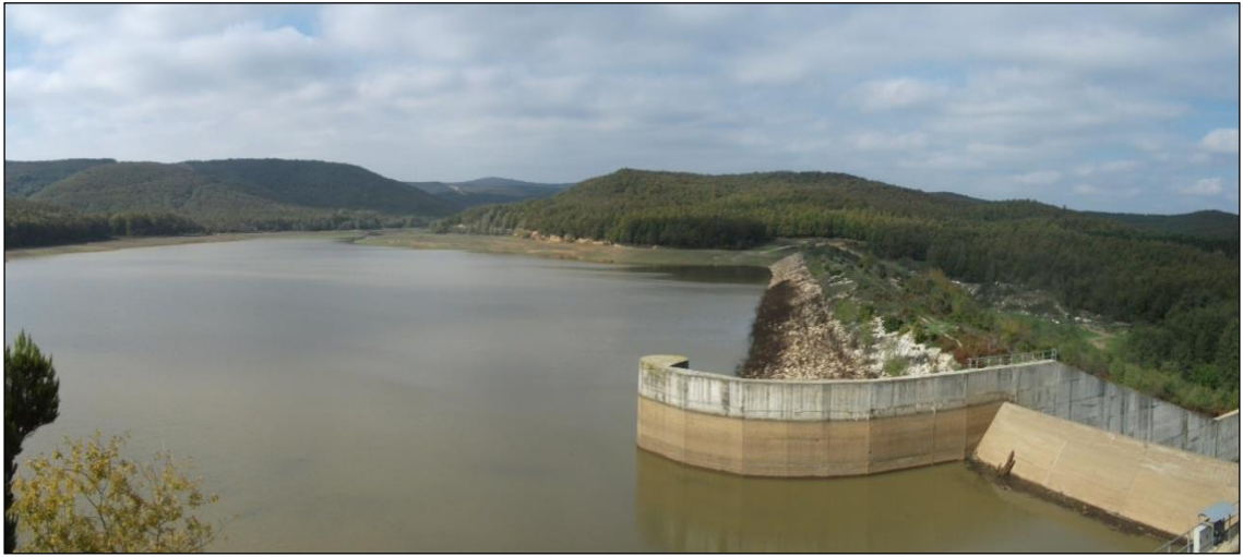
Fotoğraf 4.60. Kuzuludere Barajı
