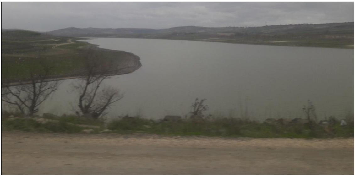
Fotoğraf 4.35. Sazlıdere Barajı
