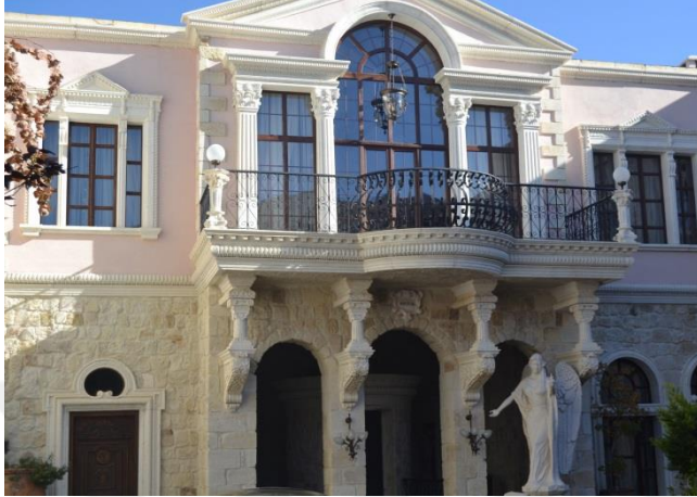
Şekil-94. Taş Yığma Yapı, Sacred House, Ürgüp [183]
