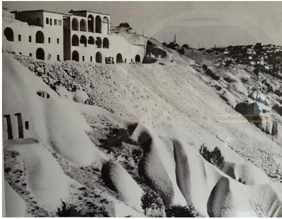
Şekil 86. Kaya Oyma Yapı, Kaya Otel, Uçhisar, 1966 [174]
