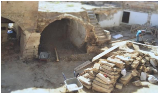
Şekil-78. Kaya Oyma Onarımları, Asuwari Otel, Ürgüp [165]
