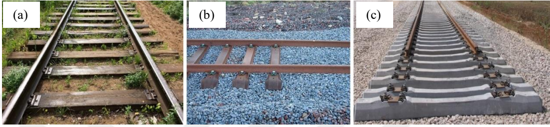
Şekil 3.19. (a) Ahşap travers, (b) Çelik travers, (c) Beton travers
