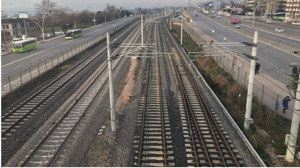
Şekil 3.1. Balastlı demiryolu üstyapısı
