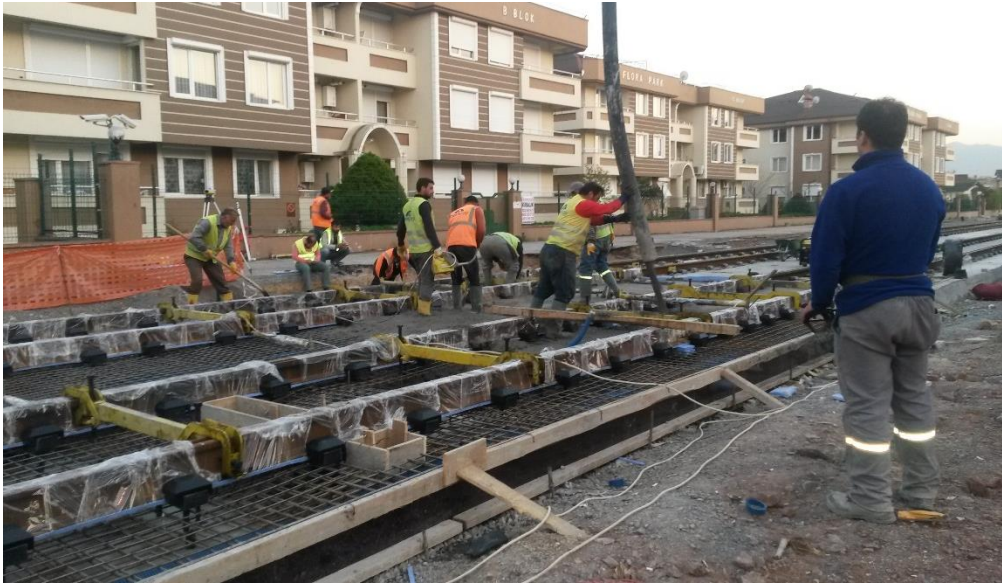
Şekil 3.11. Taşıyıcı betona mesnetli gömülü ray sisteminde beton döküm uygulaması
