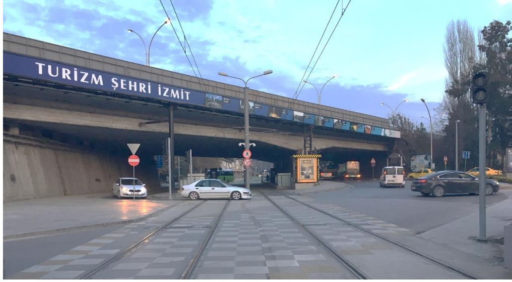
Şekil 3.12. Gömülü ray sisteminin işletmedeki hali
