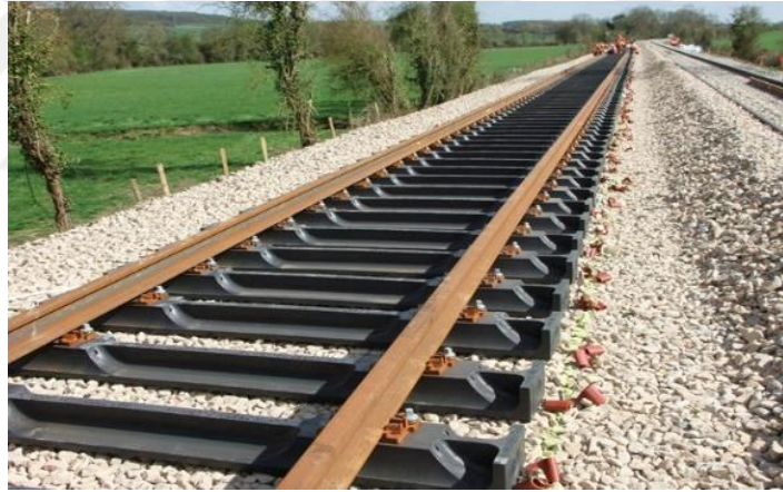
Şekil 3.24. Plastik travers uygulaması
