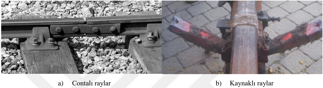
Şekil 3.25. Rayın raya bağlantısı
