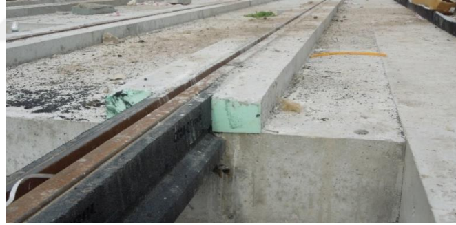
Şekil 3.28. Elastik yataklı ray bağlantı sistemi uygulaması
