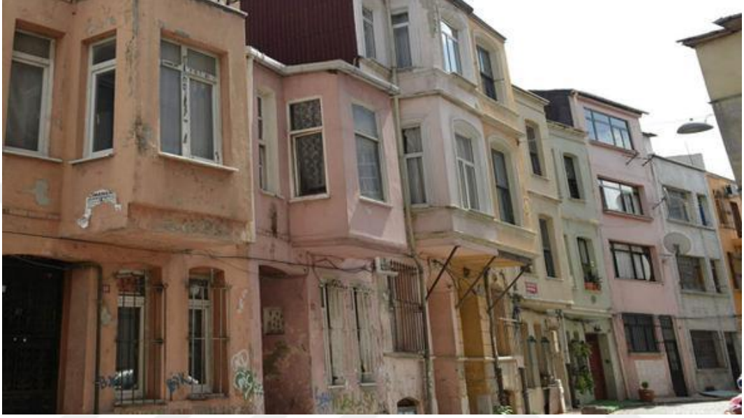
Şekil.5.11 “Balat’ta binaların Rehabilitasyon Çalışmaları” isimli haber görseli (Tekten, 2014)
