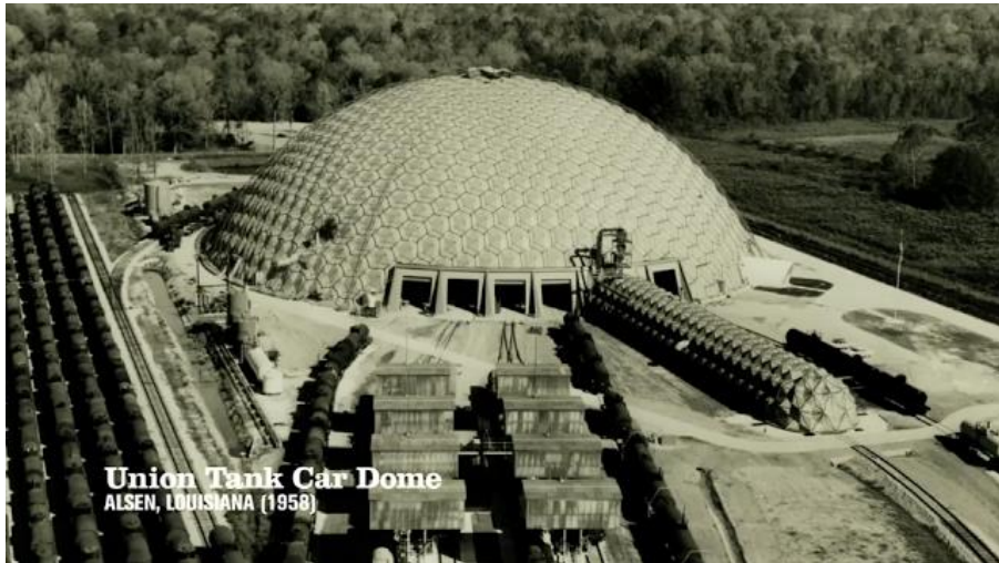
Şekil 2.8 Union Tank Car Company için tasarlanan 117 m çapındaki kubbe [30]
