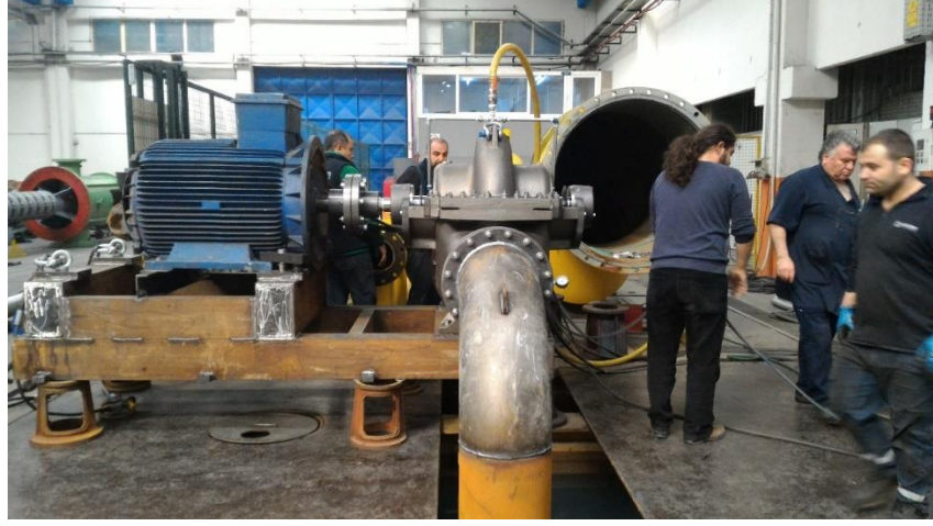
Şekil 5.4. Pompanın deney laboratuvarındaki hatta bağlanması.
