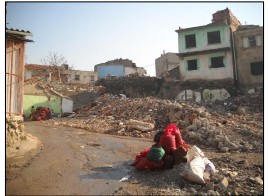
Foto 18: Kadifekale’de gerçekleştirilen yıkımlar (24.12.2011)
