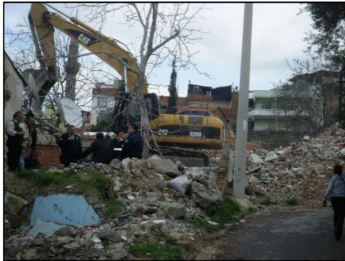
Foto 15: Kadifekale’de gerçekleştirilen yıkımlar (05.03.2010)
