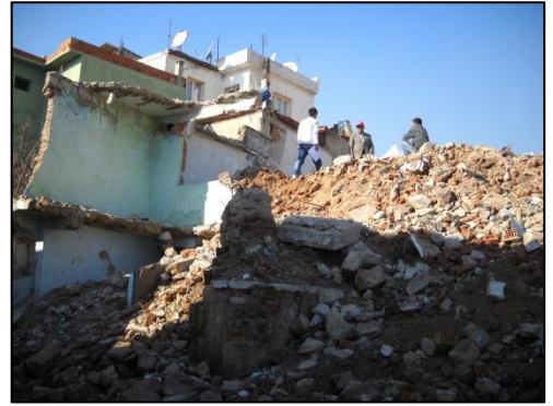
Foto 17: Kadifekale’de gerçekleştirilen yıkımlar (24.12.2011)
