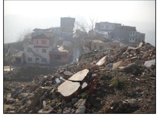
Foto 16: Kadifekale’de kentsel dönüşüm için gerçekleştirilen yıkımlar (24.12.2011)
