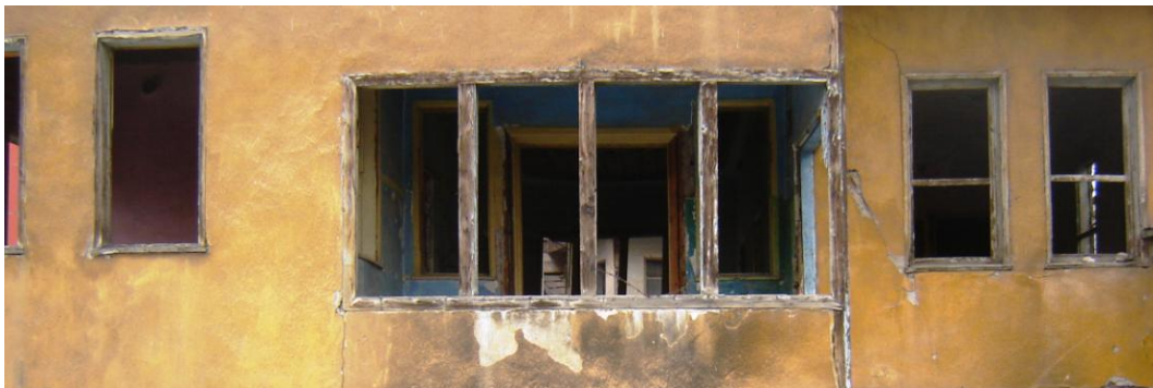
Resim 4.24. Güney cephesindeki PZ2-1, PZ1-1-PZ1-4, PZ2-10 ve PZ2-11 pencereleri, Temmuz 2011 [31]
