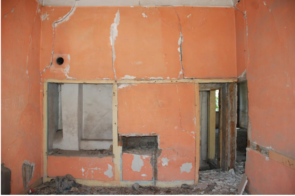
Resim 4.99. 105 mekânı D1 tuğla duvarı, Temmuz 2011 [31]
