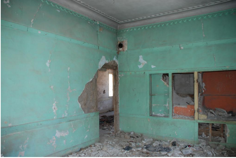
Resim 4.105. 110 mekânı D1 ve D2 duvarları, Temmuz 2011 [31]
