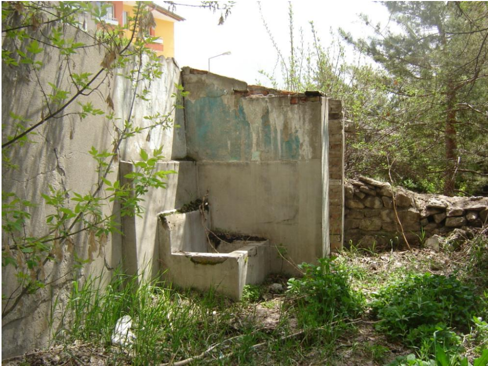
Resim 4.11. Konağın bahçesindeki hela ve çeşme, Temmuz 2011 [31]
