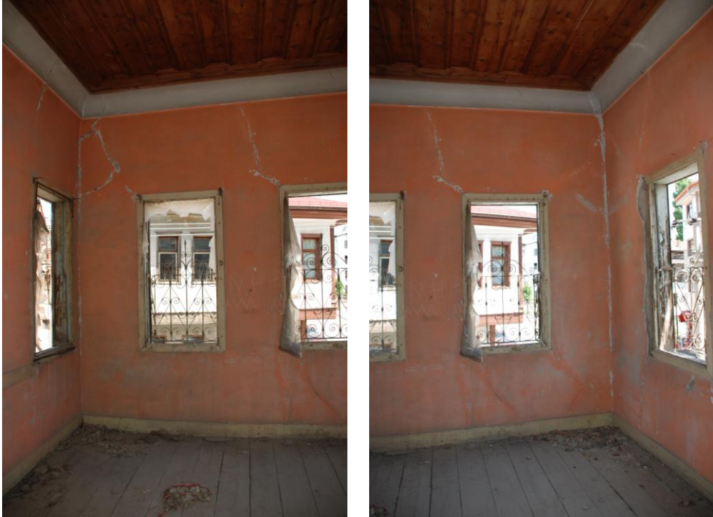
Resim 4.100.-4.101. 105 mekânı D2, D3 ve D4 duvarları, Temmuz 2011 [31]
