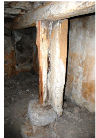
Resim 4.44.-4.45. B03 mekânının tavanı ve mekân içersinde temel taşı üzerinde ahşap dikme, dikme yanında betonarme kolon, Aralık 2011 [31]
