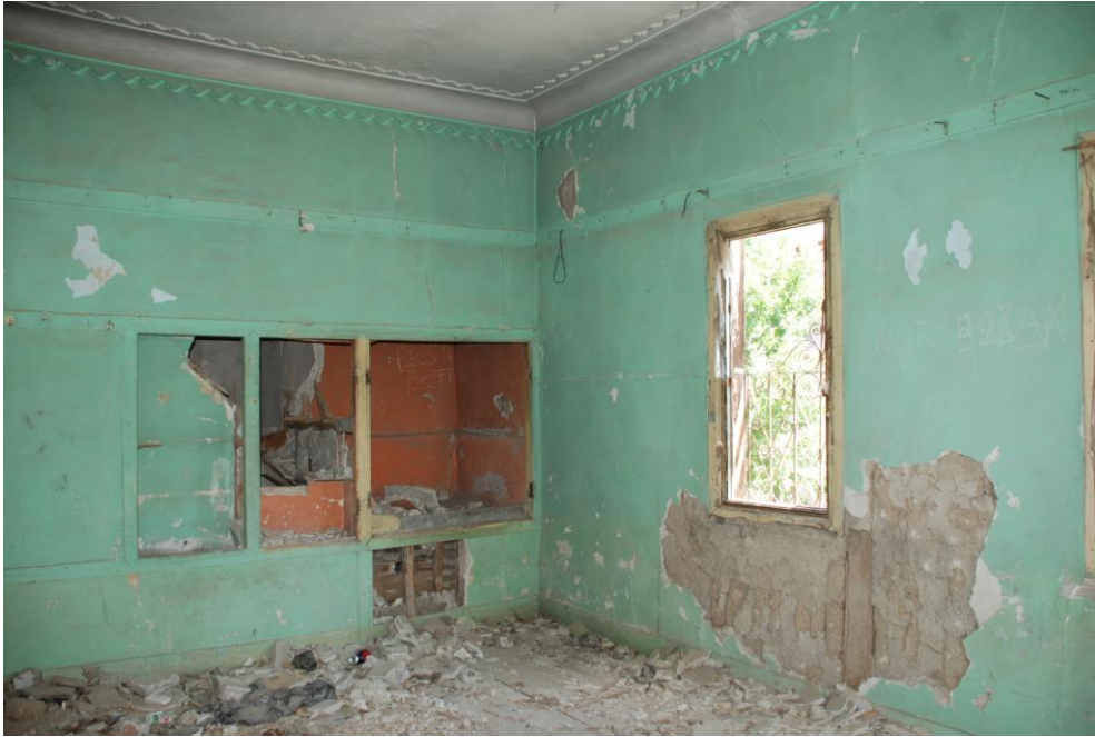
Resim 4.106. 110 mekânı D2 ve D3 duvarları, Temmuz 2011 [31]
