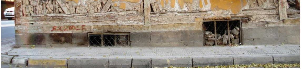
Resim 4.21. Kuzey cephesindeki PB2-2 ve PB3 pencereleri, Temmuz 2011 [31]
