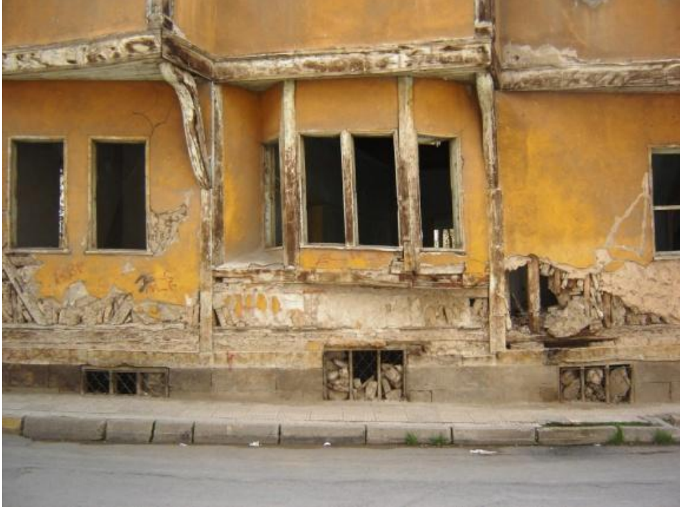
Resim 4.15. Kuzey cephesindeki çokgen ve gönyeli çıkmlar , Temmuz 2011 [31]
