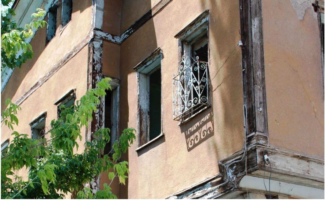
Resim 4.25. Güney cephesindeki PK2-11 ve PK2-12 pencereleri, Temmuz 2011 [31]
