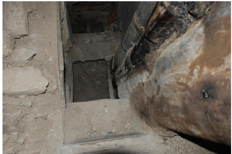
Resim 4.115.- 4.116. Çatı katına çıkan ahşap merdiven kalıntısı ve merdiven yanındaki muhdes bacalar, Temmuz 2011 [31]
