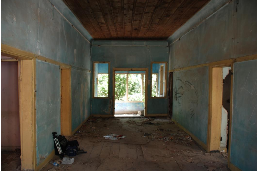
Resim 4.65. Z05 mekânı D1, D2 ve D6 duvarları, Temmuz 2011 [31]
