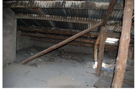
Resim 4.111.- 4.112. Çatı katı ahşap aşıklar, dikmeler ve sac malzeme Temmuz 2011 [31]
