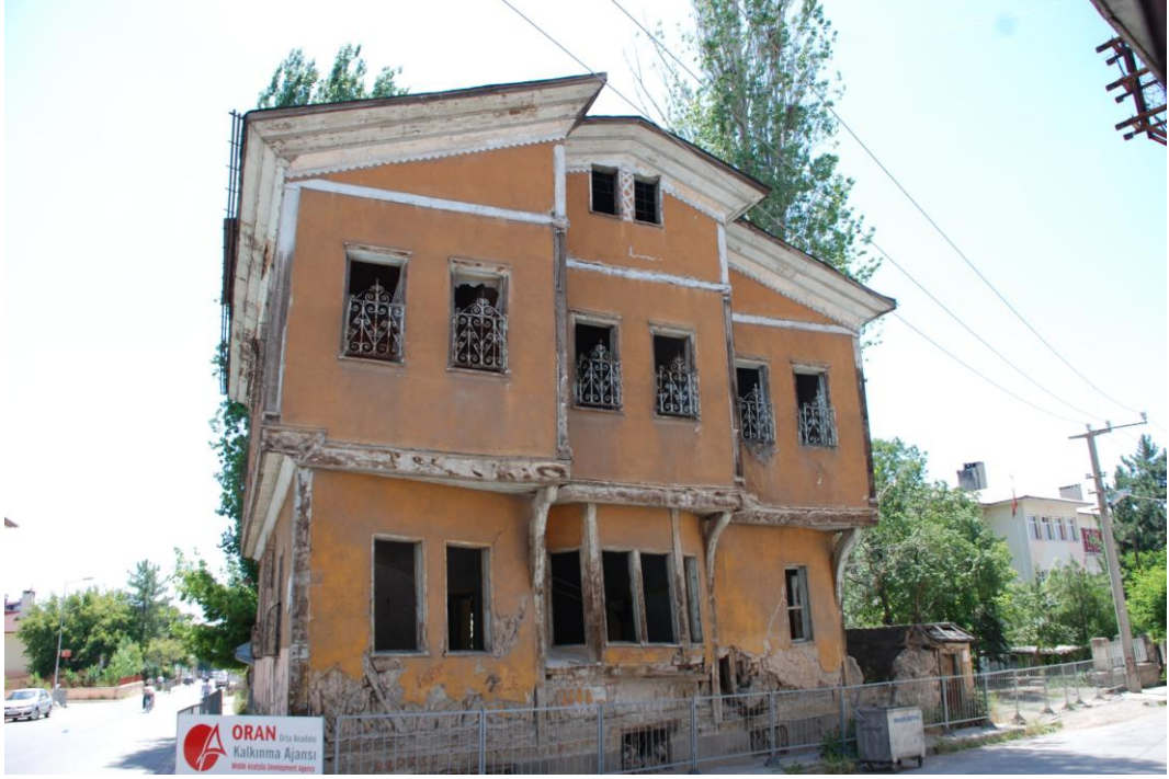
Resim 4.6. Hubuyar KORUCU Konağı kuzey cephesi, Temmuz 2011 [31]
