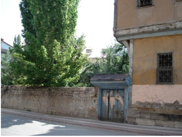
Resim 4.12. Konağın BK1 bahçe giriş kapısı ve bahçe duvarı, Temmuz 2011 [31]
