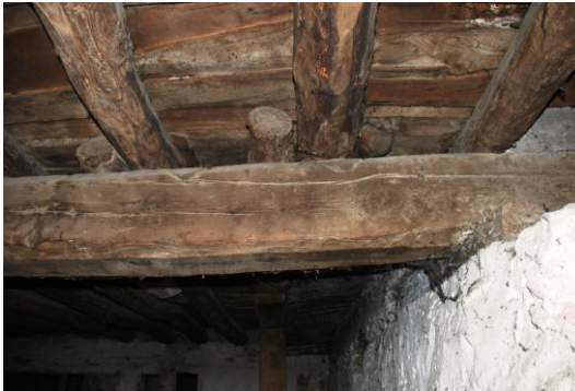
Resim 4.38.-4.39. B01 mekânı ahşap tavan kirişlemeleri ve kirişlemelerdeki böceklenme, Aralık 2011 [31]
