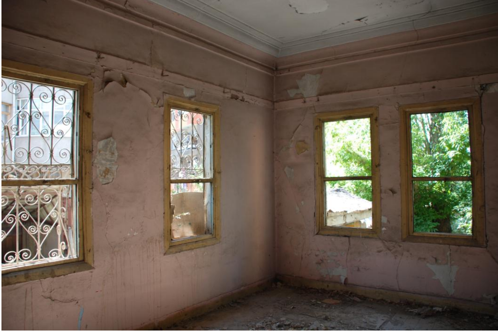
Resim 4.78. Z11 mekânı D3 ve D4 duvarları, Temmuz 2011 [31]
