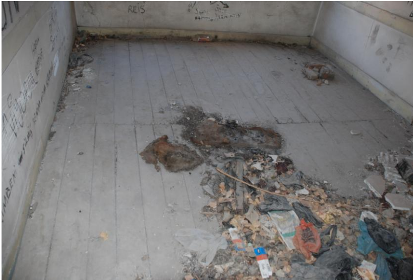
Resim 4.94. 103 mekânı döşeme kaplaması, Temmuz 2011 [31]
