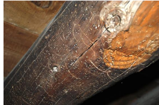
Resim 4.38.-4.39. B01 mekânı ahşap tavan kirişlemeleri ve kirişlemelerdeki böceklenme, Aralık 2011 [31]
