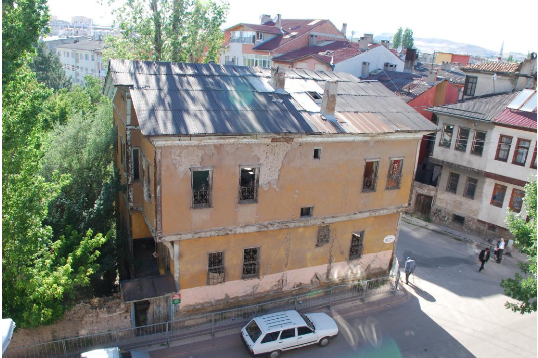
Resim 4.3. Hubuyar KORUCU Konağı'nın genel görünümü-3, Temmuz 2011 [31]
