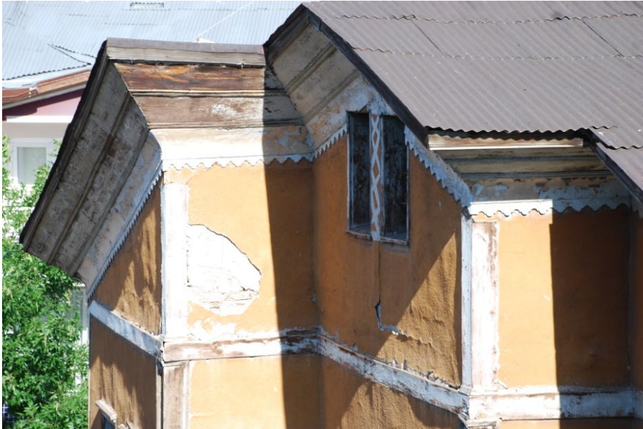
Resim 4.33. Güney cephesi saçak silmeleri, ahşap frizler ve çatı katı pencereleri, Temmuz 2011 [31]
