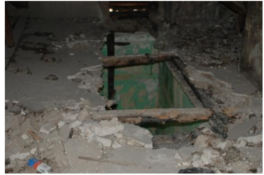
Resim 4.113.- 4.114. Çatı katı pencereleri döşemedeki yangın hasarlı bölüm, Temmuz 2011 [31]
