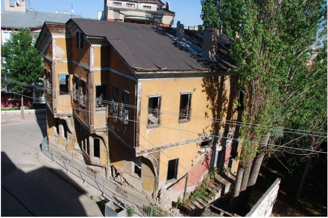
Resim 4.2. Hubuyar KORUCU Konağı'nın genel görünümü-2, Temmuz 2011 [31]
