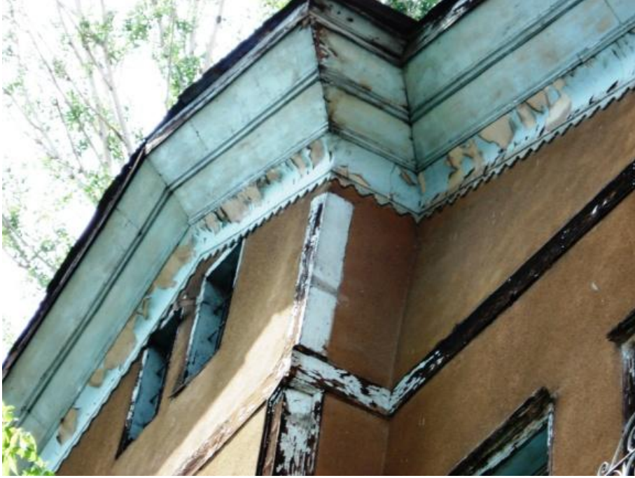
Resim 4.32. Güney cephesi saçak silmeleri, ahşap frizler ve çatı katı pencereleri, Temmuz 2011 [31]
