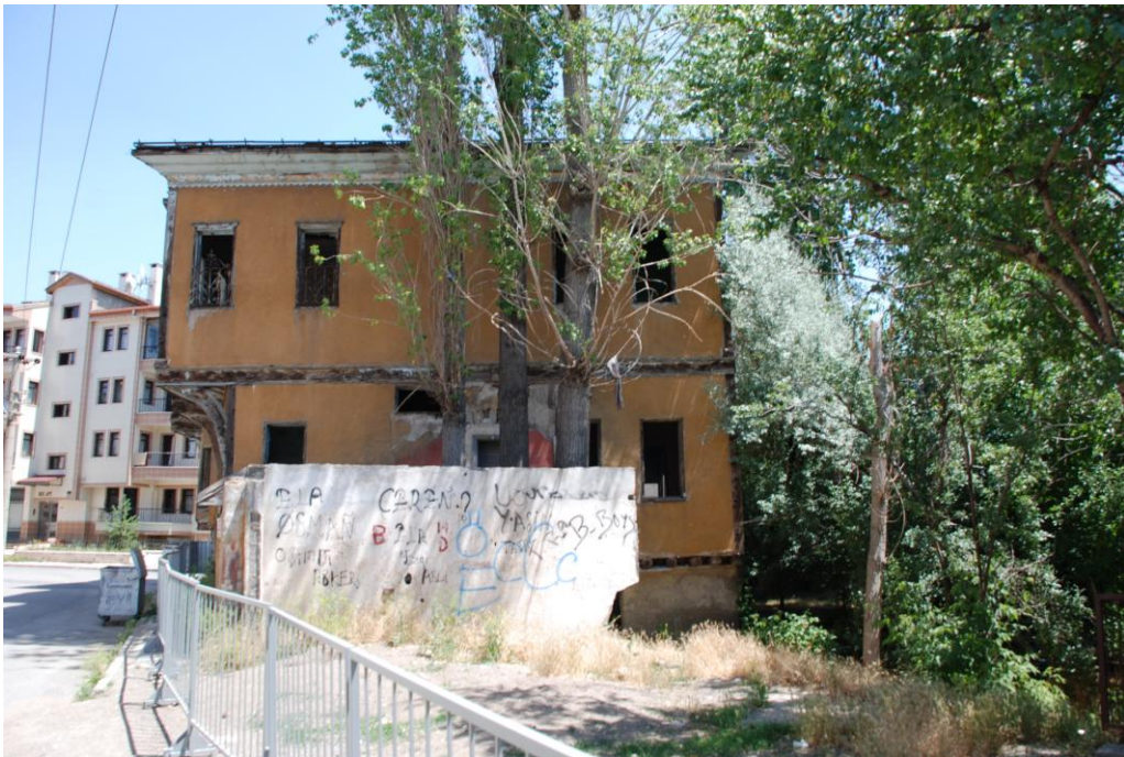
Resim 4.9. Hubuyar KORUCU Konağı batı cephesi, Temmuz 2011 [31]
