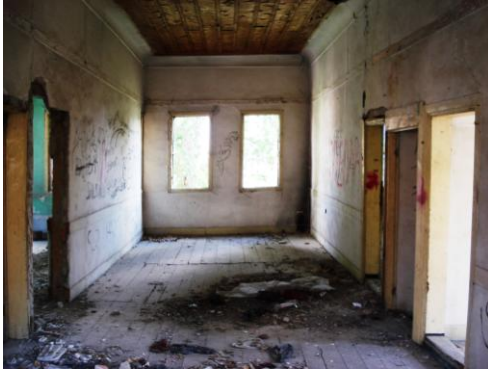
Resim 4.92.-4.93. 103 mekânı D4 duvarı ve tavanın yangın hasarlı bölümü, Temmuz 2011 [31]
