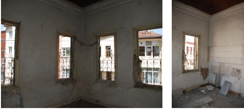
Resim 4.86.-4.87. 101 mekânı D3 ve D4 duvarları ile pencereler, Temmuz 2011 [31]
