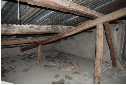
Resim 4.111.- 4.112. Çatı katı ahşap aşıklar, dikmeler ve sac malzeme Temmuz 2011 [31]
