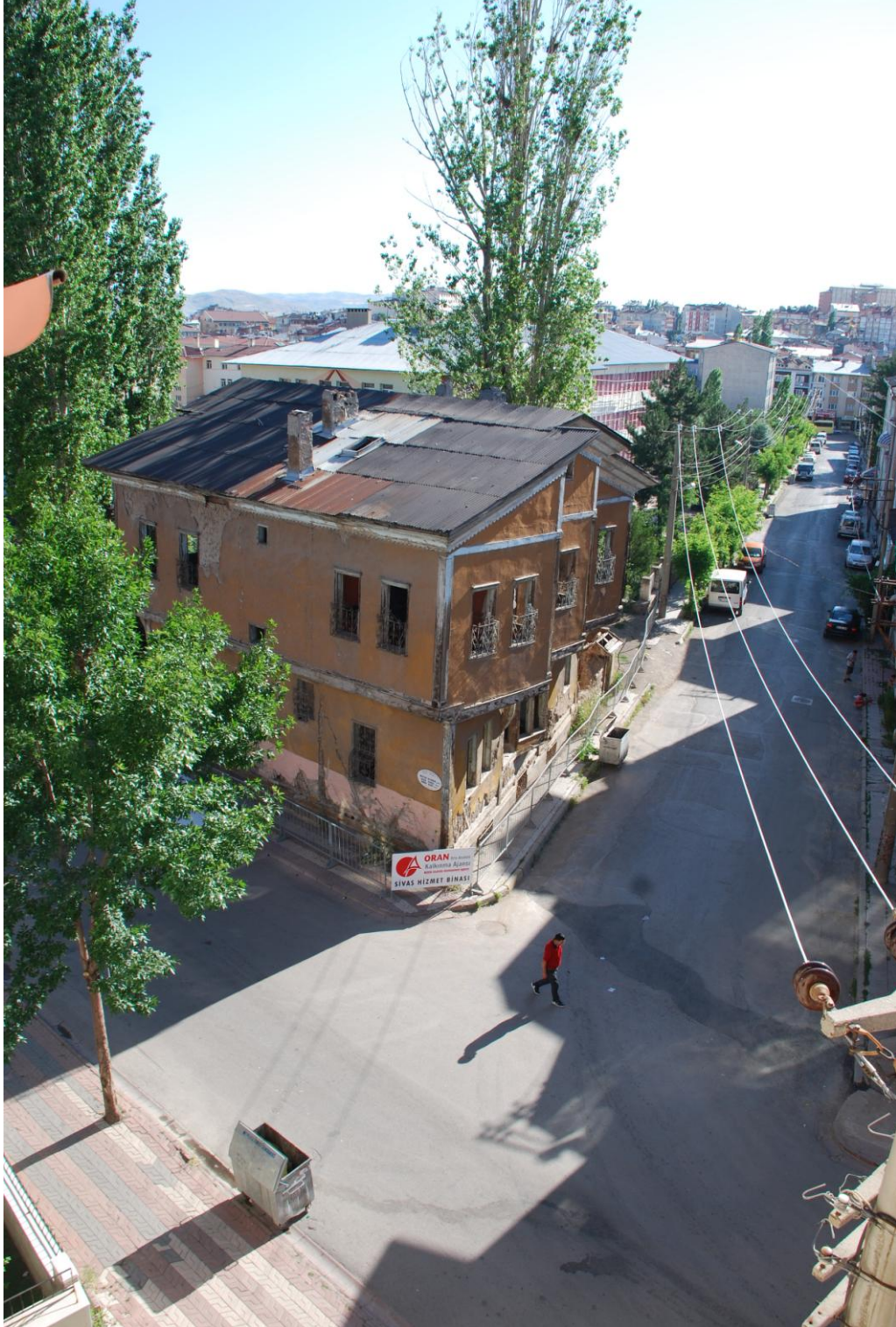
Resim 4.1. Hubuyar KORUCU Konağı'nın genel görünümü-1, Temmuz 2011 [31]
