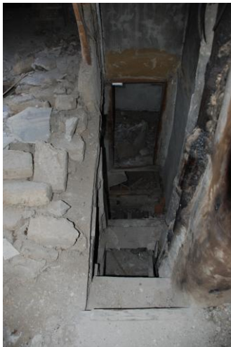
Resim 4.115.- 4.116. Çatı katına çıkan ahşap merdiven kalıntısı ve merdiven yanındaki muhdes bacalar, Temmuz 2011 [31]
