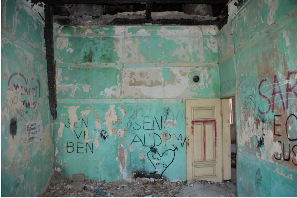
Resim 4.80. 101 mekânına giriş, D4 duvarı ve KK1 kapısı, Temmuz 2011 [31]
