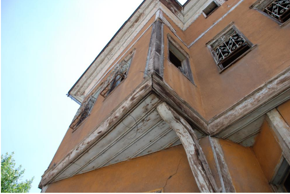
Resim 4.17. Kuzey cephesi çıkma altı ahşap kaplama ve göğüsleme-2 , Temmuz 2011 [31]
