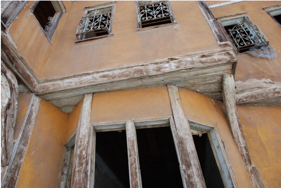
Resim 4.16. Kuzey cephesi çıkma altı ahşap kaplama ve göğüsleme-1 , Temmuz 2011 [31]
