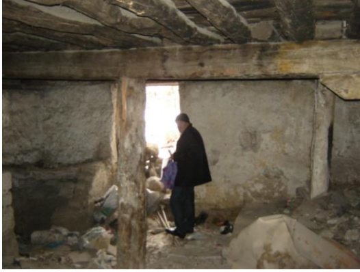
Resim 4.34.-4.35. B01 mekânı D1 ve D2 duvarları ve D2 duvarının olduğu bölümde sonradan kaldırılan merdiven boşluğu, Aralık 2011 [31]
