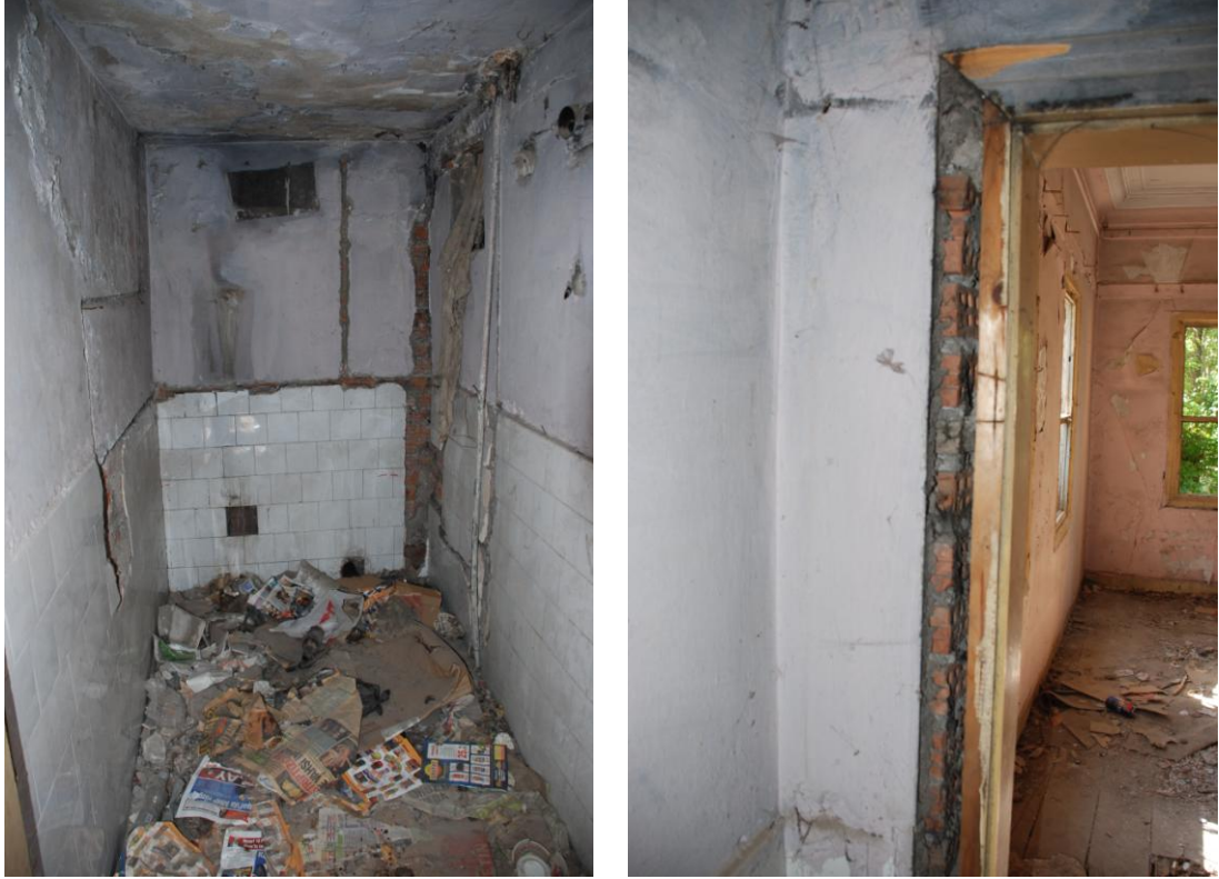
Resim 4.75.-4.76. Muhdes Z10 mekânı ve Z11 mekânı ile arasındaki muhdes tuğla duvar, Temmuz 2011 [31]
