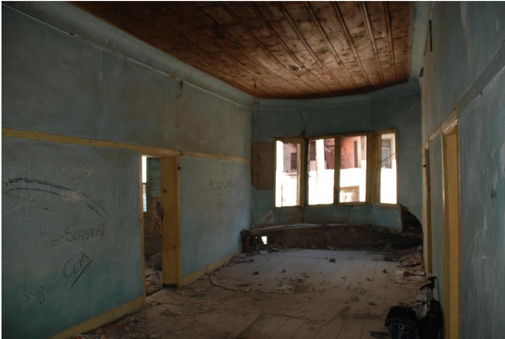
Resim 4.66. Z05 mekânı D2, D3, D4 ve D5 duvarları ve sedir kalıntısı, Temmuz 2011 [31]
