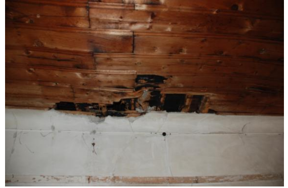
Resim 4.92.-4.93. 103 mekânı D4 duvarı ve tavanın yangın hasarlı bölümü, Temmuz 2011 [31]
