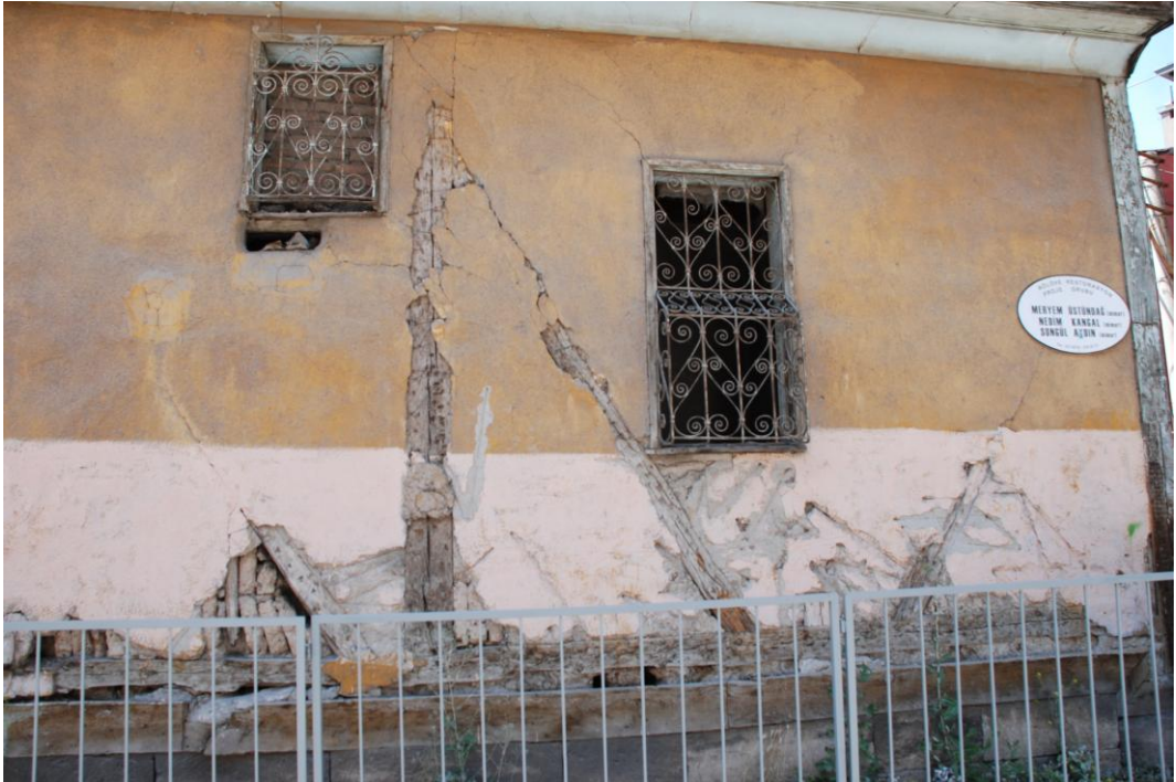
Resim 4.26. Doğu cephesindeki PK6 ve PK2-7 pencereleri, Temmuz 2011 [31]
