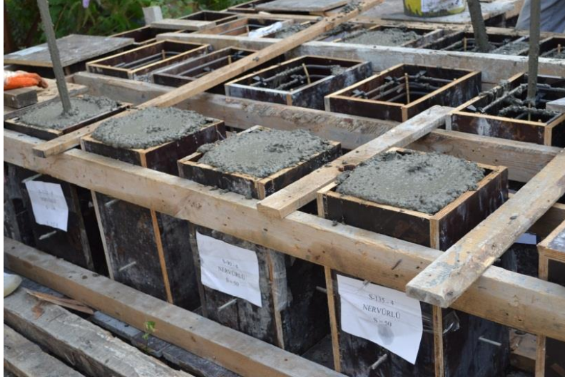
Şekil 4.18: Yanal(etriye) donatısı yerleştirilen kalıplara beton dökümü
