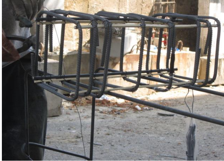
Şekil 4.11: Etriyelerin çıtalarla bağlanması
