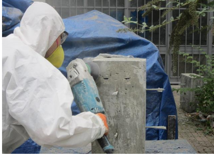
Şekil 4.20: Pahlama işlemi yapılırken
