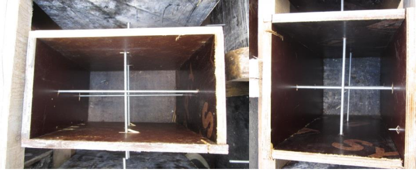
Şekil 4.17: Tijlerin kalıplara yerleştirilmesi
