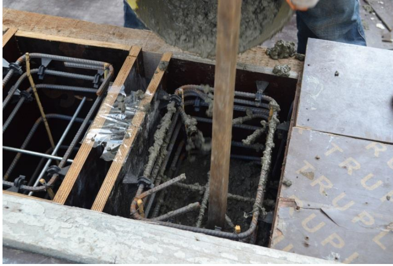
Şekil 4.19: Beton dökümü ve şişlemenin yapılması
