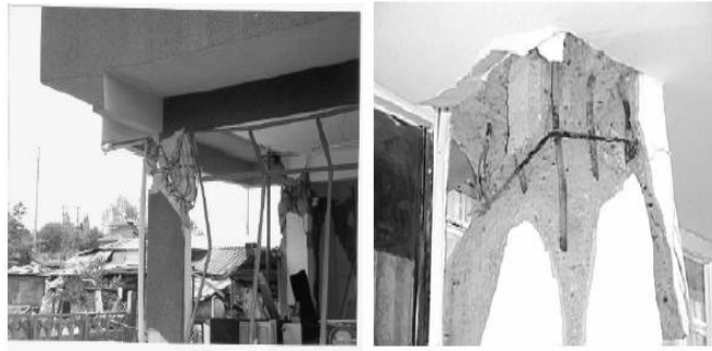
Şekil 2.9: Kolon-Kiriş birleşiminde donatı kusurları (İzmit,1999)
