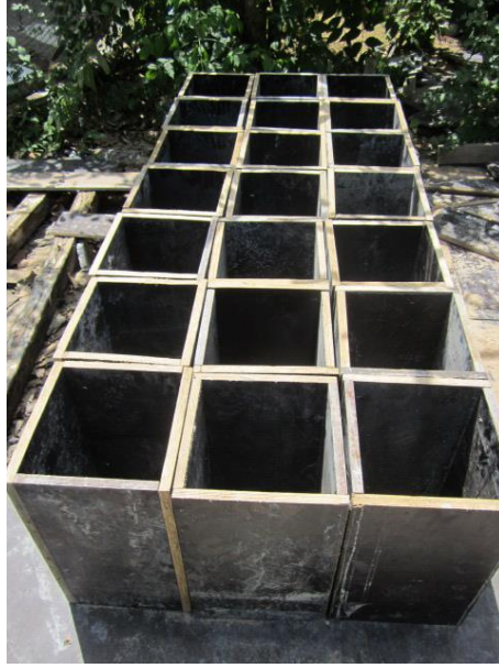
Şekil 4.24: Hazırlanan kalıplar
