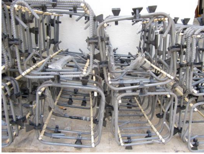
Şekil 4.26: Kalıplara konulmaya hazır yanıl(etriye) donatılar
