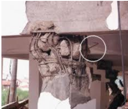
Şekil 2.7: Sıklaşıma bölgelerindeki yetersiz enine donatı (Yalova, 1999)
