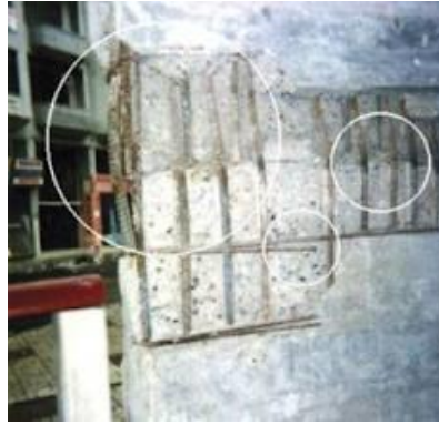
Şekil 2.6: Yetersiz enine donatılar ve boyuna donatıda burkulma (Yalova, 1999)
