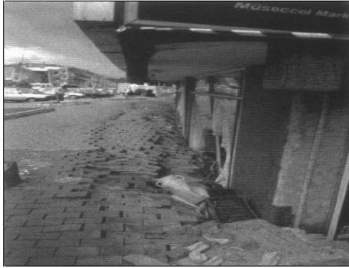
Şekil 2.17. Zımbalama göçmesi ve yük-oturma eğrisi (Çinicioğlu, 2005).
