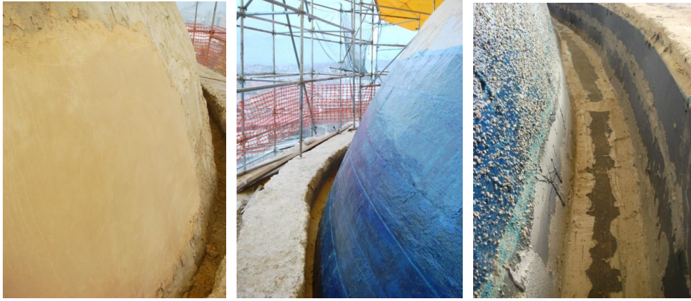
Resim 4.24. Mustafa Paşa Camii kubbede karbon lif uygulaması, 2007 [55]
