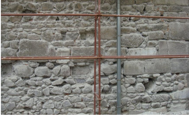
Resim 4.3.a. Ankara Altındağ Arslanhane Camii boşaltılmış derzleri, 2010 [5]
