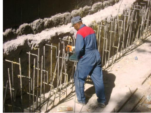
Resim 4.55. Açılan enjeksiyon delikleri ve hortumlar ve enjeksiyonun basıldığı makine, 2010 [5]
