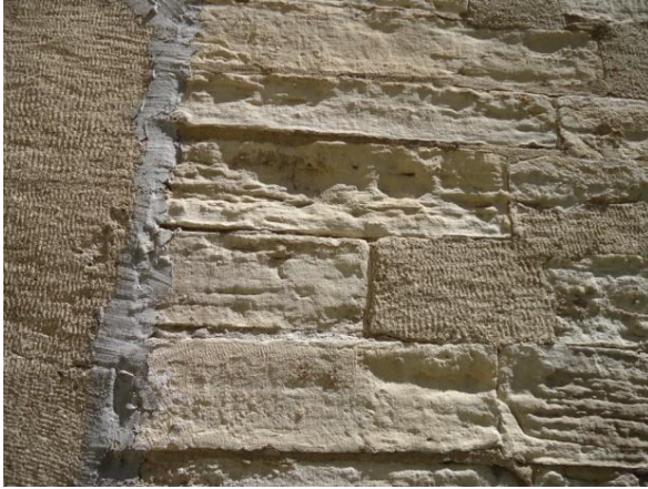
Resim 2.26. Çankırı Ulu Camii payanda yüzeylerinde ufalanma, 2011 [34]
