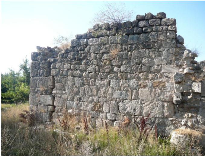
Resim 2.16. Isparta Ertokuş Han duvarlarında ayrılma, 2007 [6]
