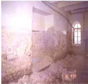
Resim 4.25. İstanbul, Kabataş Erkek Lisesi duvarlara çelik hasır ve ankrajların yerleştirilmesi ve püskürtme betonunun tamamlanması [39]
