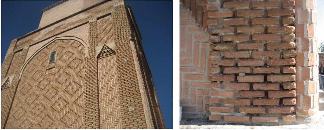
Resim 2.11. Kayseri Melikgazi Türbesi derz boşalması örnekleri, 2011 [44]
