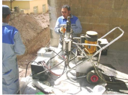
Resim 4.55. Açılan enjeksiyon delikleri ve hortumlar ve enjeksiyonun basıldığı makine, 2010 [5]
