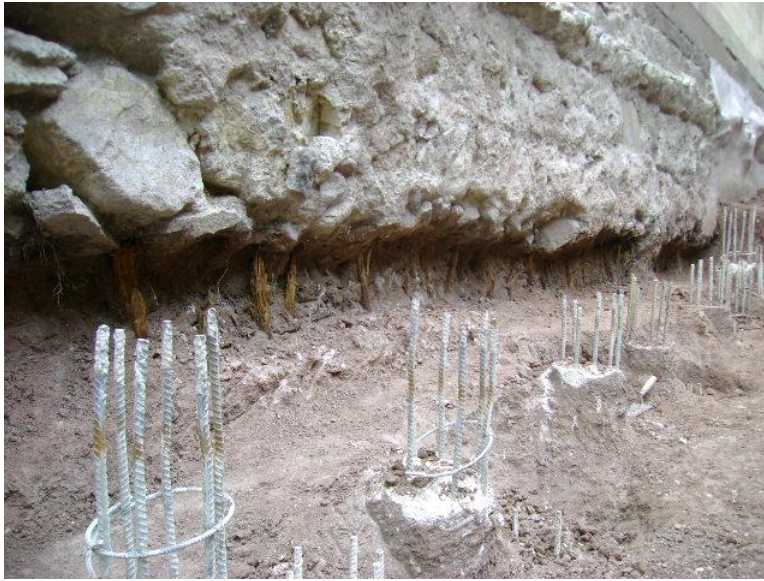
Resim 4.52. Kazı sırasında ortaya ıkan ahřap kazıklar ve yeni imalatı yapılan mini kazıklar, 2010 [5]
