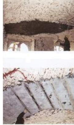
Resim 4.20. İstanbul Hazine-i Evrak binası yapısal çatlakların karbon fiber ile onarılması [10]
