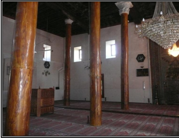
Resim 2.18. Ankara Arslanhane Camii, şakülünden sapan ahşap sütunlar, 2008 [5]
