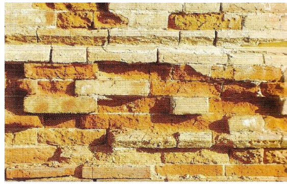
Resim 2.27. Duvar yüzeylerinde bozulma ve ufalanmalar [23]
