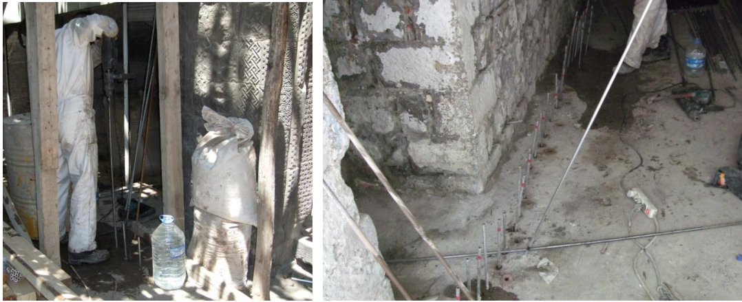
Resim 4.44. Diyarbakır Melik Ahmet Camii kimyasal enjeksiyon işlemi, 2008 [25]
