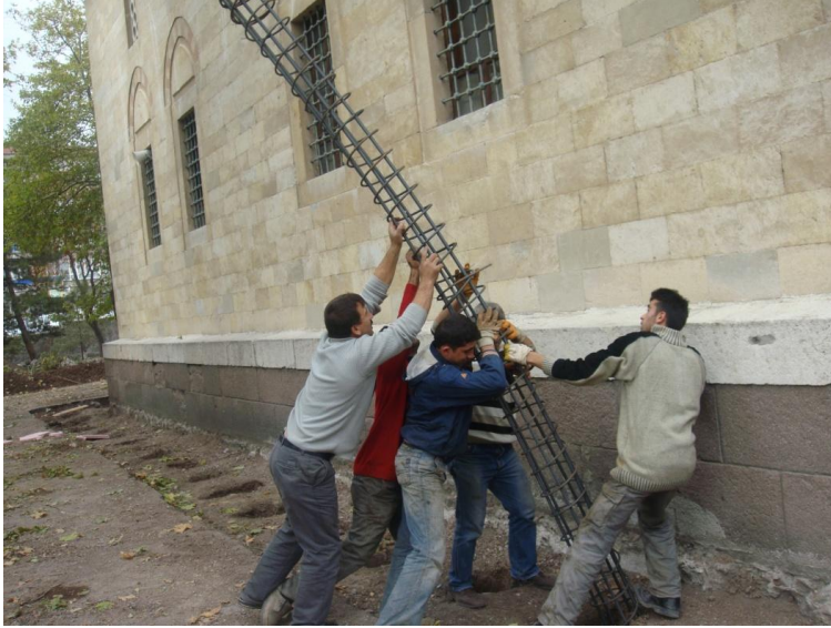
Resim 4.50. Mini kazık donatısının yerleştirilişi, 2009 [5]
