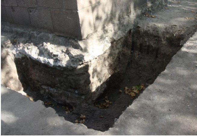
Resim 4.47. Açılan gözlem çukuru, 2009 [5]
