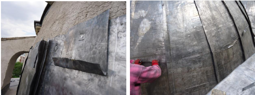
Resim 4.23. Kurşun örtü yapılması, 2011 [5]
