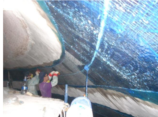
Resim 4.21. İstanbul Yavuz Sultan Selim Camii karbon fiber uygulaması, 2008 [9]
