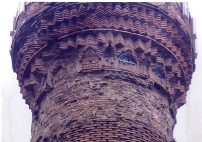
Resim 2.12. Sivas Ulu Camii minare şerefesi parça kopmaları ve ayrışmalar, 2007 [15]
