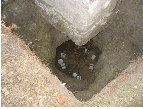
Resim 4.41. Geleneksel yöntemle çukur açılması [68]
