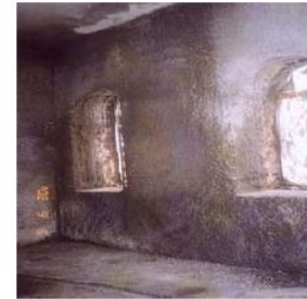
Resim 4.25. İstanbul, Kabataş Erkek Lisesi duvarlara çelik hasır ve ankrajların yerleştirilmesi ve püskürtme betonunun tamamlanması [39]
