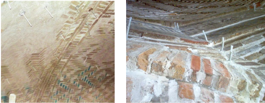
Resim 4.8. Malatya Battalgazi Camii mekanik dikiş uygulaması, 2005 [40]
