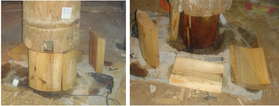
Resim 4.2. Ankara Arslanhane Camii ahşap sütunlarda kısmi tamamlama, 2011 [5]
