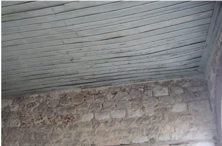
Resim 2.17. Edirne Atik Ali Paşa Camii ahşap tavanının sehimi yapması, 2011 [44]
