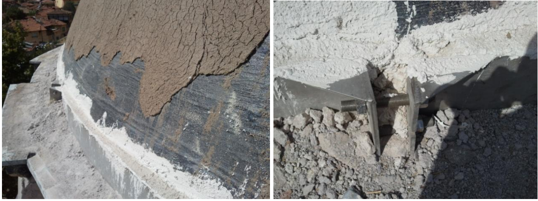
Resim 4.22.a. Paslanmaz gergi ve siliskumu ile kumlama, 2010 [5] Resim 4.22.b. Birleşim yeri bulonları, 2010 [5]
