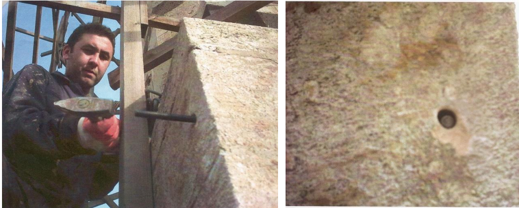
Resim 4.9. Adana Ulu Camii ankraj tijinin atılması ve çakılmış hali [1]
