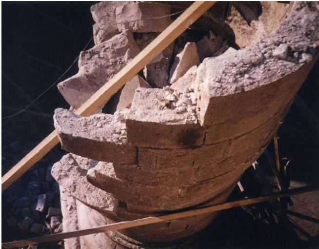
Resim 2.22. Ayvalık Çınarlı Camii rüzgâr sonucu yıkılan minare, 2002 [15]
