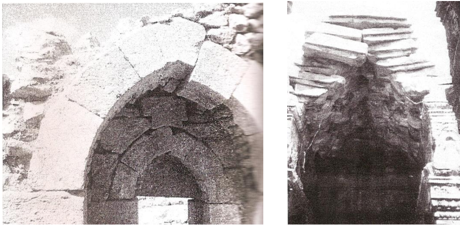
Resim 2.14. Kemerlerde kayma problemi [17]
