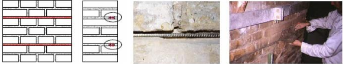
Şekil 4.2. Donatılı derzleme [36]
