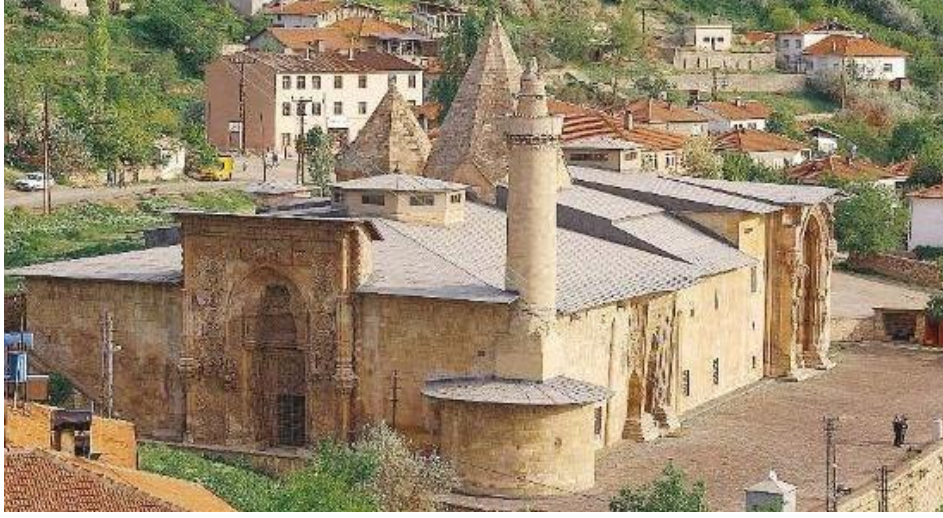
Resim 4.26. Sivas Divriği Ulu Camii minare kaidesinde genişletme [67]
