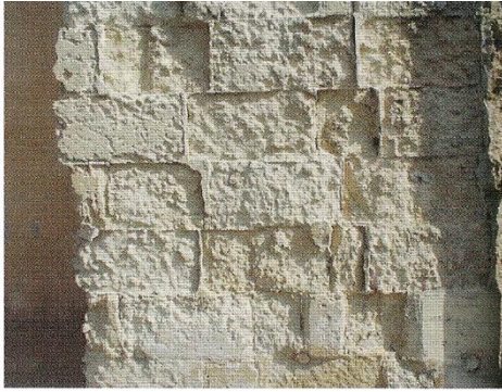
Resim 2.27. Duvar yüzeylerinde bozulma ve ufalanmalar [23]
