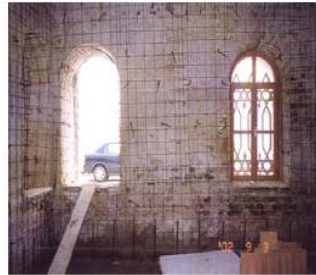
Resim 4.25. İstanbul, Kabataş Erkek Lisesi duvarlara çelik hasır ve ankrajların yerleştirilmesi ve püskürtme betonunun tamamlanması [39]
