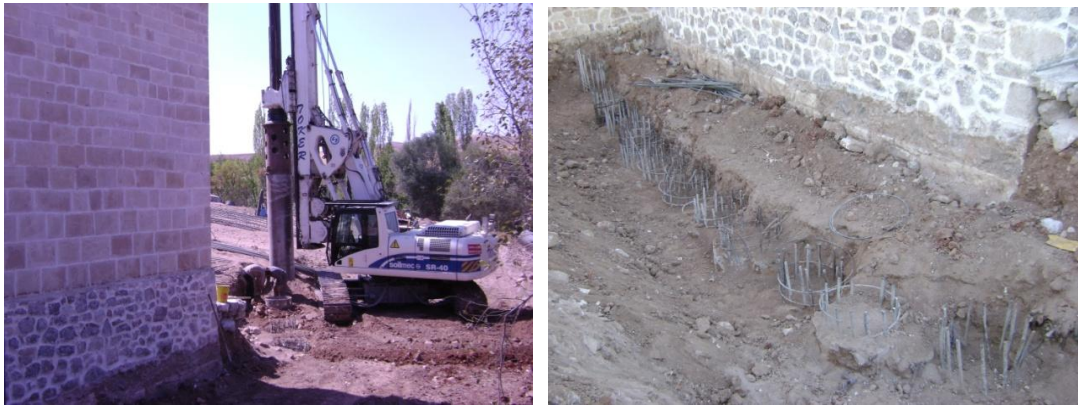
Resim 4.46. Kırıkkale Yeşilyazı Camii fore kazık uygulamaları, 2007 [5]
