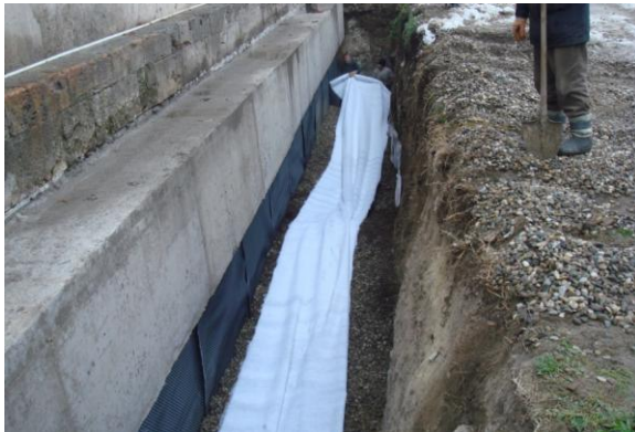
Resim 4.40. Üsküp Mustafa Paşa Camii drenaj çalışması, 2007 [55]
