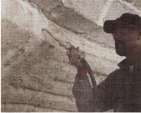
Resim 4.5. İstanbul, Edirnekapı Mihrimah Sultan Camii enjeksiyon işlemi, 2009 [33]
